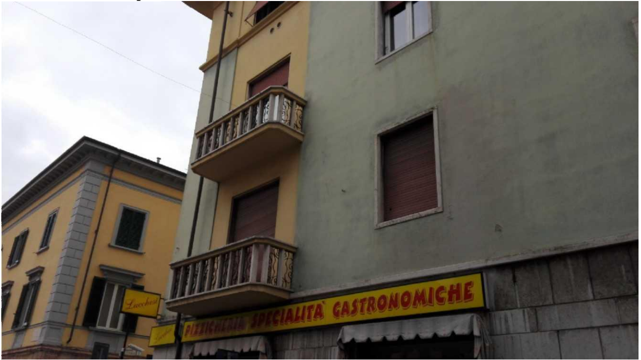
Facciata su via Crispi
