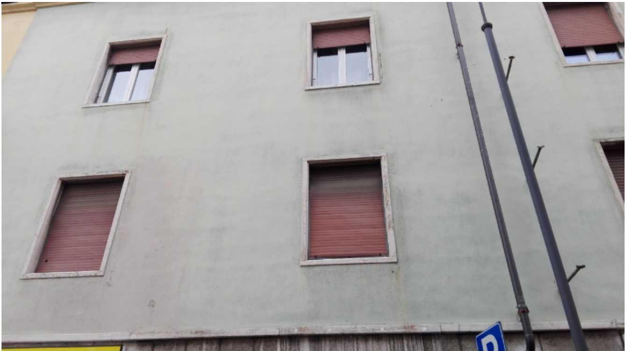
Facciata su via Crispi
