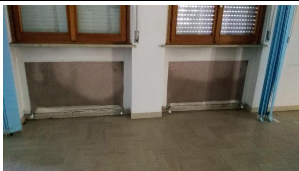
Piano primo – radiatori distaccati
