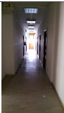
Piano primo – corridoi
