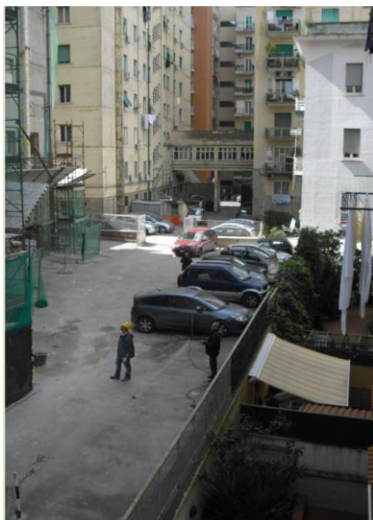
PARTICOLARE CORTILE INTERNO
