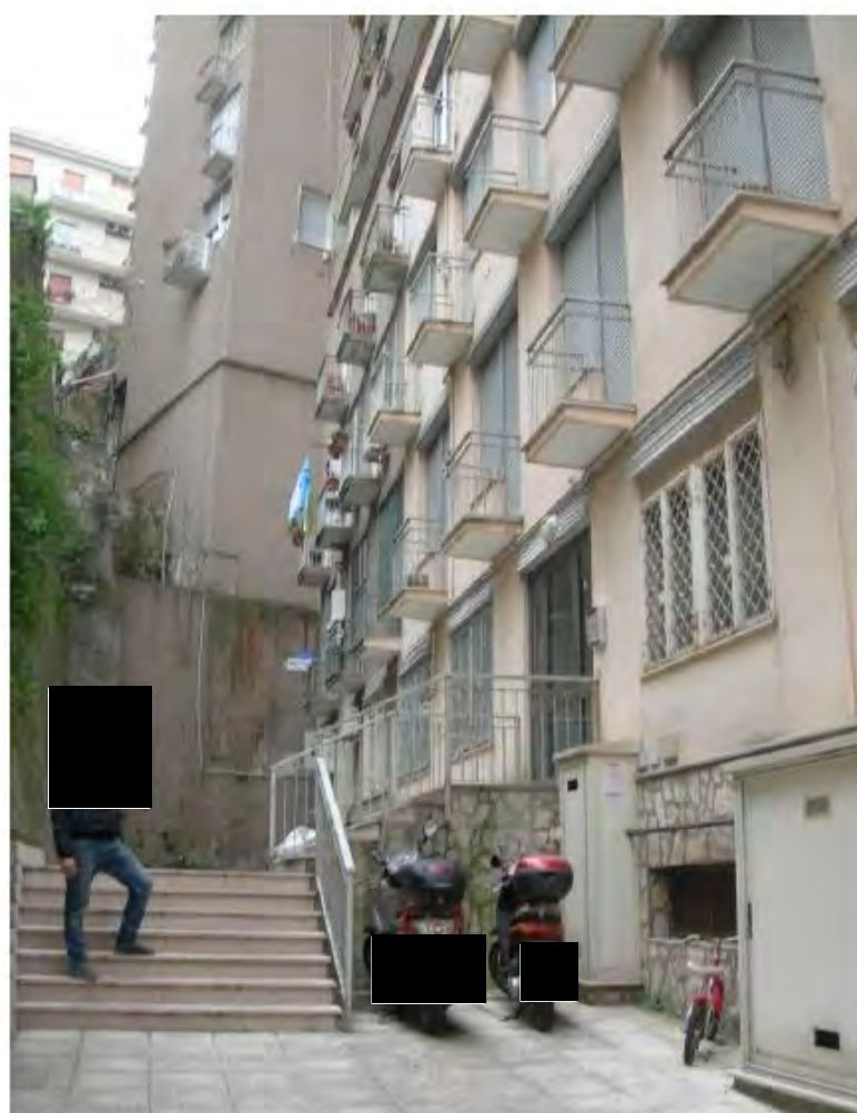
Scala esterna di accesso
