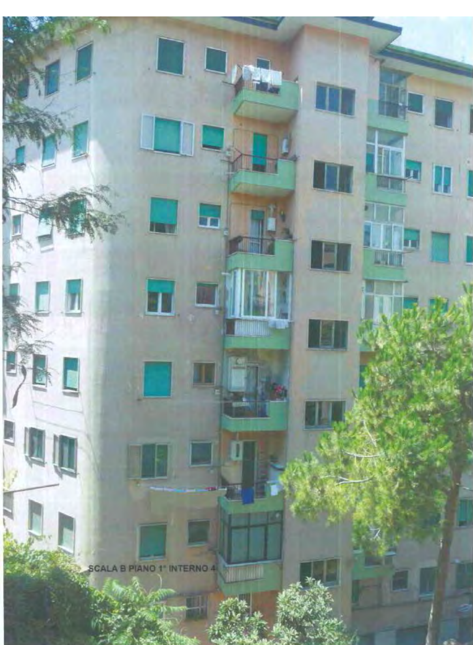
Prospetto Lato Trincerone
