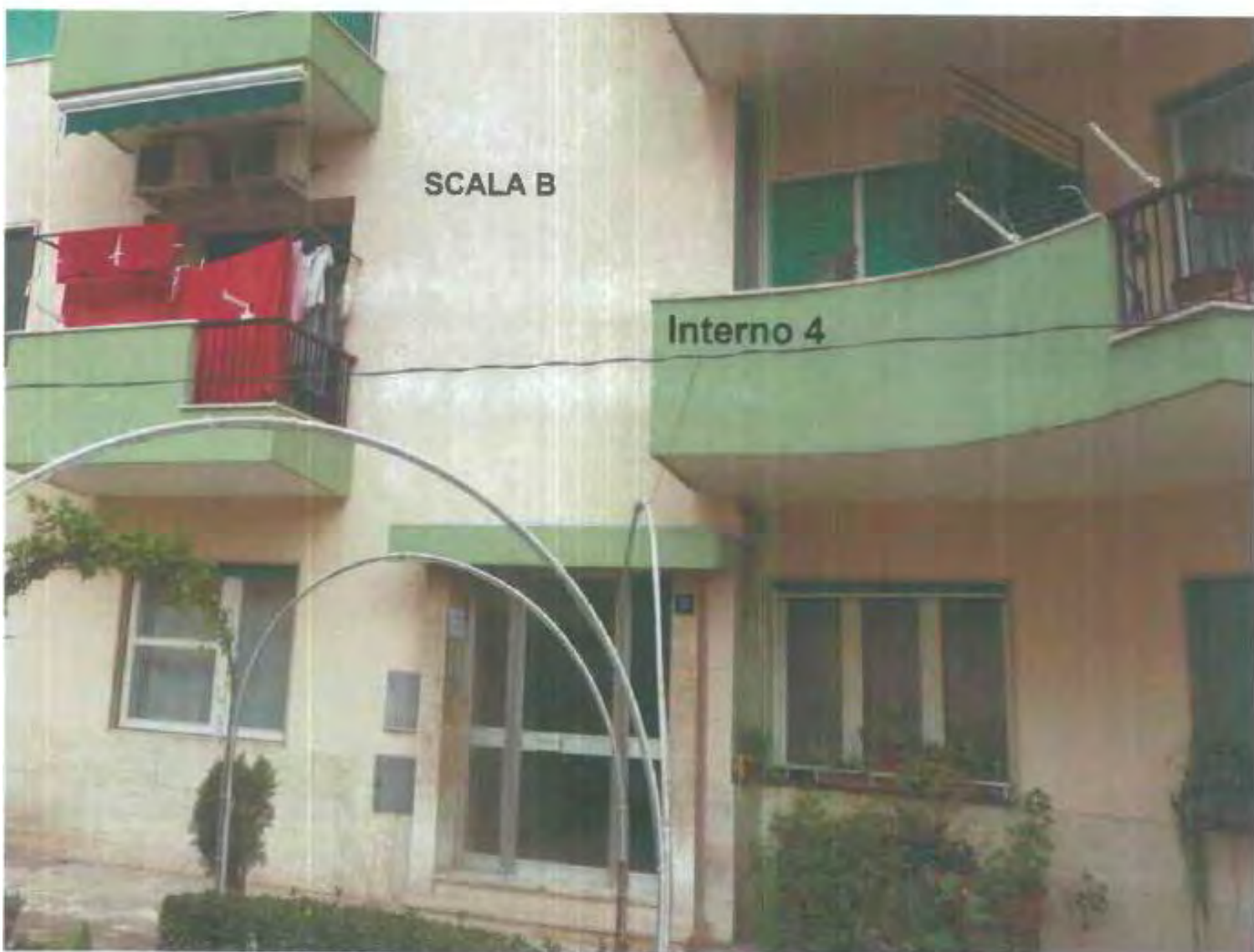
Prospetto Lato Cortile Via Arce – Particolare affacci appartamento
