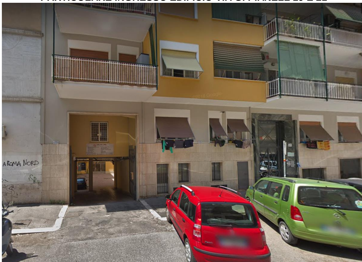
PARTICOLARE INGRESSO EDIFICIO VIA G. PIANELL 19 E 21
