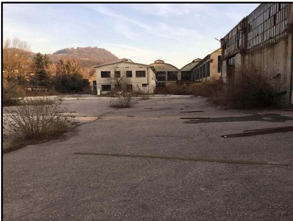
FOTO 128 – Vista palazzina uffici facciata nord
