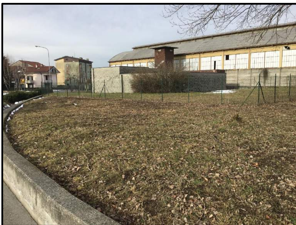
FOTO 82 – Vista dall'esterno edificio F e cabina Enel
