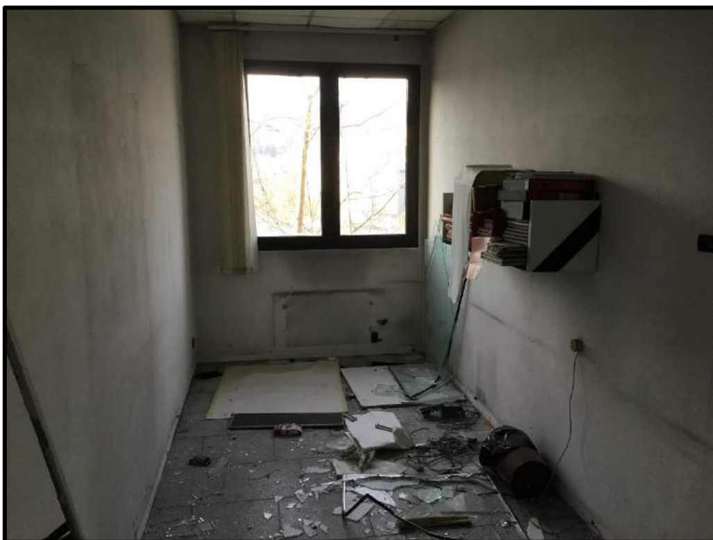
FOTO 100 – Vista interna palazzina uffici edificio D
