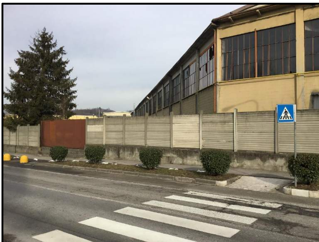
FOTO 87 – Edificio F visto dalla Via Provinciale per Sirone
