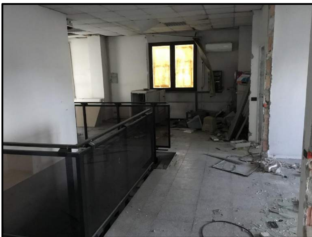
FOTO 102 – Vista interna palazzina uffici edificio D
