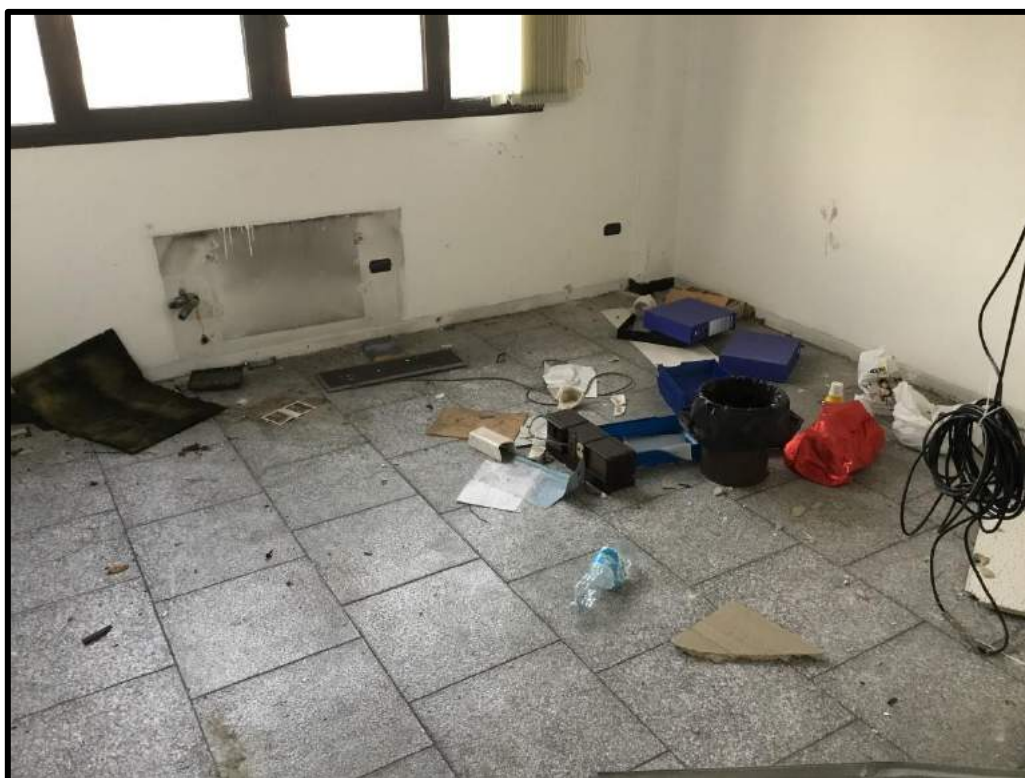
FOTO 93 – Vista interna edificio H
