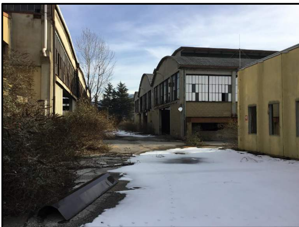
FOTO 44 – Vista edifici N, R e F
