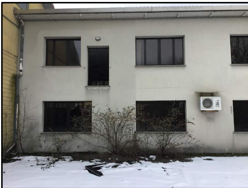
FOTO 70 – Vista facciata parziale edificio D
