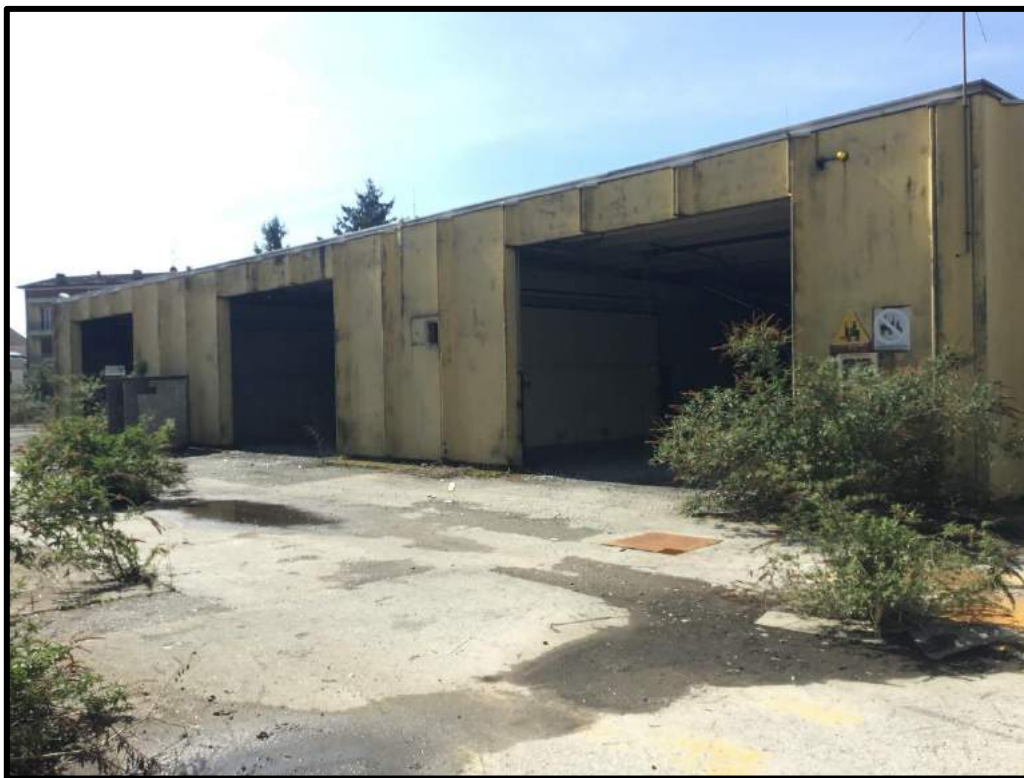
FOTO 149 – Vista edificio N
