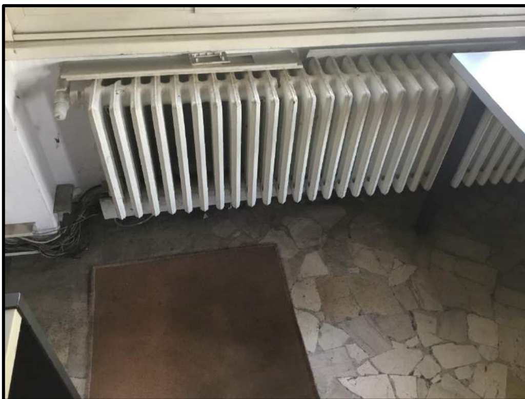
FOTO 130 – Particolare interno portineria
