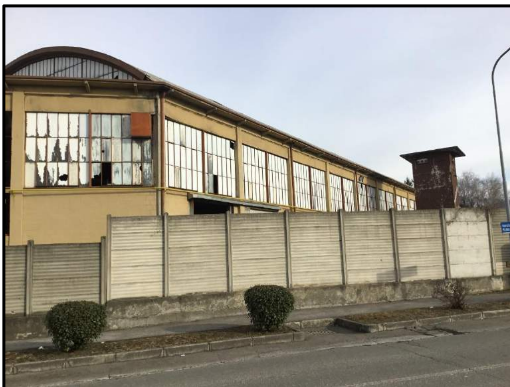
FOTO 85 – Edificio F visto dall'esterno della recinzione da Via Provinciale per Sironè
