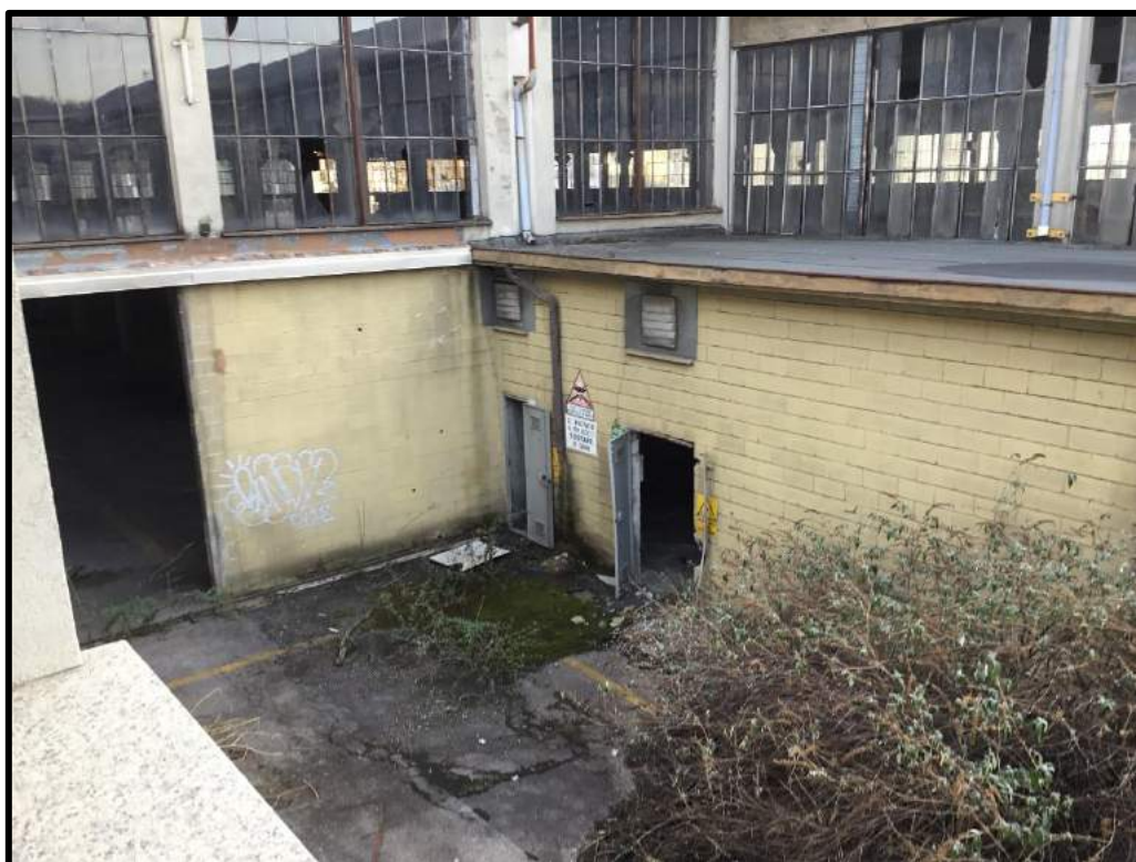
FOTO 111 – Vista edificio E dalla palazzina edificio D
