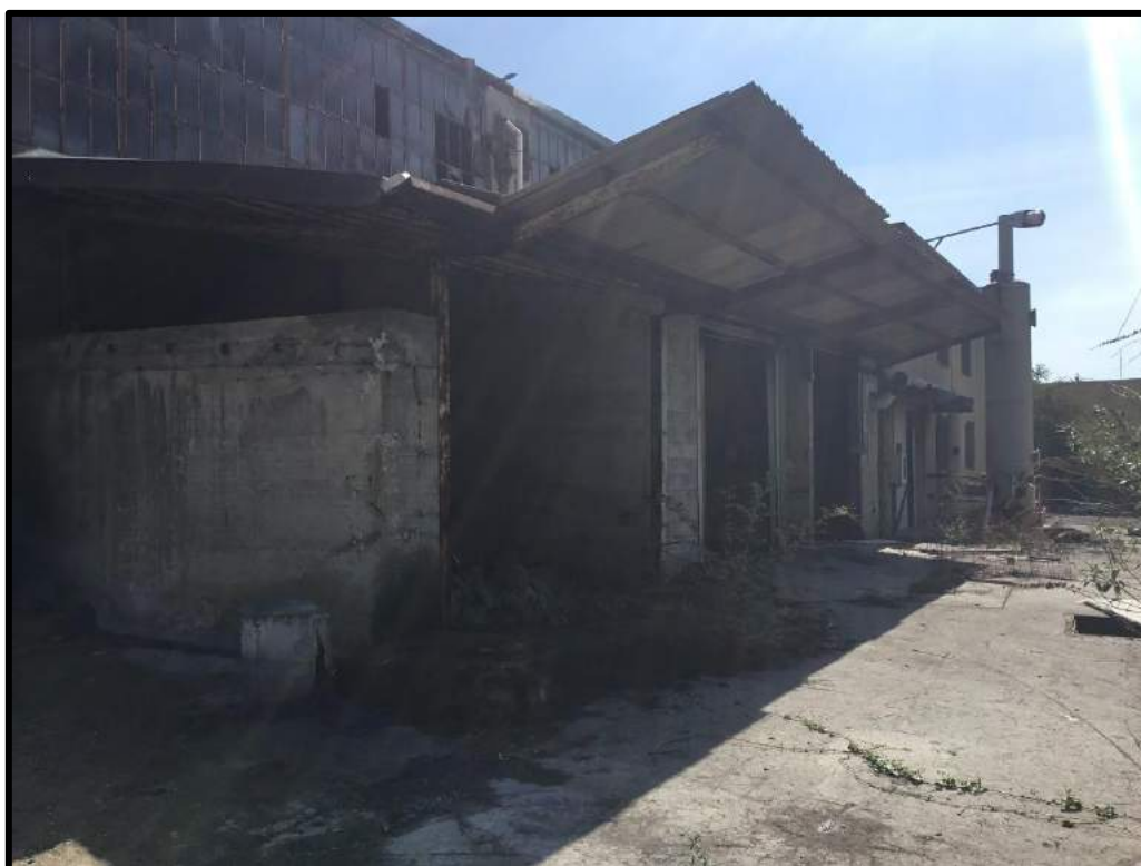
FOTO 153 – Vista esterna edificio Q
