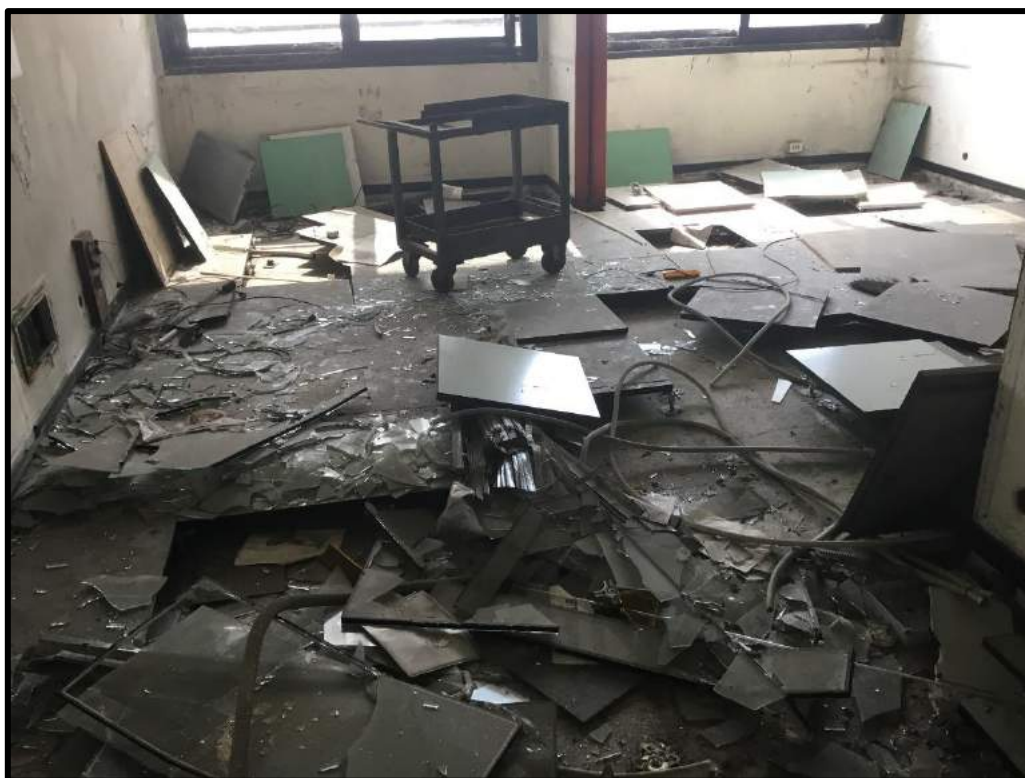
FOTO 166 – Vista interna edificio H
