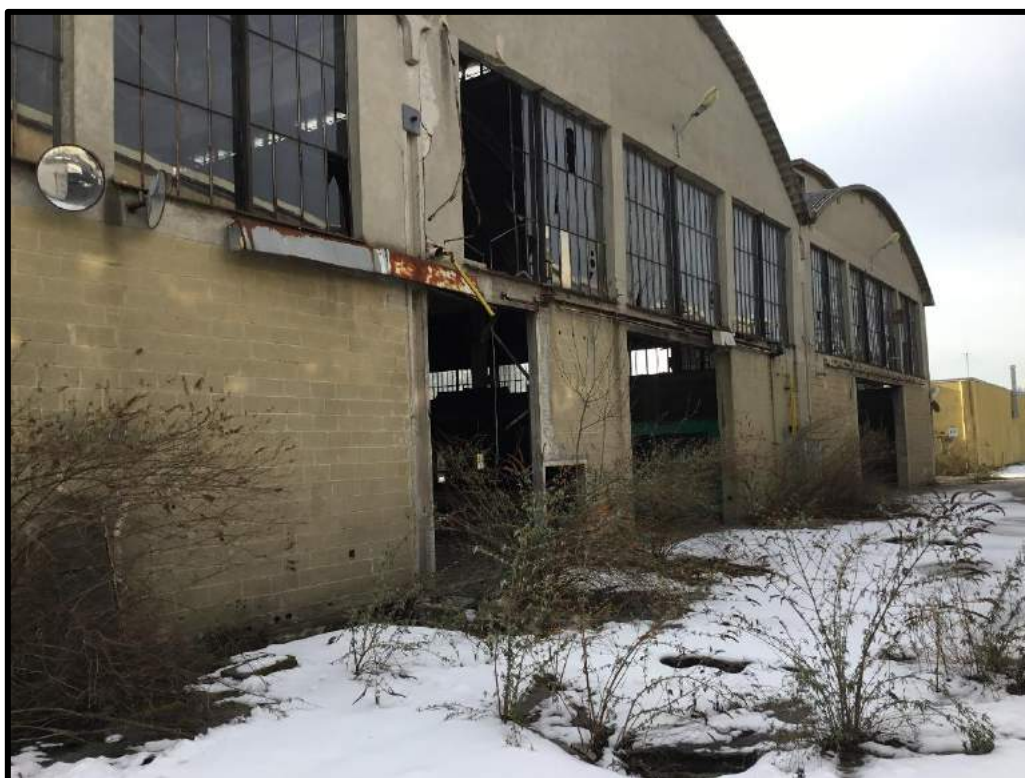
FOTO 63 – Vista esterna edificio F
