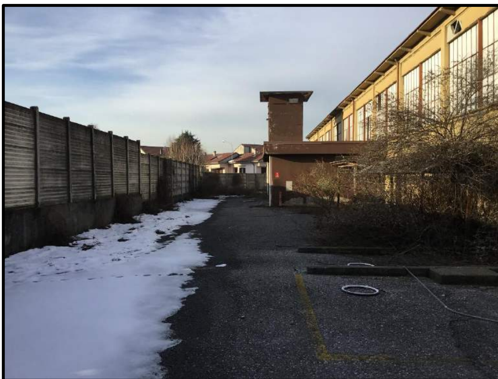
FOTO 4 – Vista lato est edificio F
