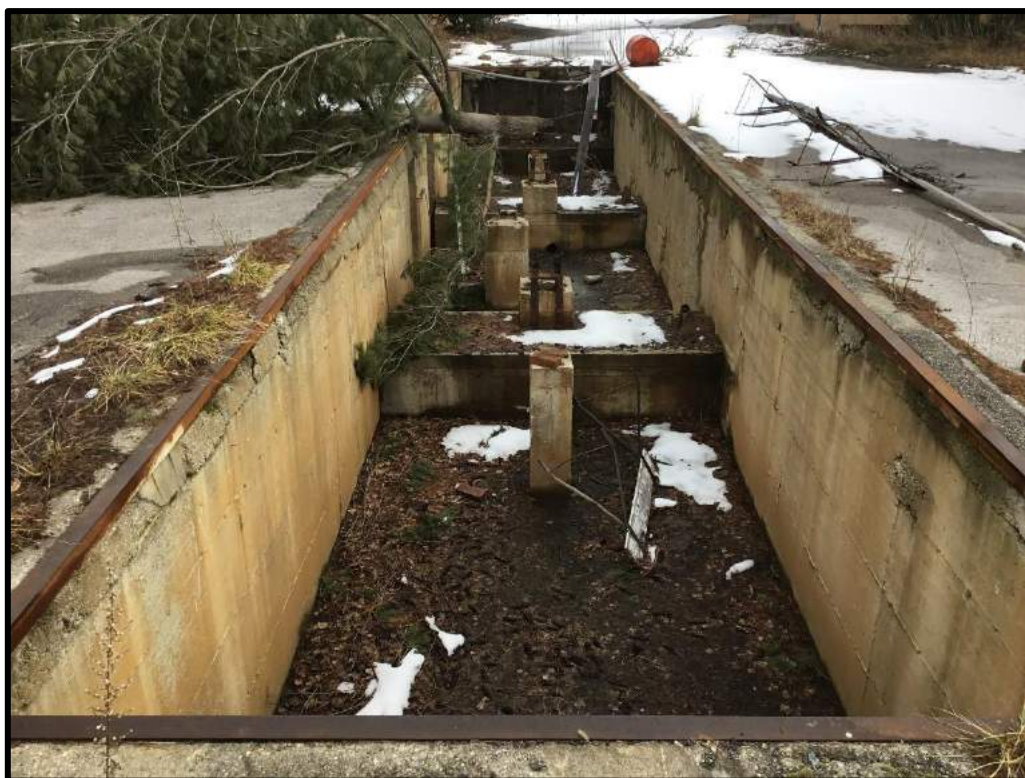
FOTO 78 – Particolare fossa ex pesa
