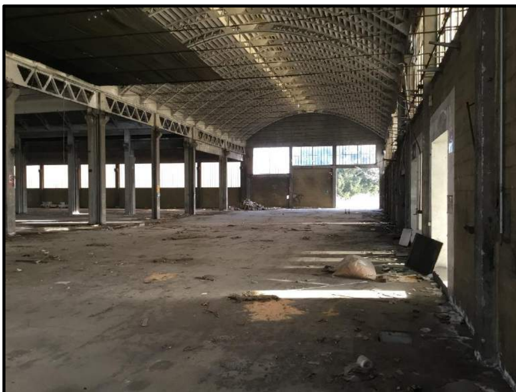
FOTO 13 – Ulteriore vista interna edificio F
