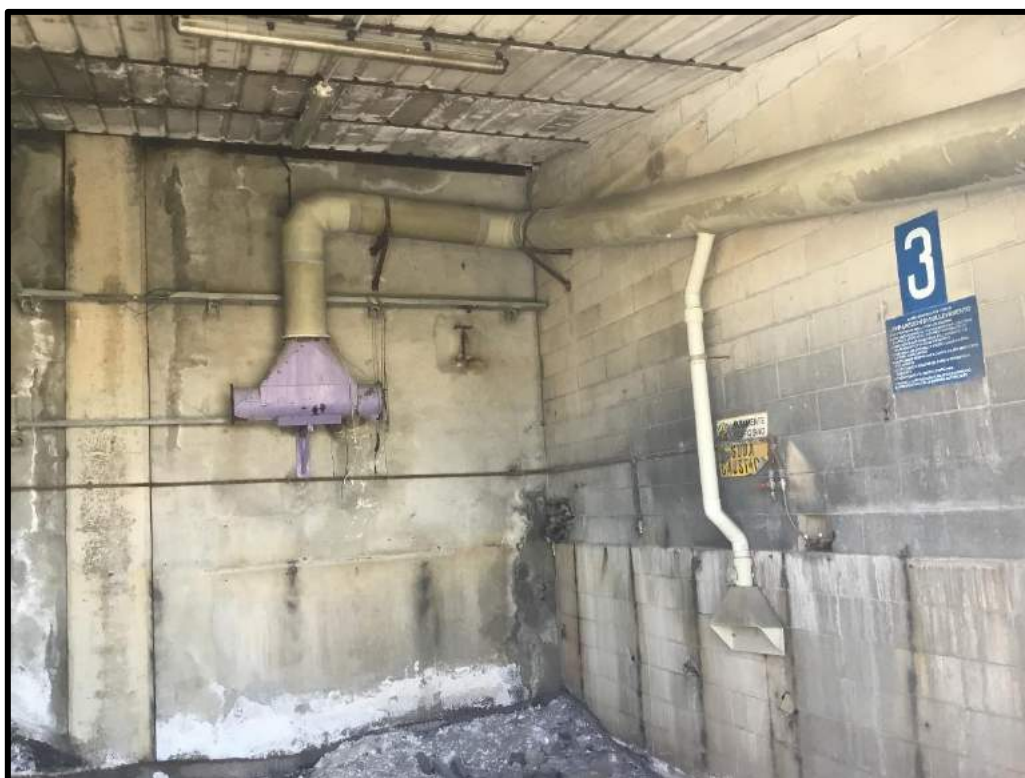
FOTO 151 – Vista interna edificio Q
