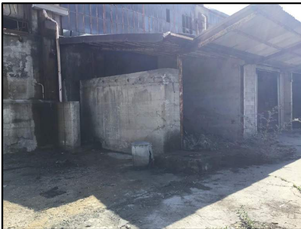
FOTO 152 – Vista esterna edificio Q
