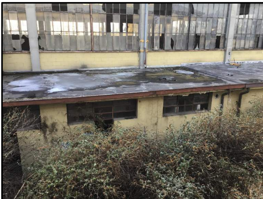
FOTO 110 – Vista edificio E dalla palazzina edificio D
