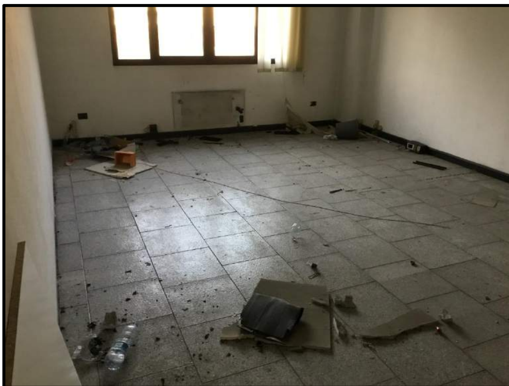
FOTO 108 – Vista interna palazzina uffici edificio D
