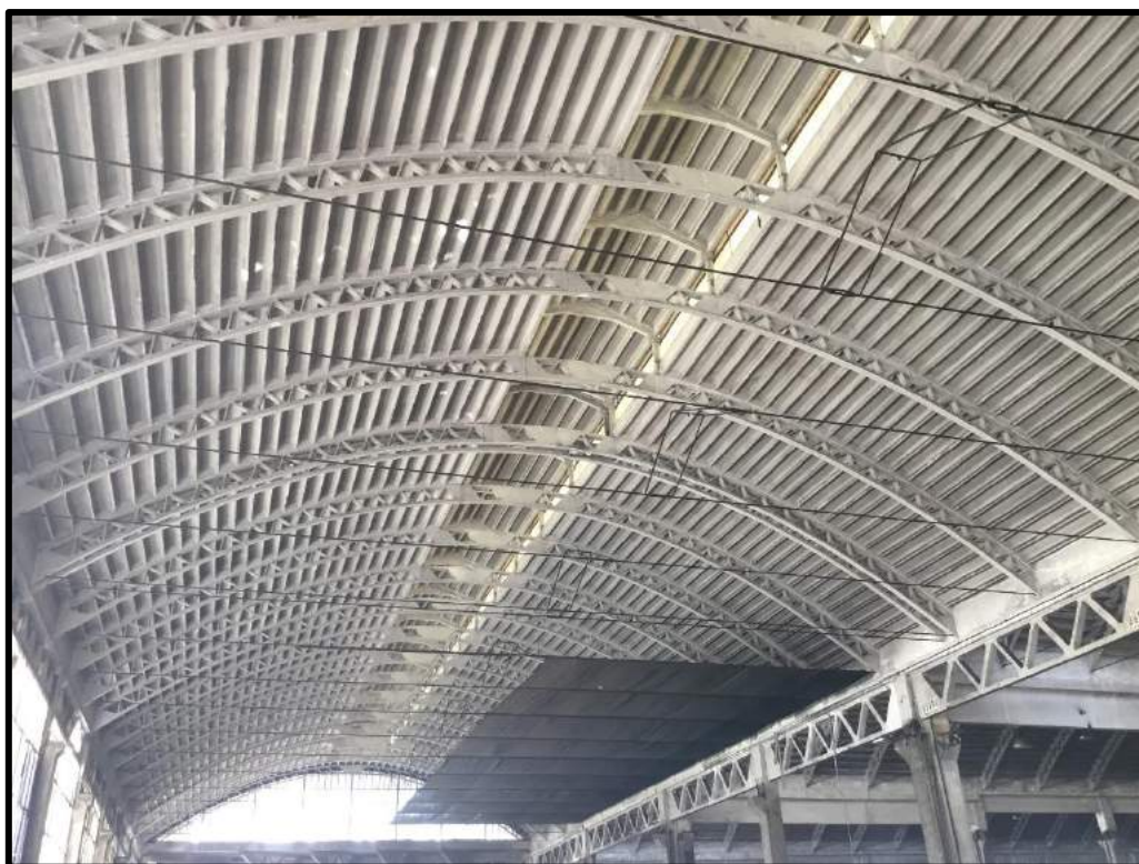
FOTO 168 – Particolare copertura edificio F
