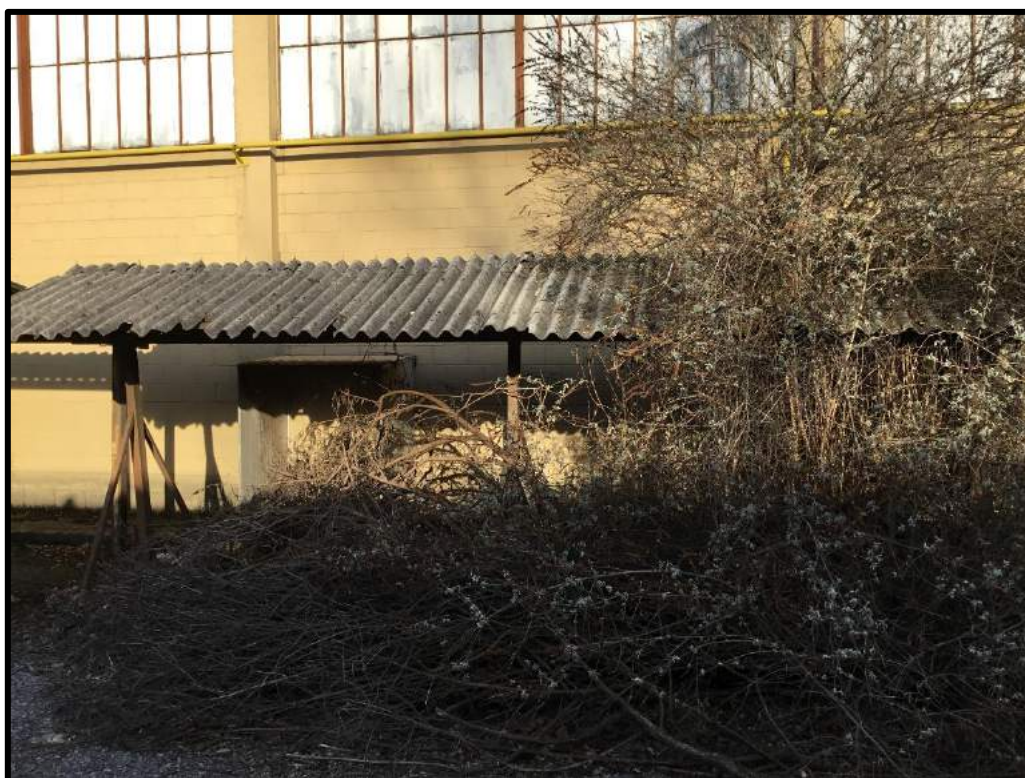
FOTO 5 – Particolare lato est edificio F
