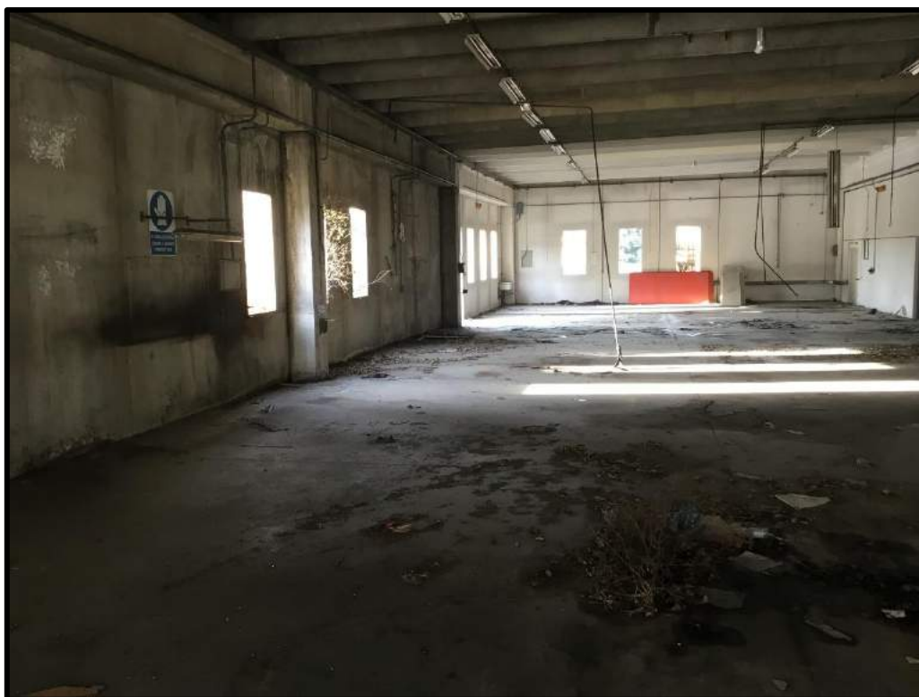
FOTO 50 – Vista interna edificio N
