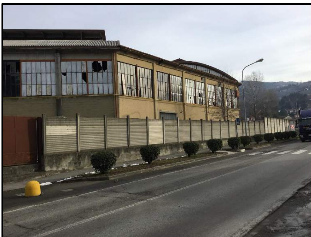
FOTO 88 – Edificio F visto dalla Via Provinciale per Sirone
