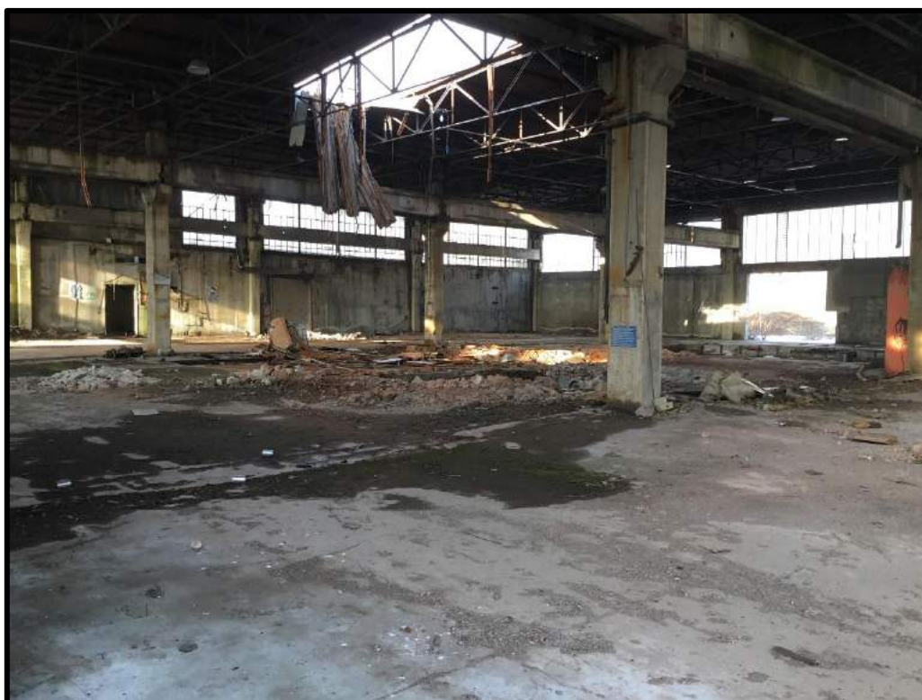
FOTO 23 – Vista interna edificio R
