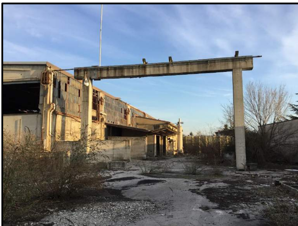
FOTO 119 – Vista edifici R, Q e P
