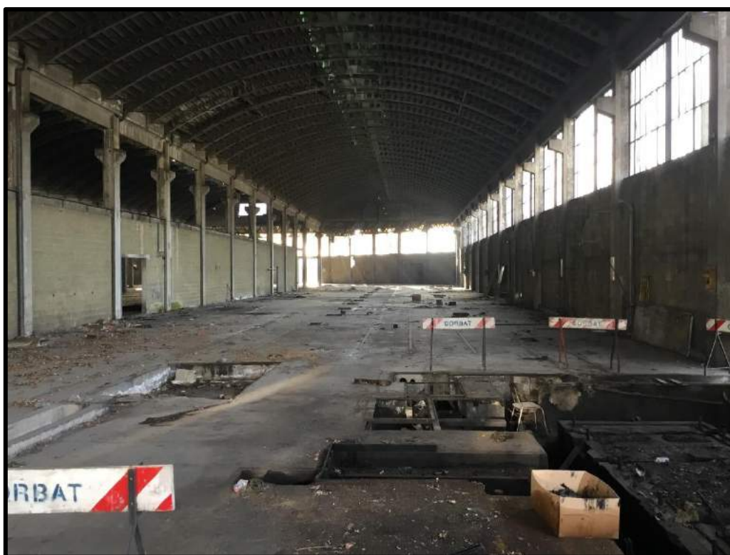
FOTO 18 – Ulteriore vista interna edificio F
