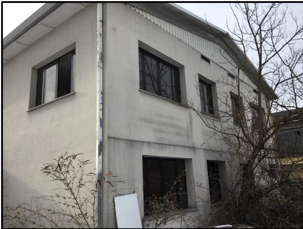
FOTO 71 Vista edificio D
