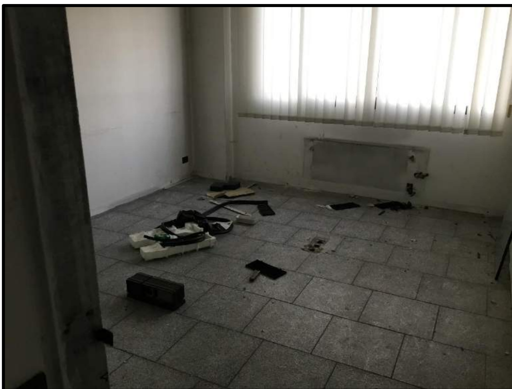
FOTO 98 – Vista interna palazzina uffici edificio D
