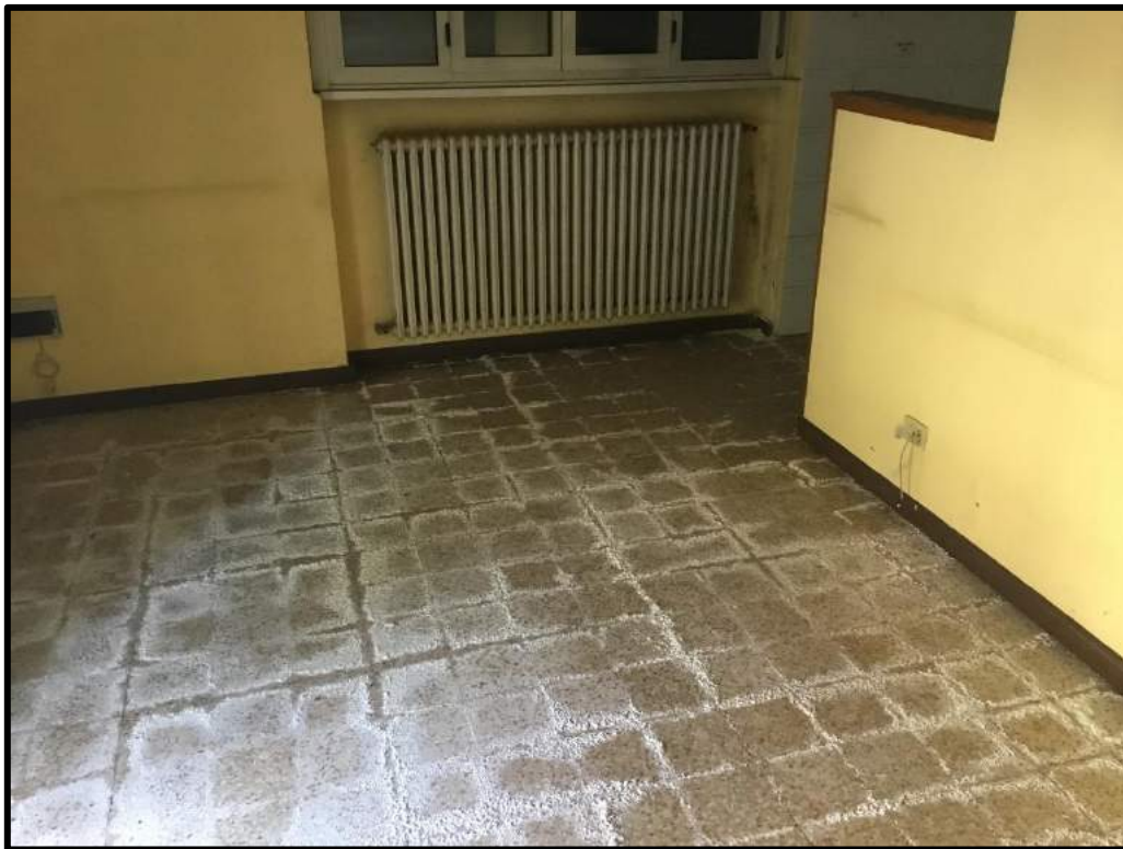
FOTO 133 – Particolare interno portineria
