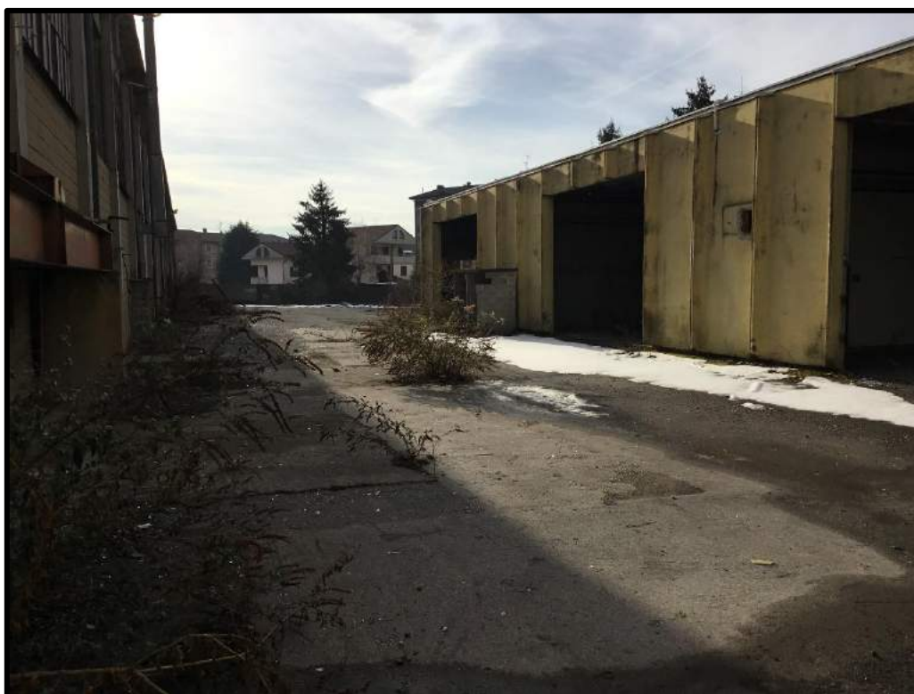
FOTO 61 – Ulteriore vista area di manovra tra edificio N ed edificio F verso sud
