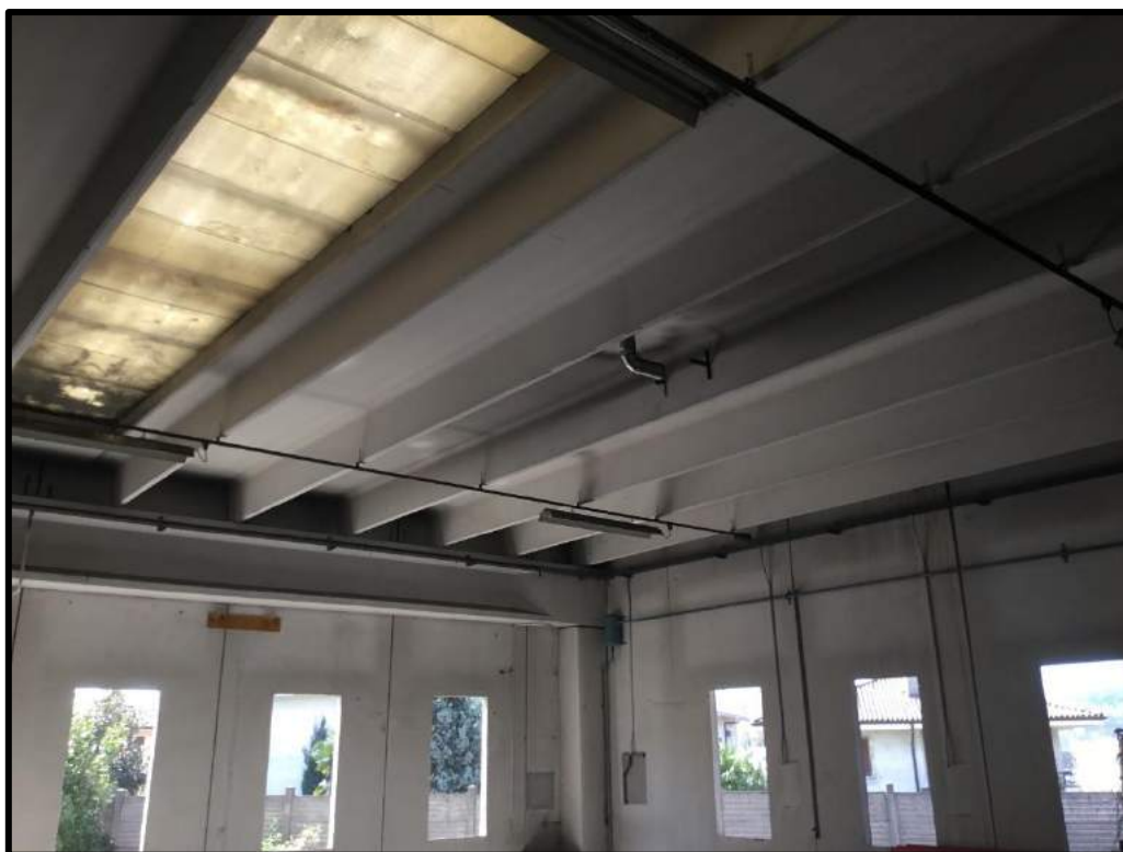
FOTO 160 – Particolare copertura edificio N
