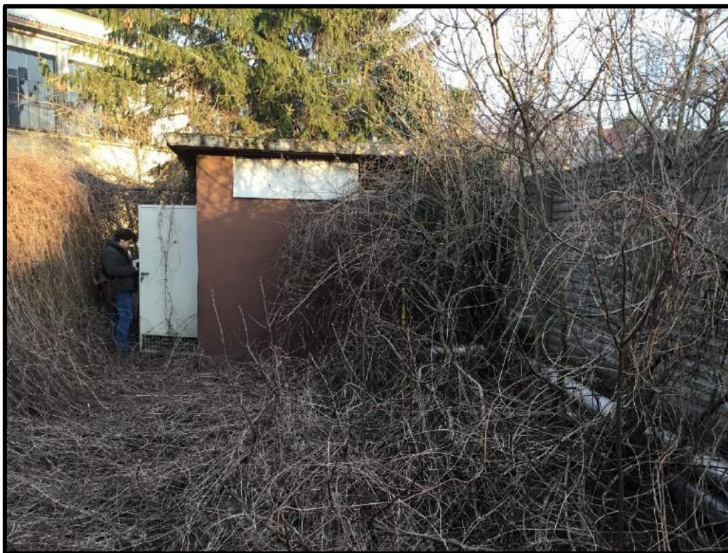
FOTO 125 – Vista edificio M
