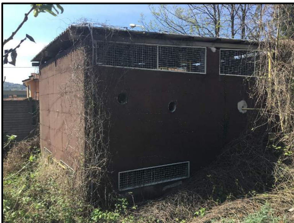
FOTO 161 – Vista edificio M
