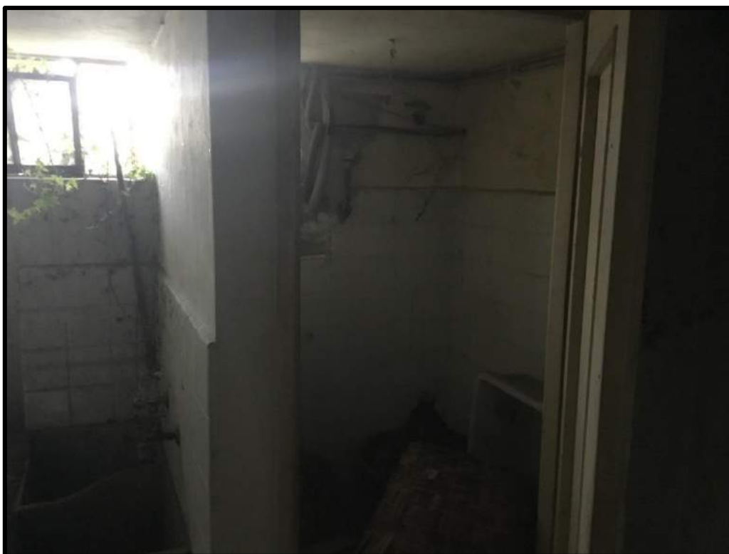
FOTO 138 – Locale interrato portineria
