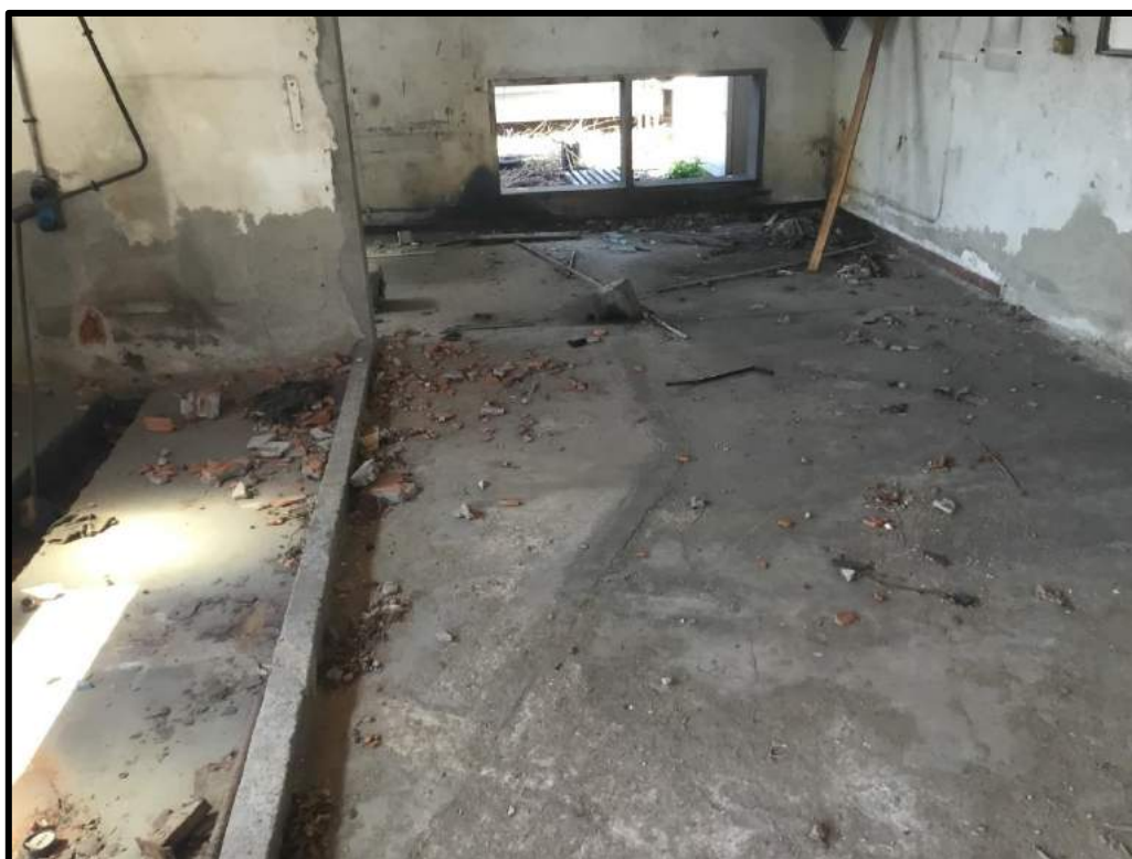
FOTO 165 – Vista interna edificio H
