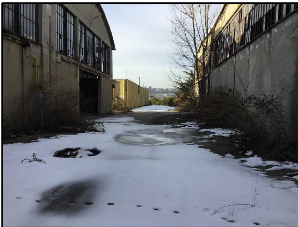
FOTO 22 – Vista tra edifici F, R e N sullo sfondo
