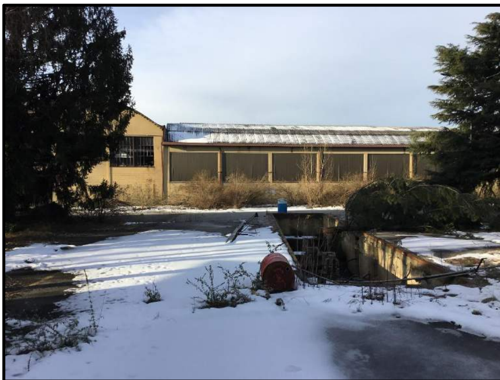
FOTO 1 – Ingresso da Via Provinciale vista fossa ex pesa
