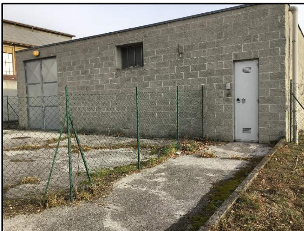
FOTO 83 – Particolare edifici comunali per la manutenzione dell'acquedotto su mapp. 2278
