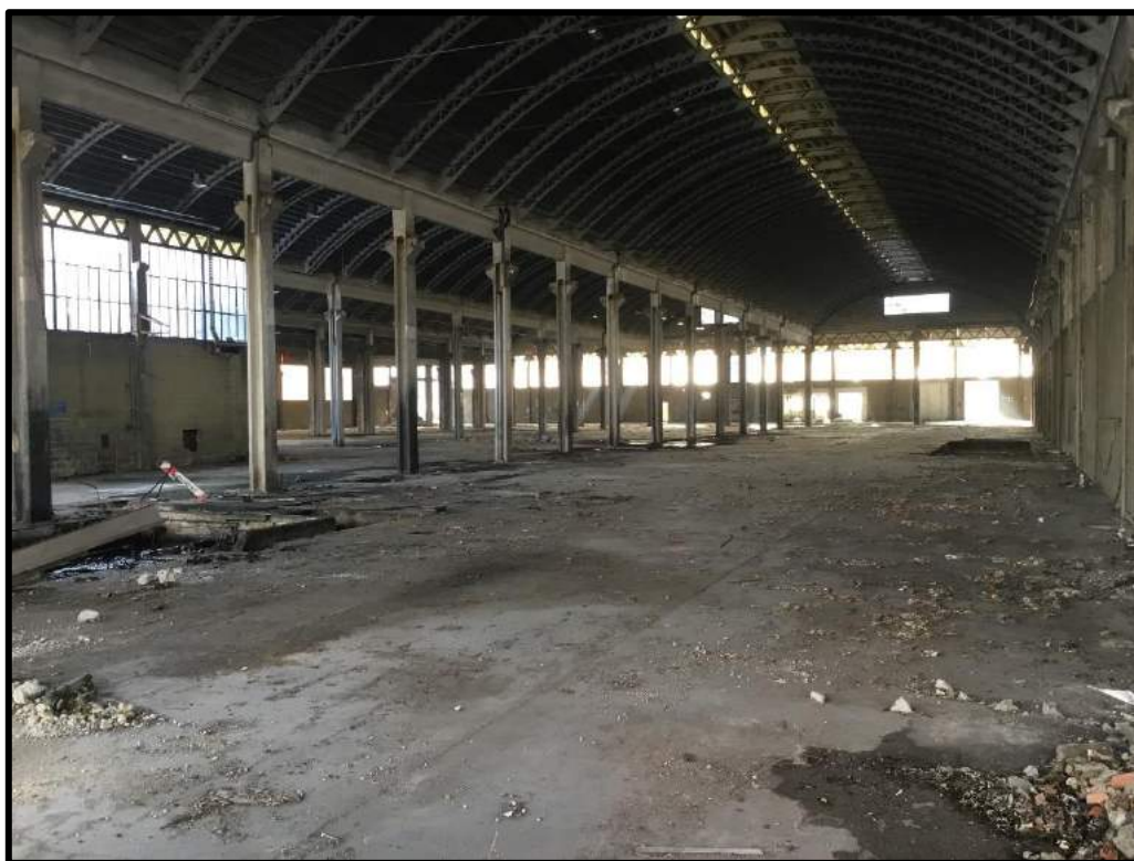
FOTO 20 – Ulteriore vista interna edificio F
