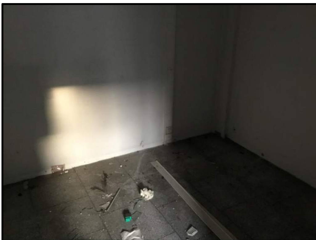
FOTO 106 – Vista interna palazzina uffici edificio D
