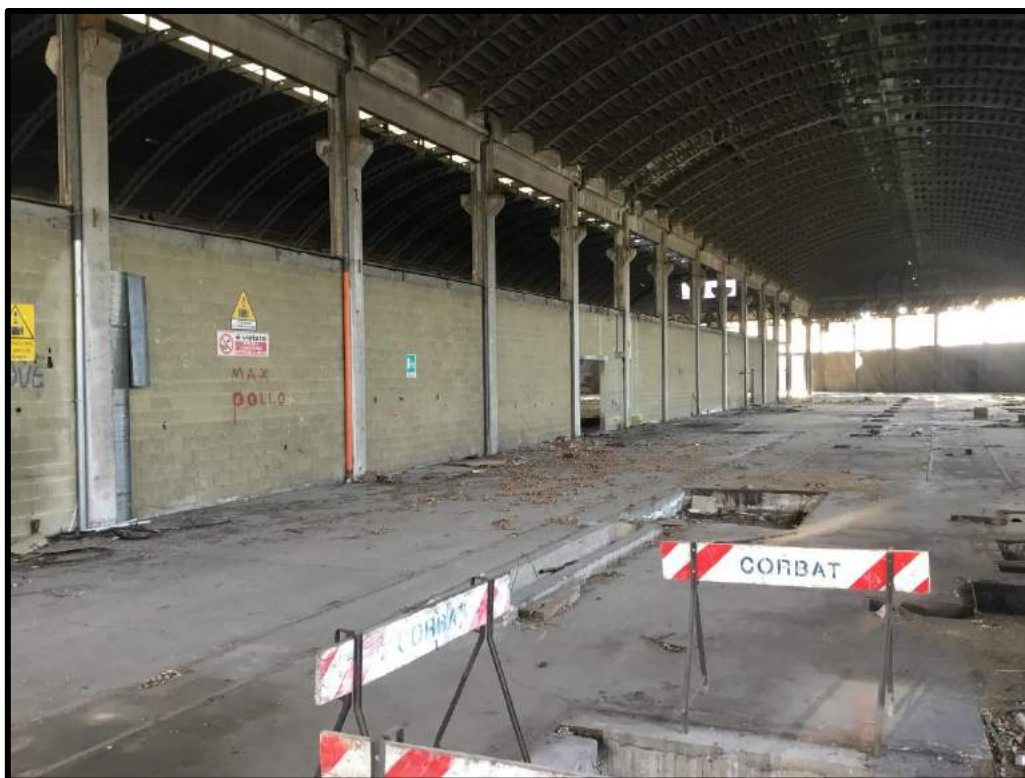
FOTO 19 – Ulteriore vista interna edificio F
