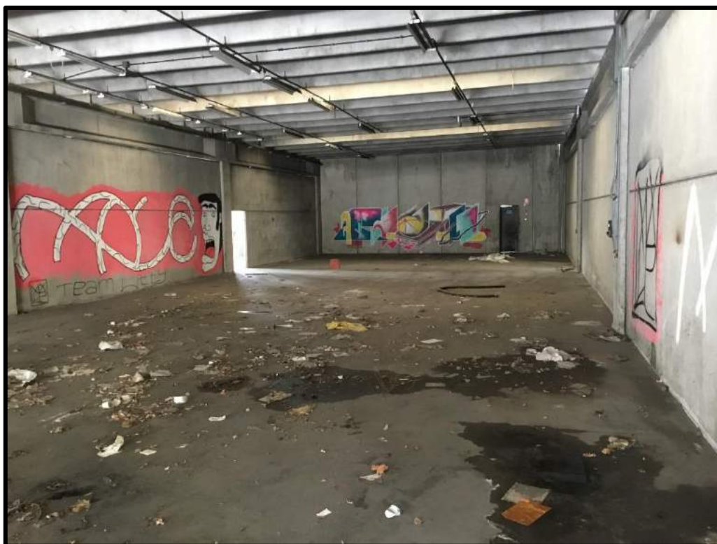
FOTO 48 – Vista interna edificio N
