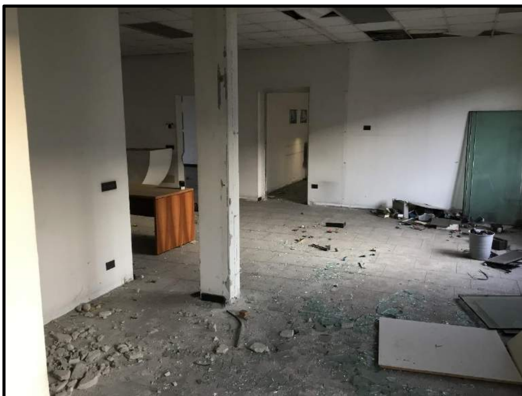
FOTO 105 – Vista interna palazzina uffici edificio D
