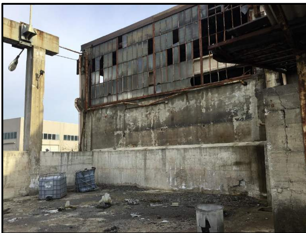
FOTO 40 – Vista su edificio S demolito a ridosso dell'edificio R
