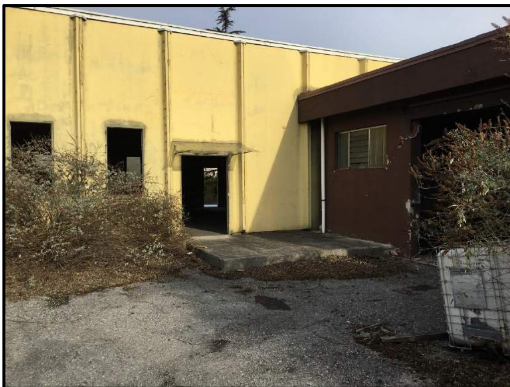
FOTO 56 – Particolare edificio N
