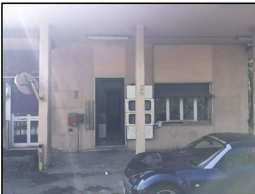
FOTO 136 – Vista tettoia portineria
