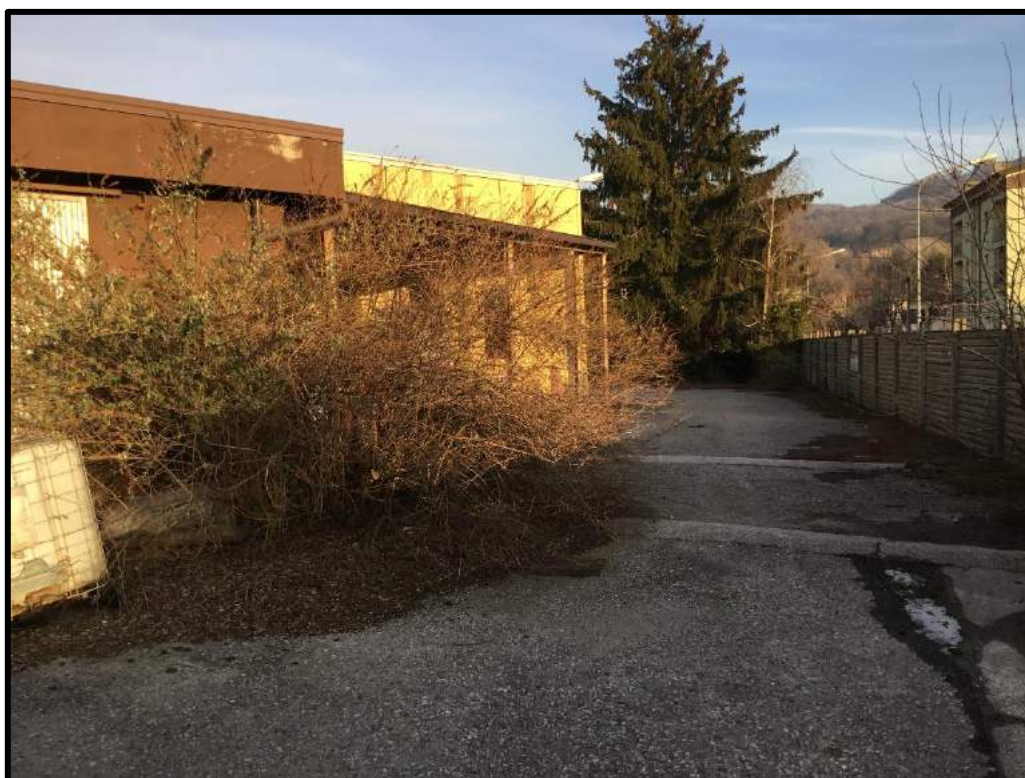
FOTO 123 – Vista edificio N lato sud
