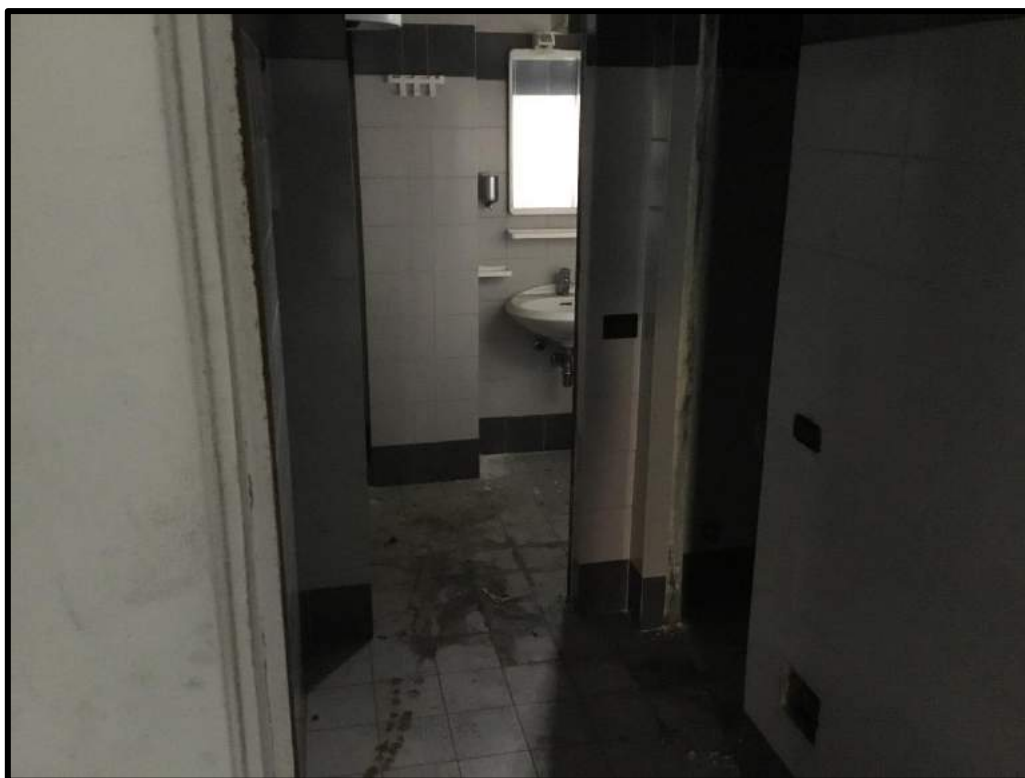
FOTO 96 – Vista interna palazzina uffici edificio D
