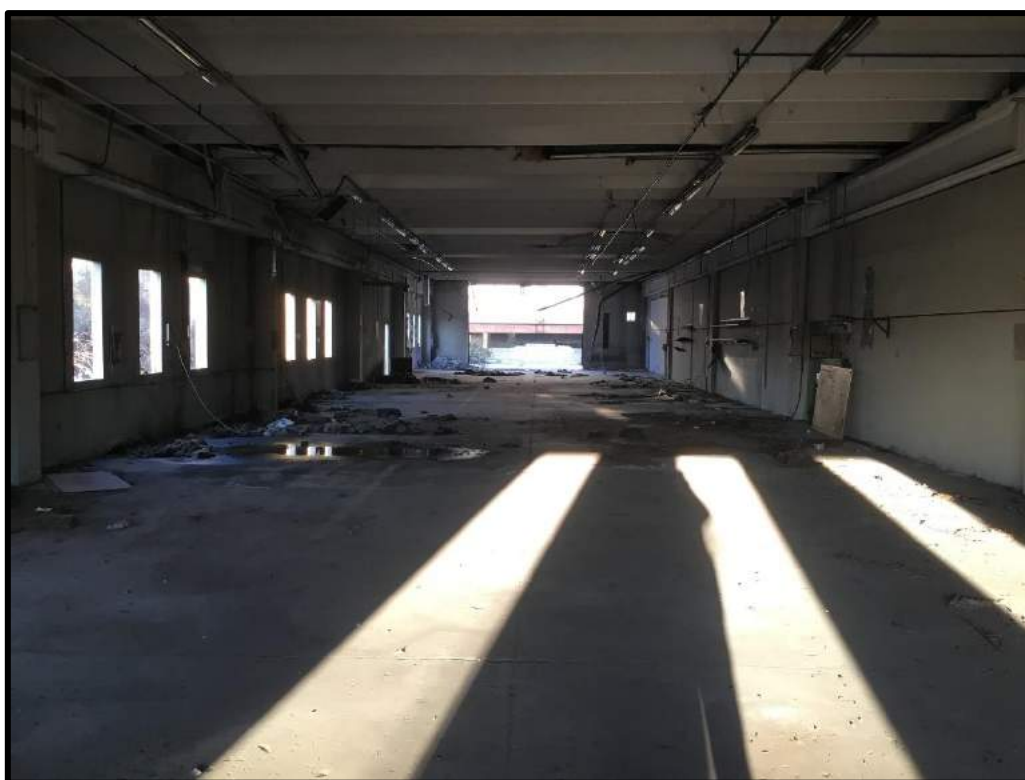
FOTO 122 – Vista interna edificio N
