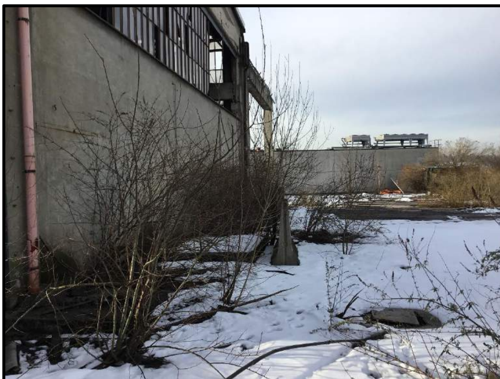
FOTO 37 – Lato ovest edificio R
