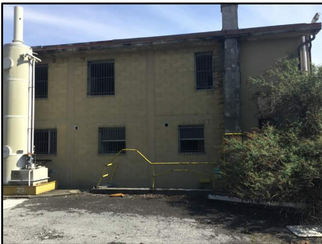
FOTO 150 – Prospetto edificio P
