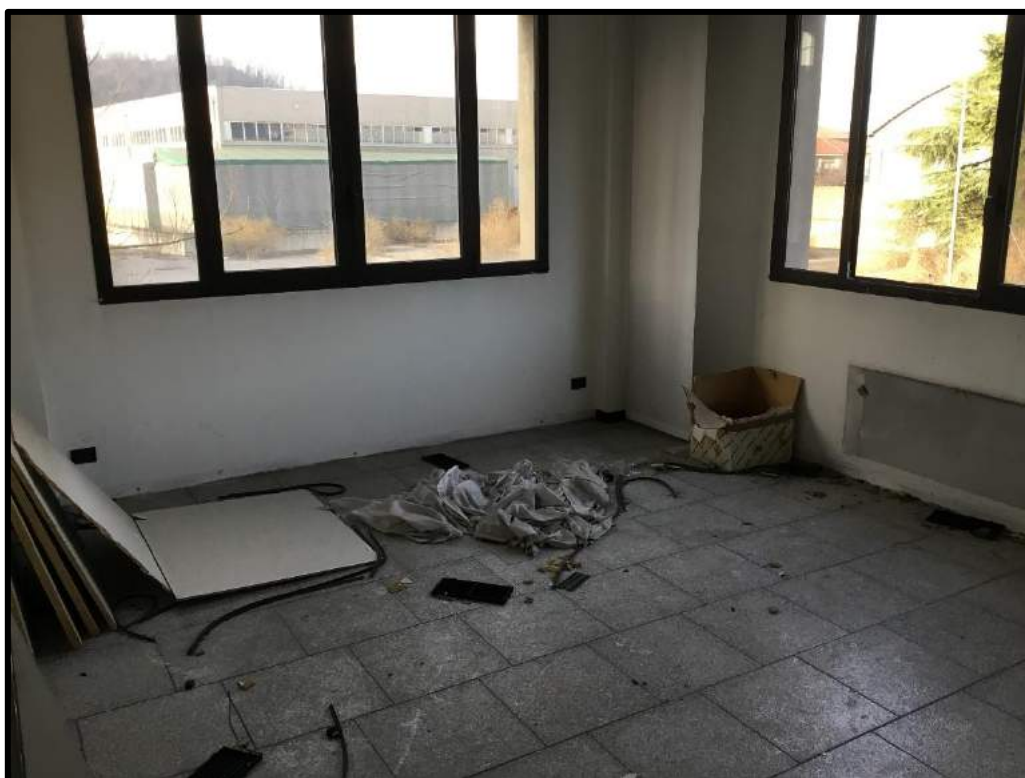
FOTO 101 – Vista interna palazzina uffici edificio D
