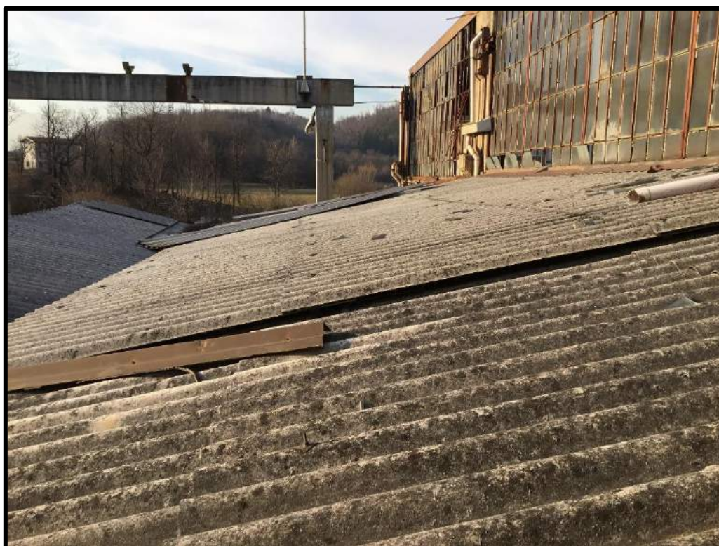
FOTO 115 – Particolare copertura in eternit edificio Q
