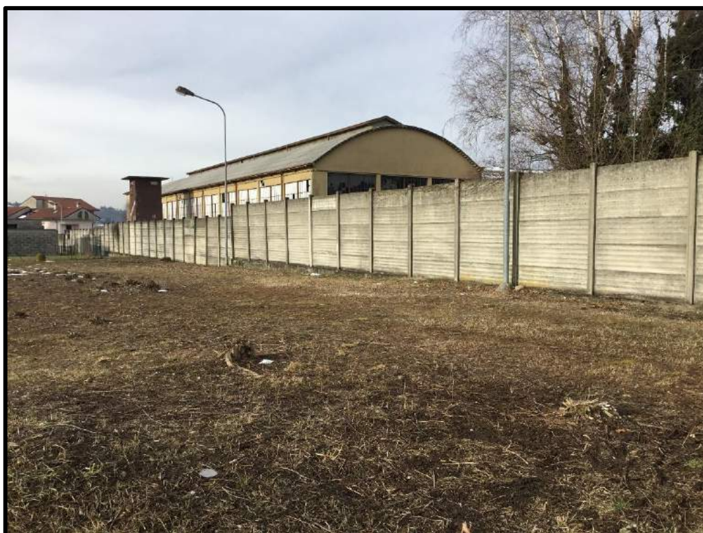
FOTO 81 – Particolare recinzione esterna vista da mapp. 2278
