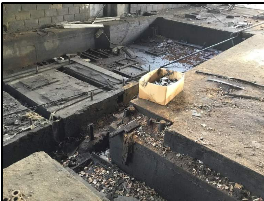
FOTO 17 – Particolare fosse all'interno dell'edificio F
