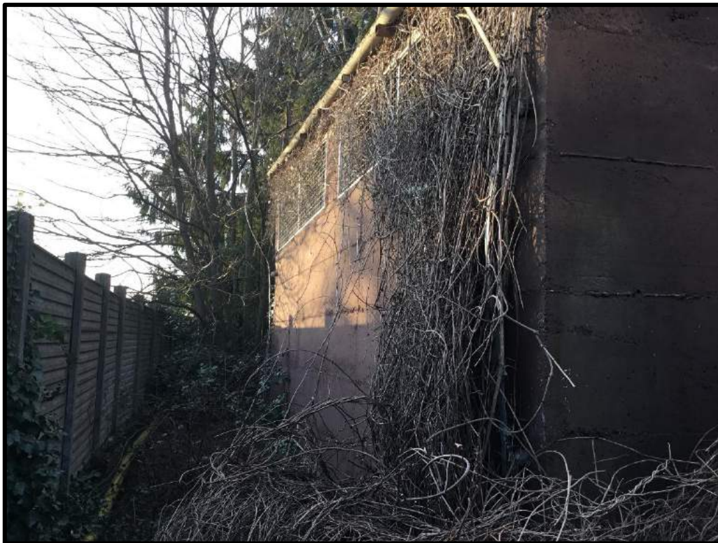
FOTO 127 – Vista edificio M
