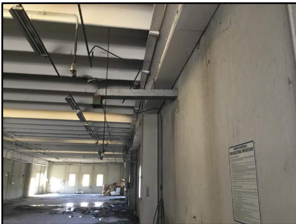
FOTO 158 – Vista interna edificio N
