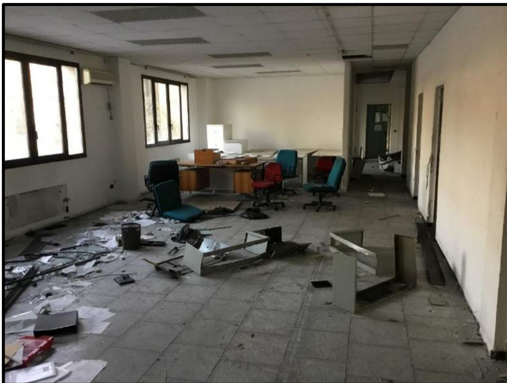
FOTO 90 – Vista interna edificio G
