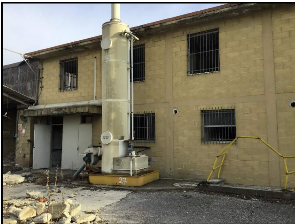
FOTO 42 – Vista esterna edificio P
