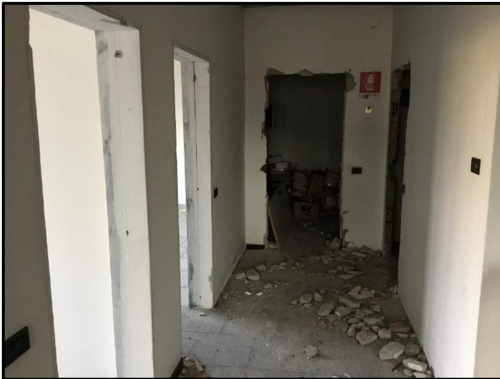
FOTO 103 – Vista interna palazzina uffici edificio D
