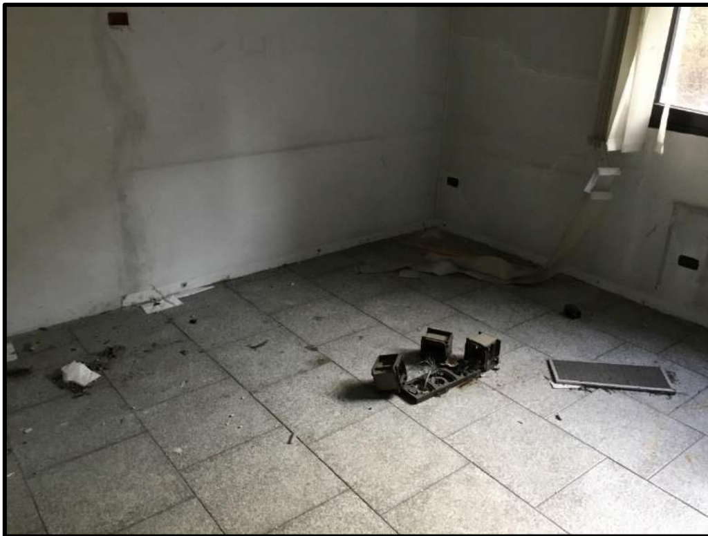
FOTO 97 – Vista interna palazzina uffici edificio D
