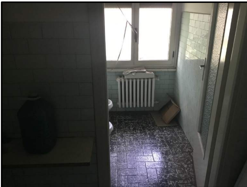
FOTO 132 – Particolare interno portineria
