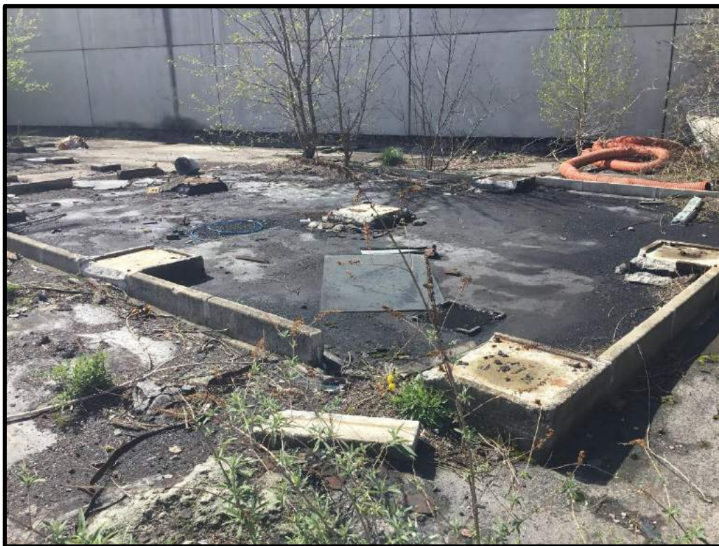
FOTO 155 – Vista edificio O demolito
