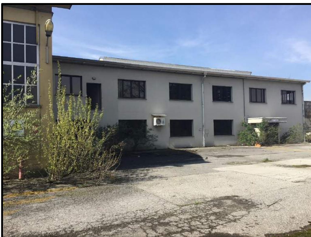
FOTO 142 – Vista edificio D
