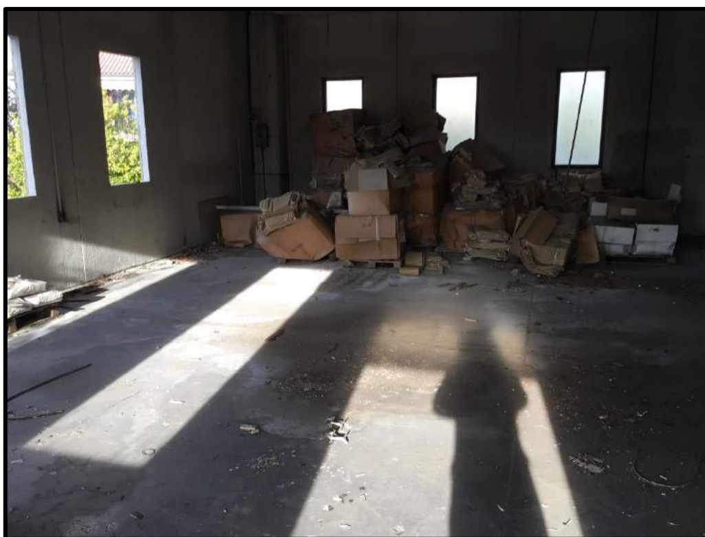
FOTO 58 – Interno edificio N
