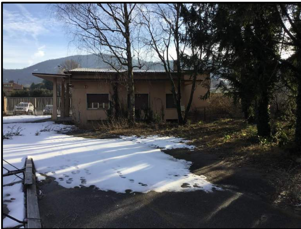
FOTO 3 – Portineria edificio A
