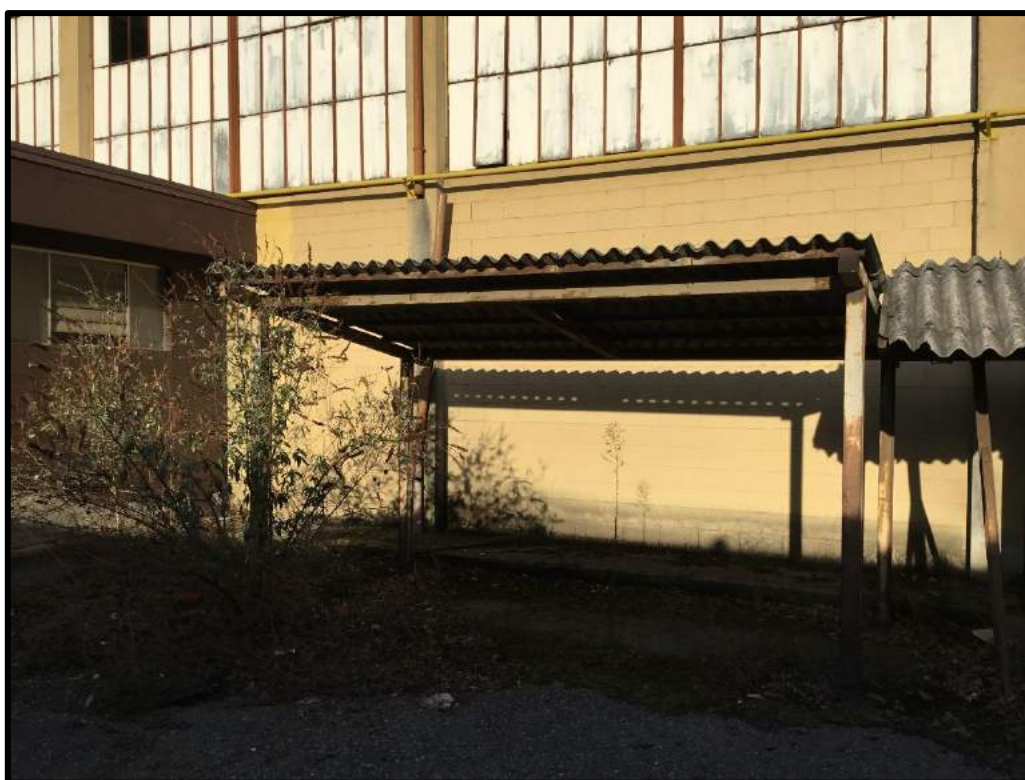
FOTO 6 – Particolare lato est edificio F
