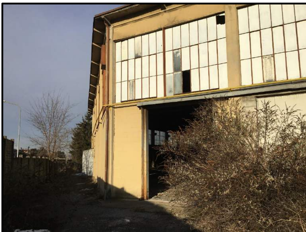
FOTO 11 – Lato sud edificio F
