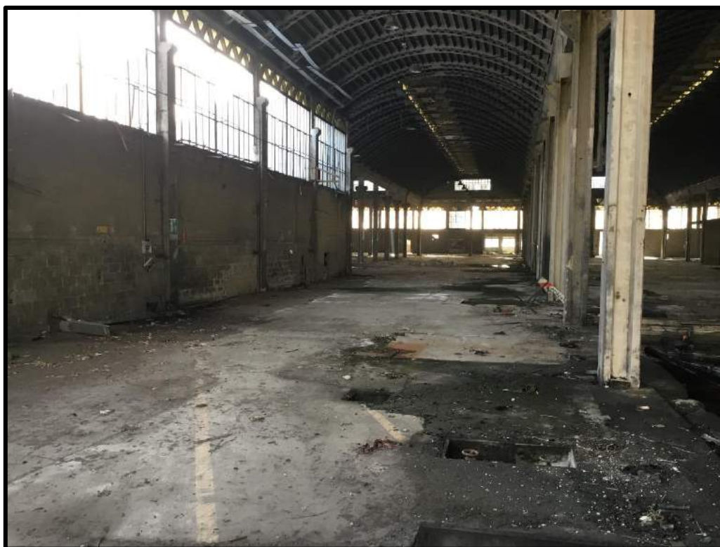
FOTO 21 – Ulteriore vista interna edificio F
