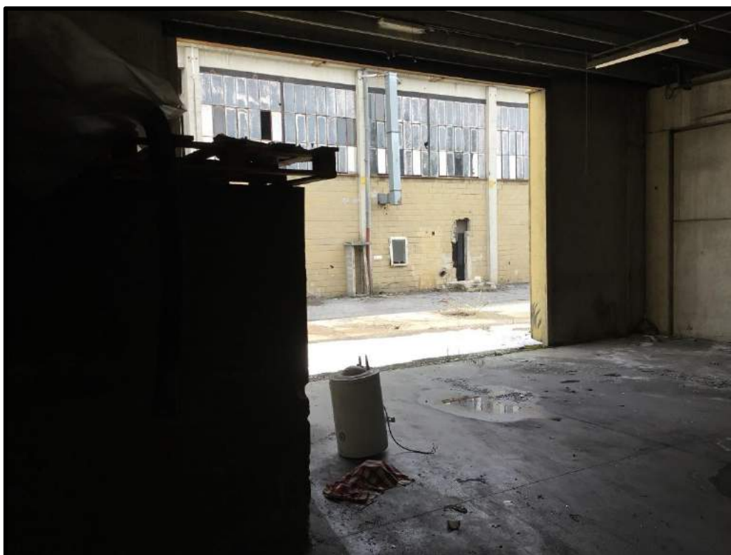
FOTO 47 – Vista interna edificio N
