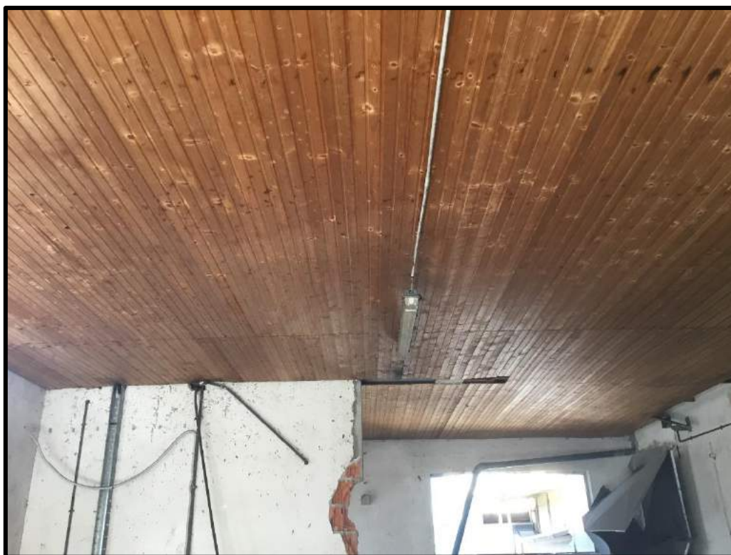
FOTO 164 – Vista interna edificio I
