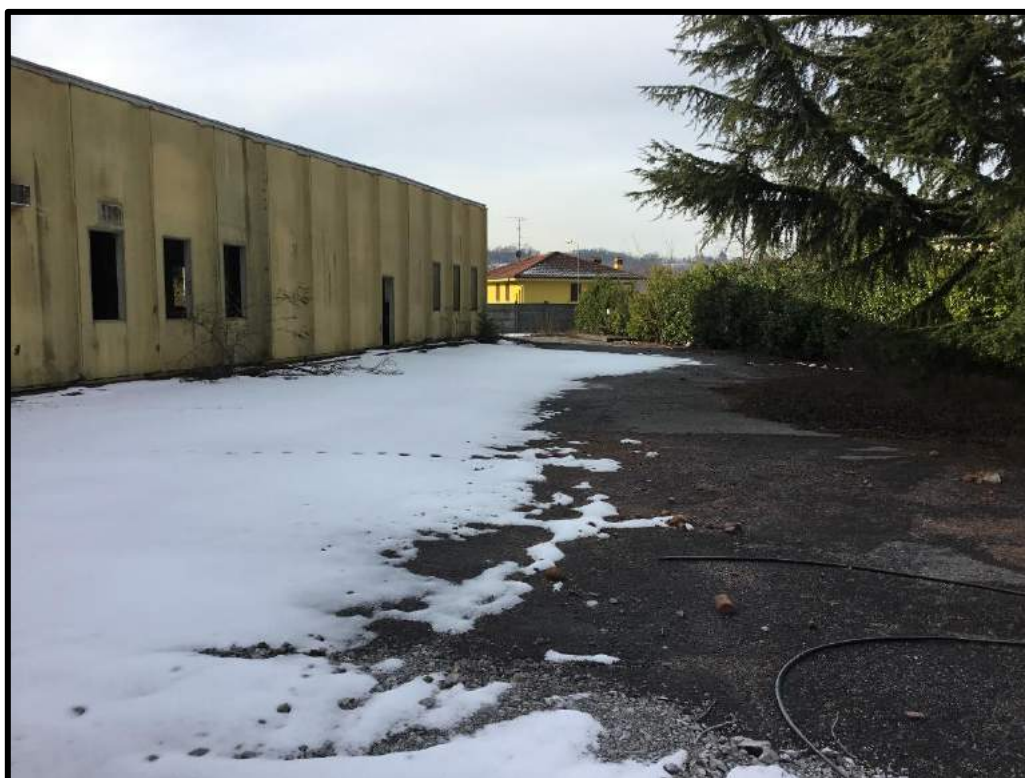
FOTO 43 – Vista esterna edificio N lato nord-ovest
