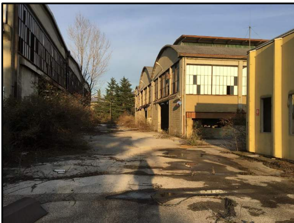
FOTO 121 – Vista edifici N, F e R
