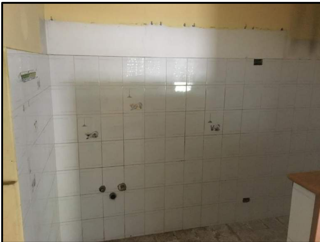
FOTO 134 – Particolare interno portineria
