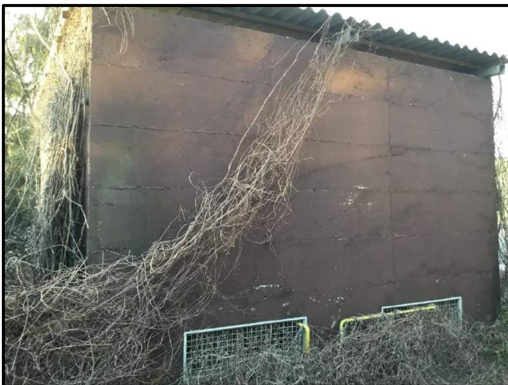
FOTO 126 – Vista edificio M
