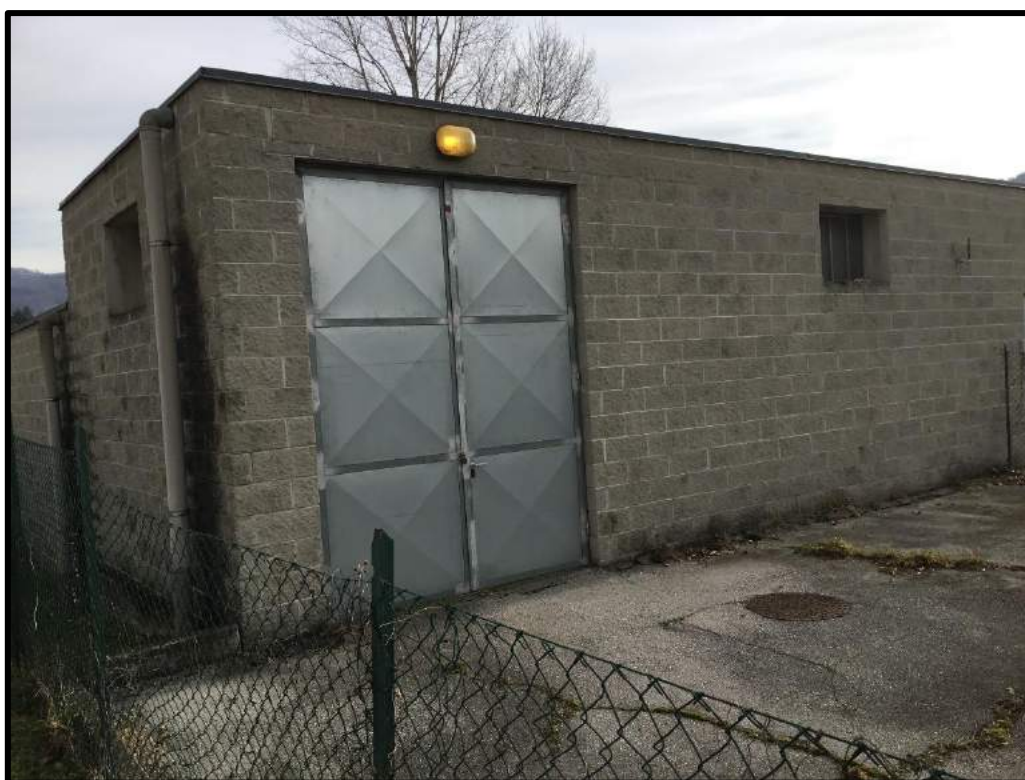
FOTO 84 – Ulteriore vista edifici comunali per la manutenzione dell'acquedotto su mapp. 2278
