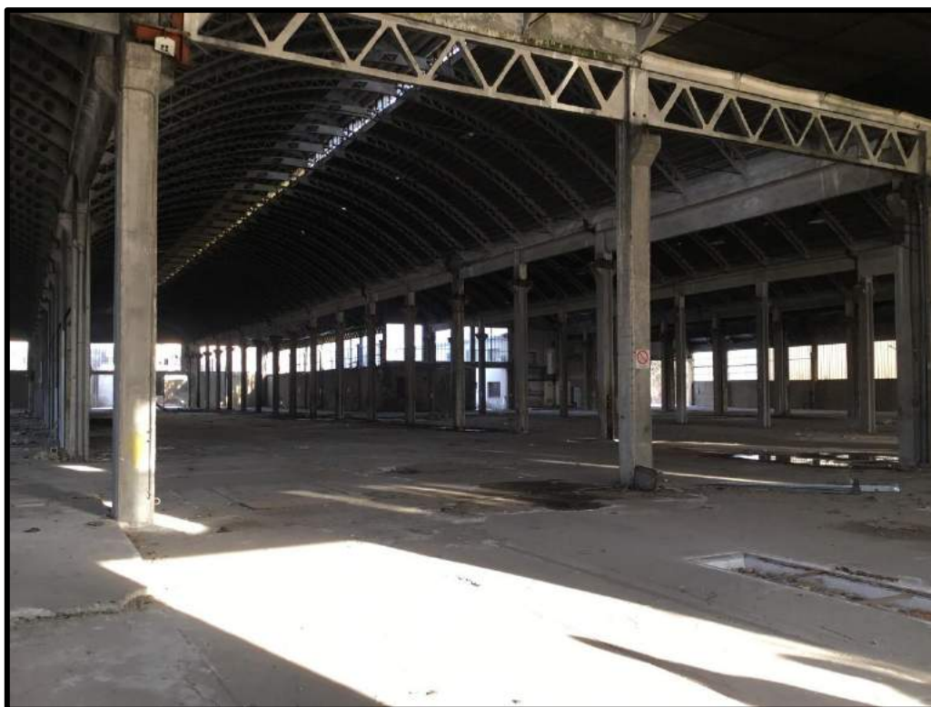
FOTO 16 – Ulteriore vista interna edificio F
