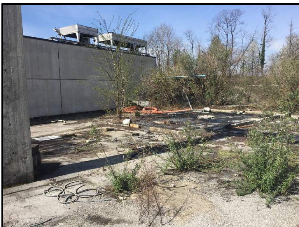
FOTO 154 – Vista verso edificio O
