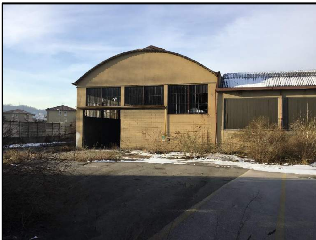
FOTO 2 – Vista edificio F
