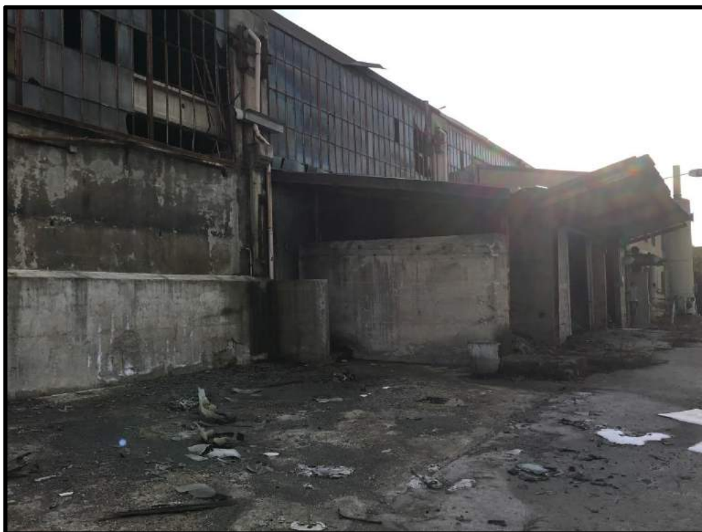
FOTO 39 – Vista edifici P e Q
