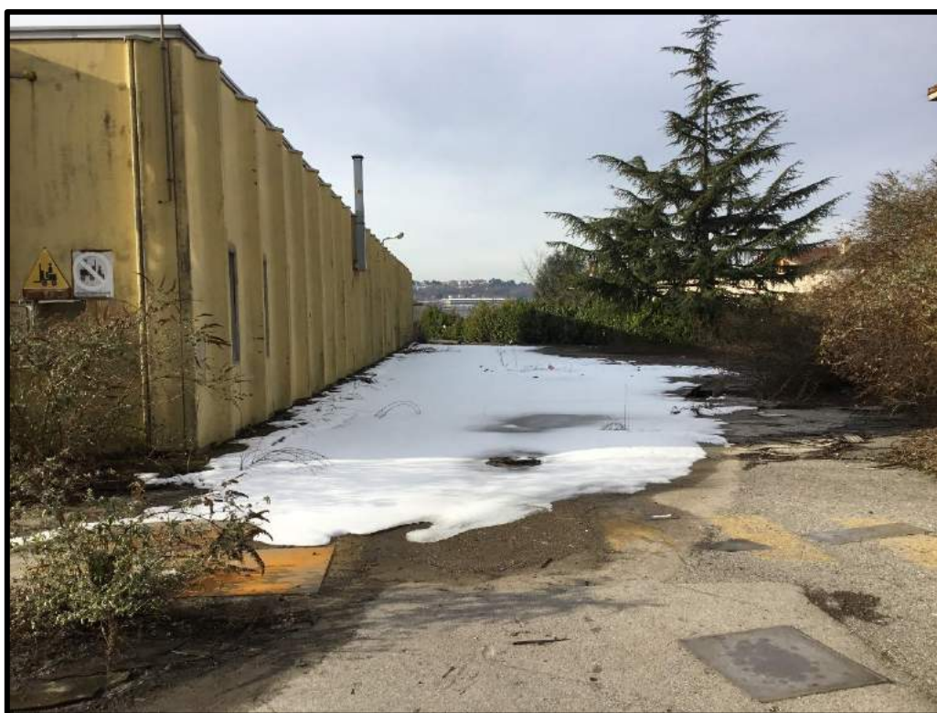
FOTO 62 – Ulteriore vista esterna edificio N
