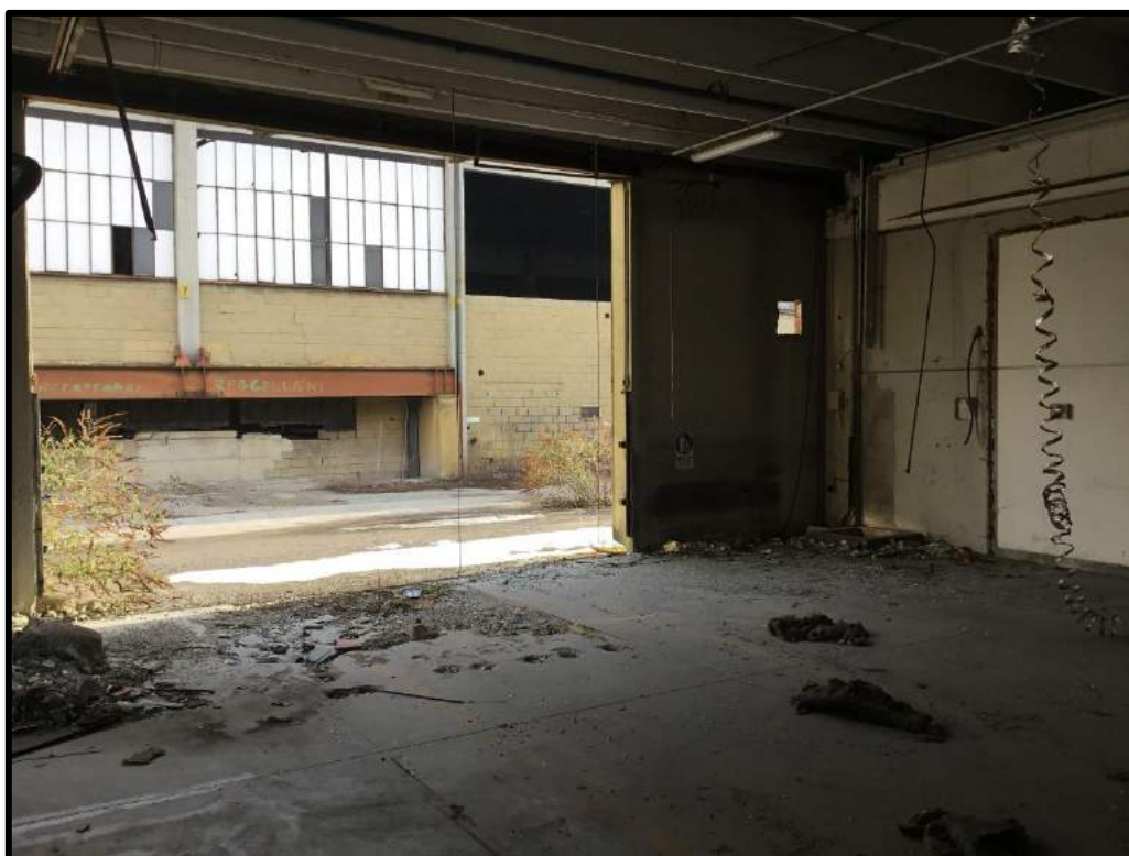
FOTO 45 – Vista interna edificio N
