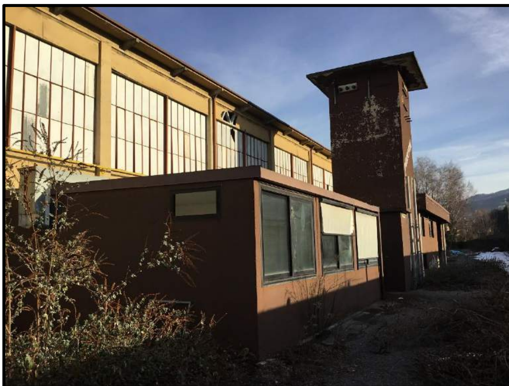
FOTO 10 – Vista edifici G H I e Cabine Enel
