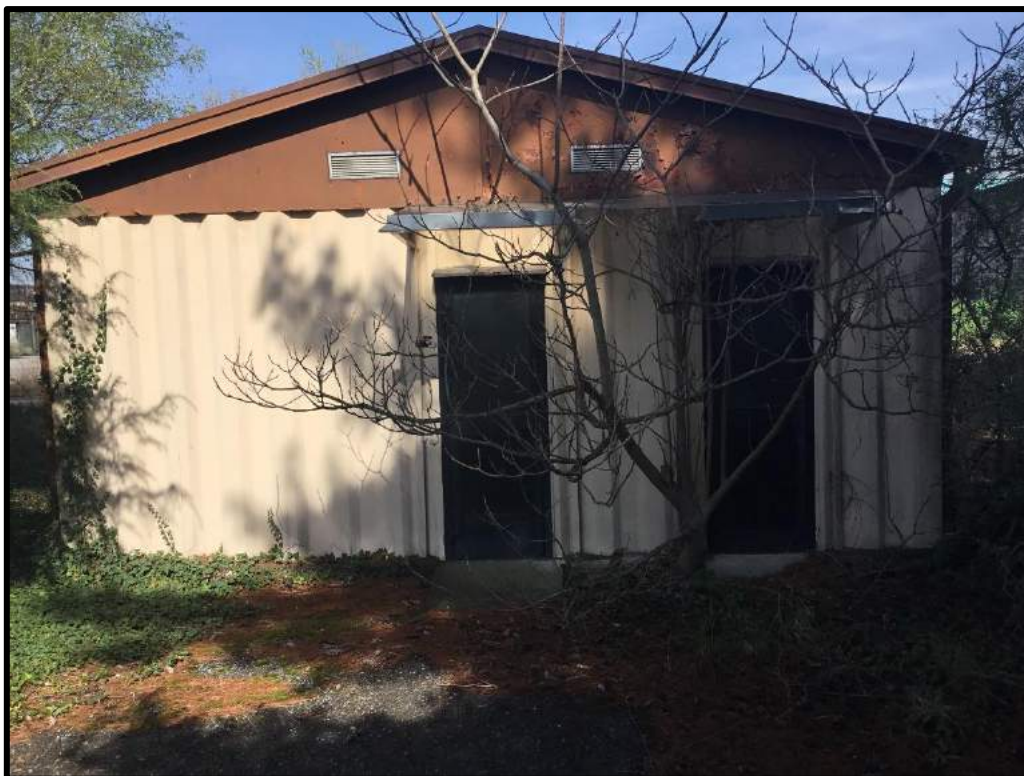
FOTO 140 – Ingresso mensa edificio C
