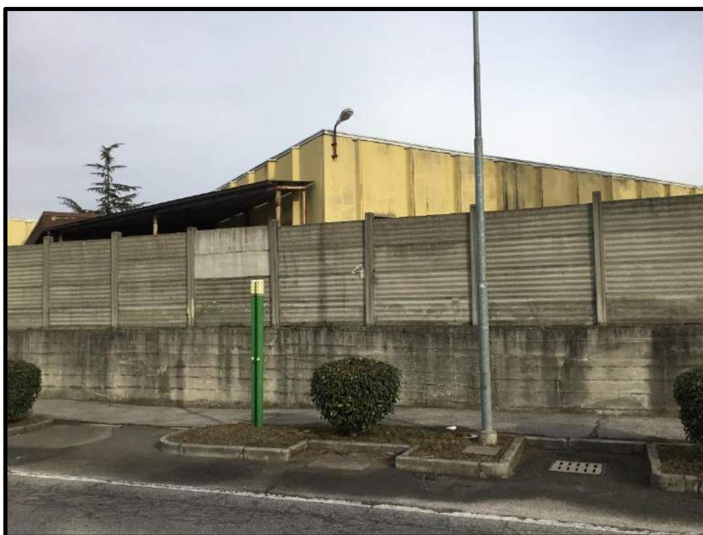
FOTO 86 – Edificio N visto dalla Via Provinciale per Sironè
