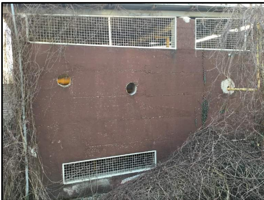
FOTO 124 – Vista edificio M
