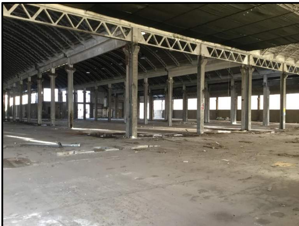
FOTO 12 – Vista interna edificio F
