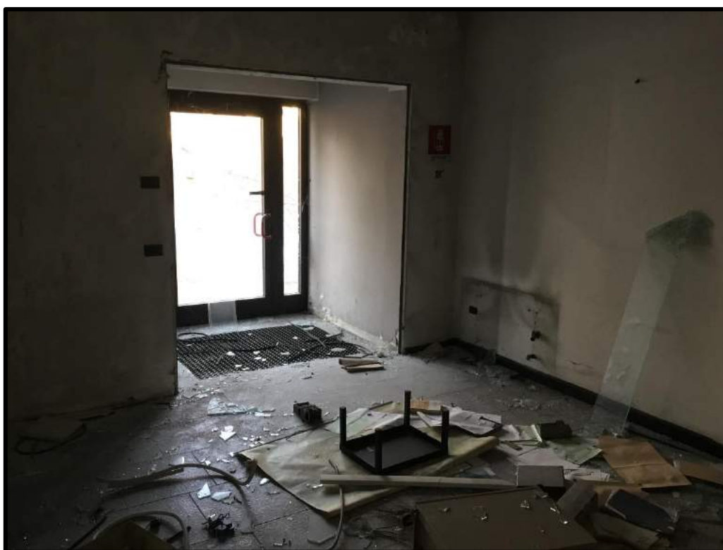
FOTO 92 – Vista interna edificio H
