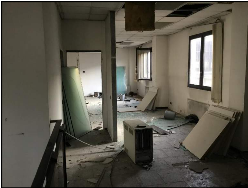
FOTO 99 – Vista interna palazzina uffici edificio D
