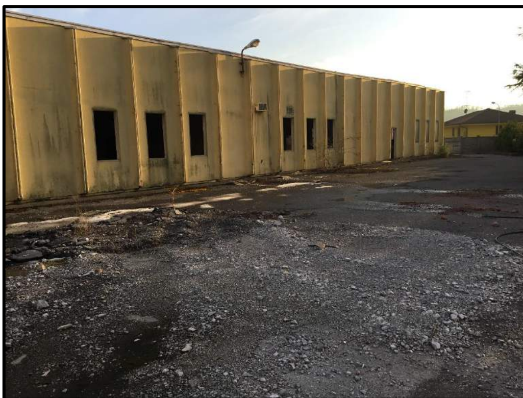
FOTO 120 – Vista edificio N
