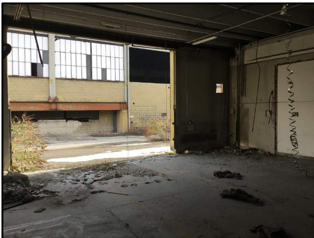
FOTO 94 – Vista interna edificio H
