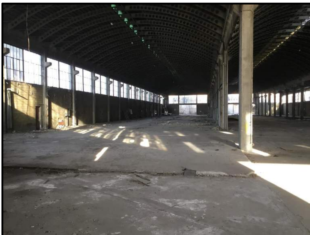
FOTO 15 – Ulteriore vista interna edificio F
