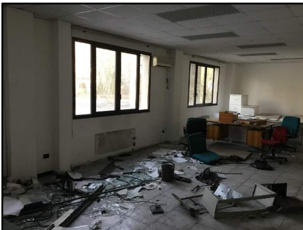
FOTO 91 – Vista interna edificio G
