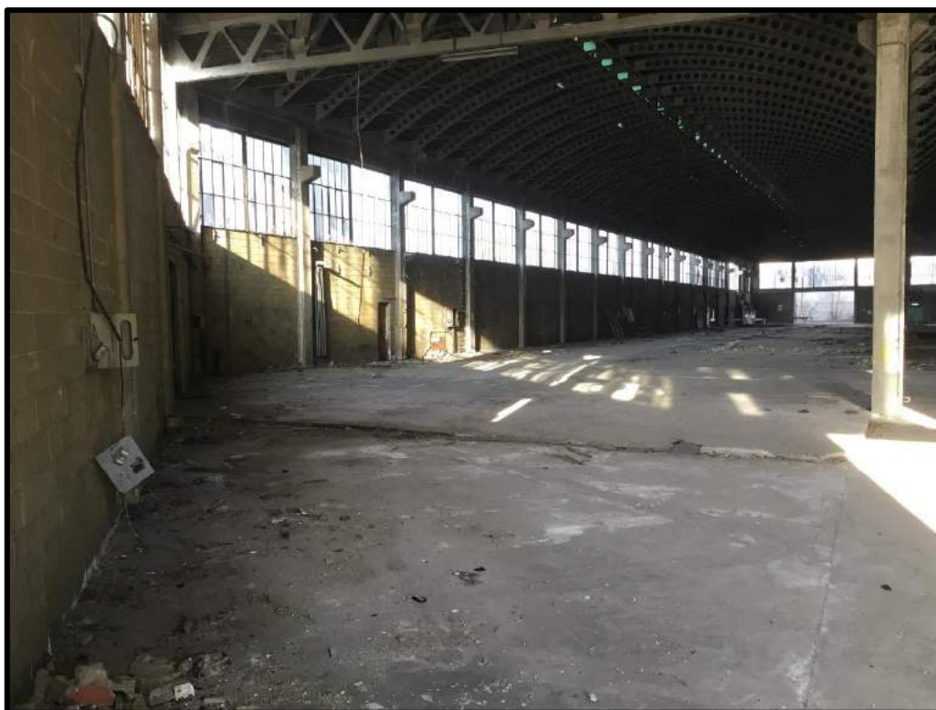
FOTO 14 – Ulteriore vista interna edificio F
