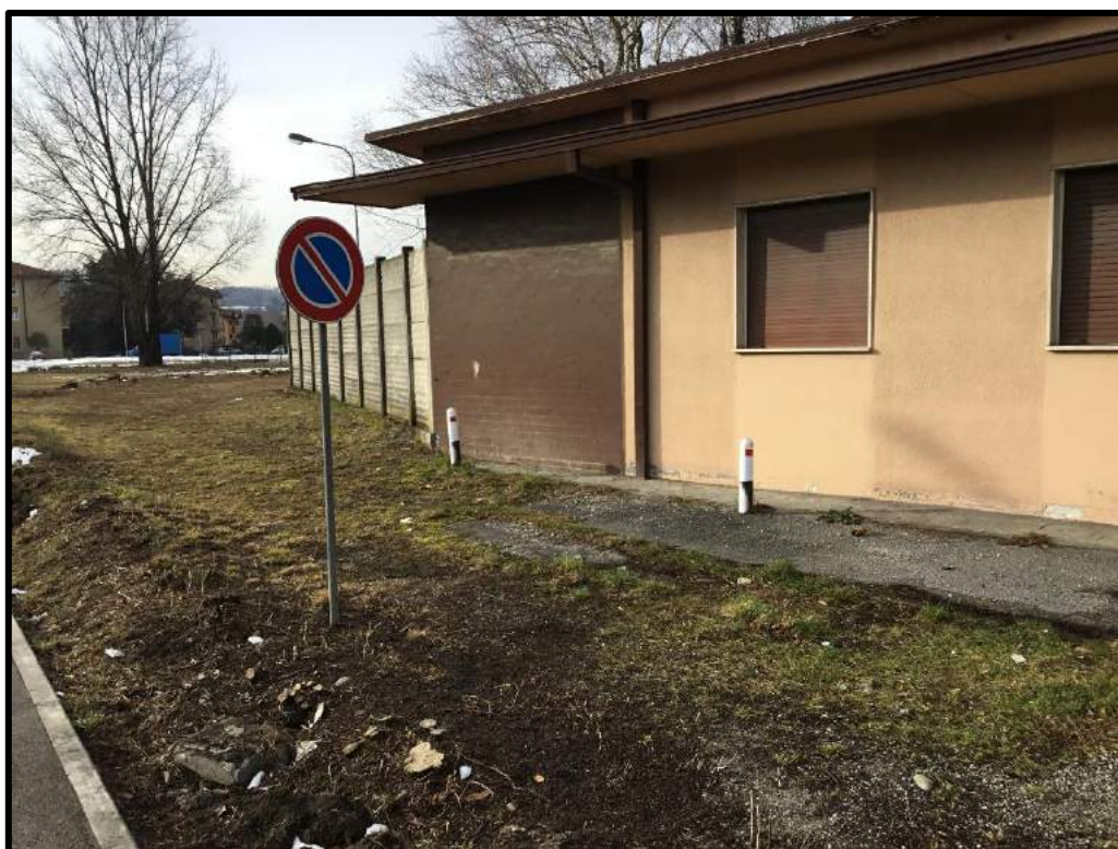
FOTO 79 – Vista esterna portineria
