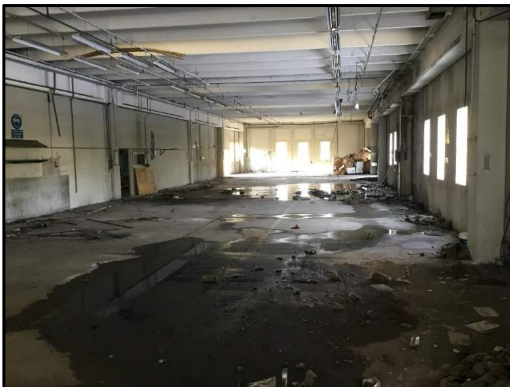
FOTO 46 – Vista interna edificio N
