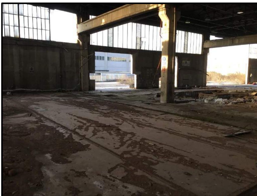
FOTO 116 – Vista interna edificio R
