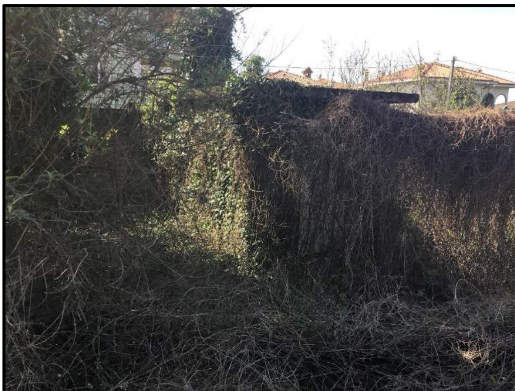
FOTO 162 – Vista edificio L
