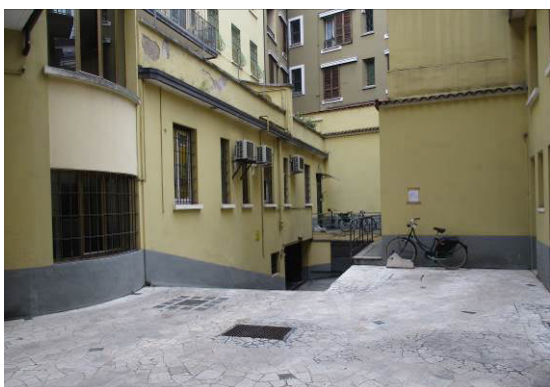
Accesso al vano scala presente nel cortile interno e al piano interrato
