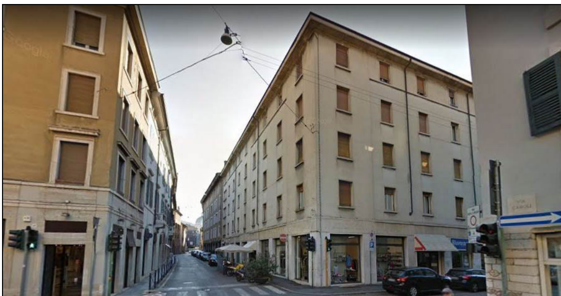
Palazzo-Caratteristiche costruttive e tipologiche
