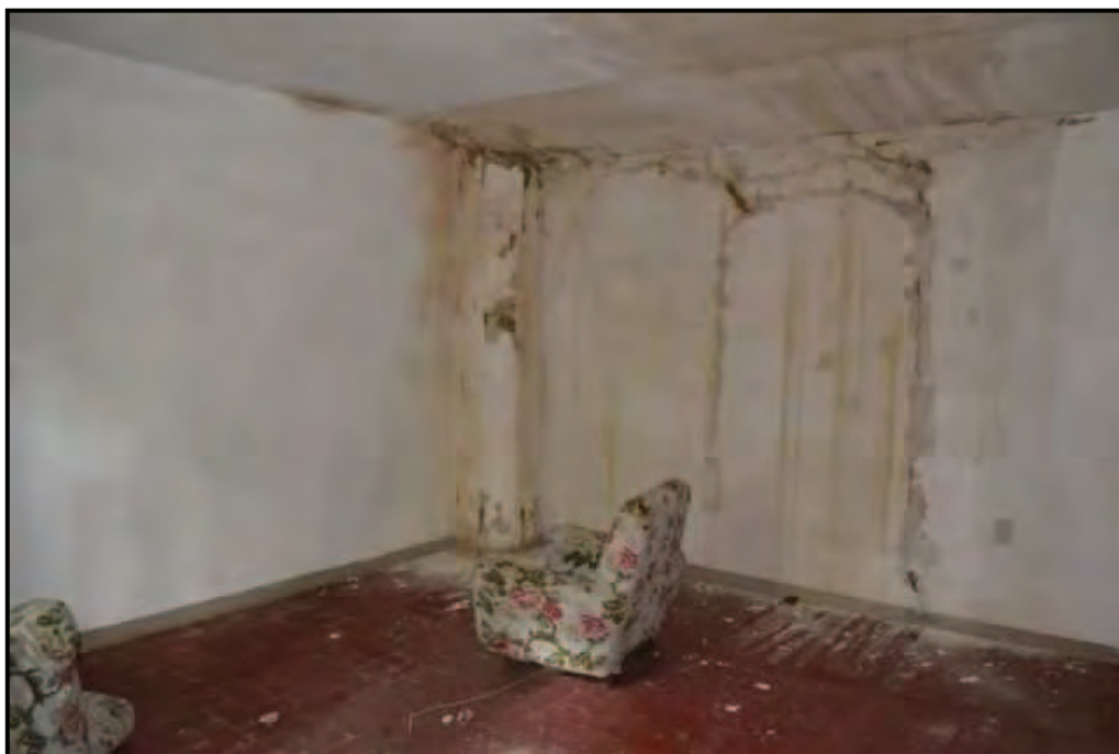
Fotografia n. 12 Edificio principale (F. 63/553/7) – Camera al piano primo
