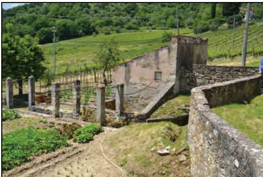
Fotografia n. 8 Il fabbricato Cannello (F. 63/64/501) – serra
