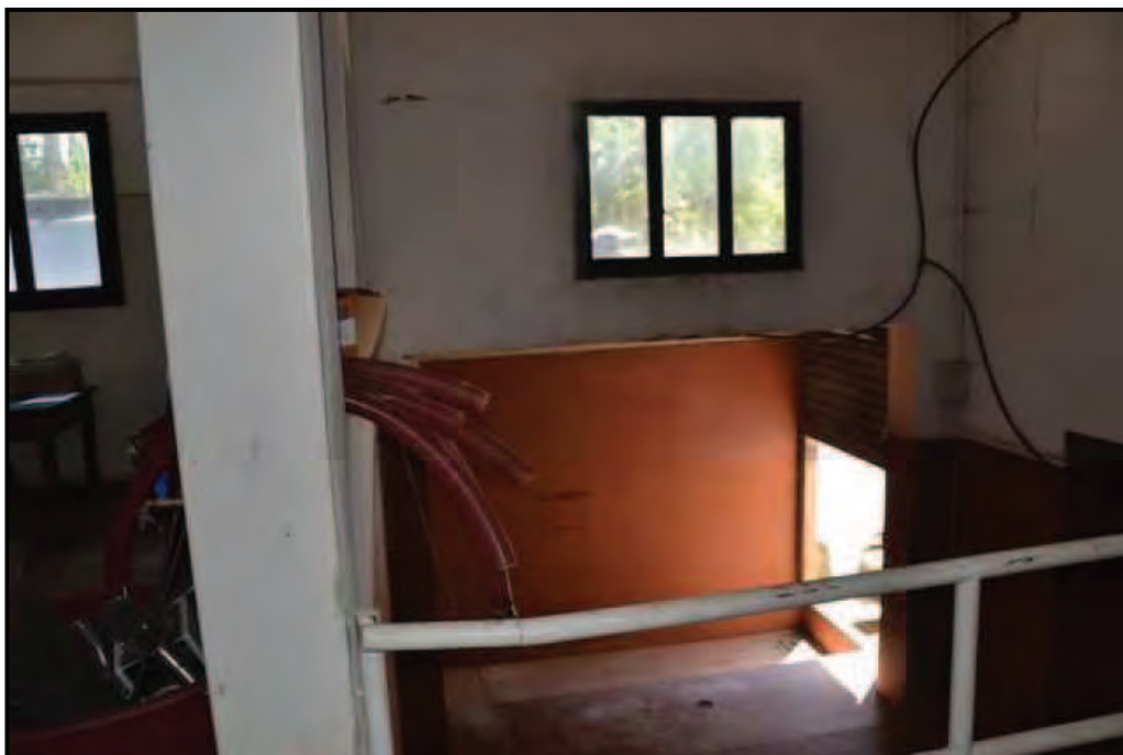
Fotografia n. 4 Cantina – Locale tecnico piano terreno, fronte verso valle
