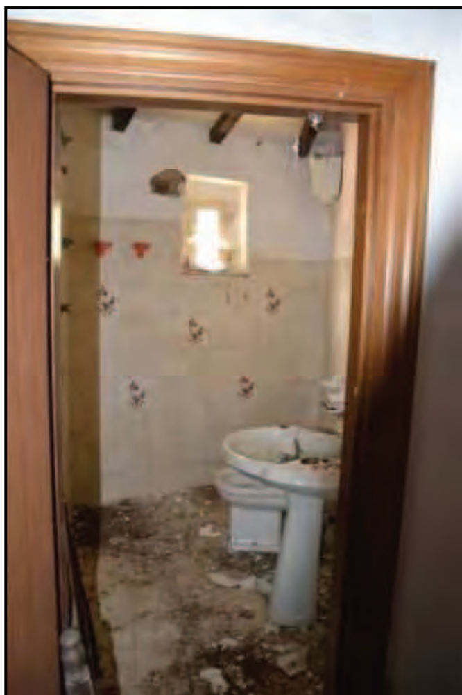
Fotografia n. 15 Edificio principale (F. 63/553/7) Servizio igienico al piano primo
