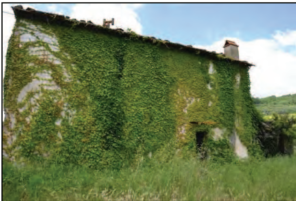
Fotografia n. 16 Podere San Martino – Edificio secondario (F. 63/555/2), fronte principale
