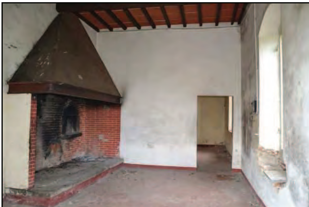
Fotografia n. 4 Podere Fontalli – Fabbricato principale (F. 64/142/2), cucina al piano terreno
