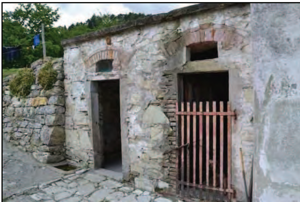
Fotografia n. 15 Podere Risorgimento (F. 63/553/2), ripostigli esterni al piano terreno
