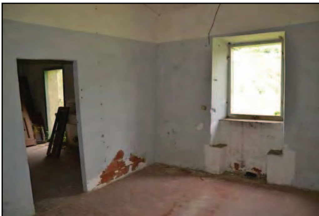
Fotografia n. 11 Podere San Martino – Edificio principale (F. 63/555/5), locale al piano terreno
