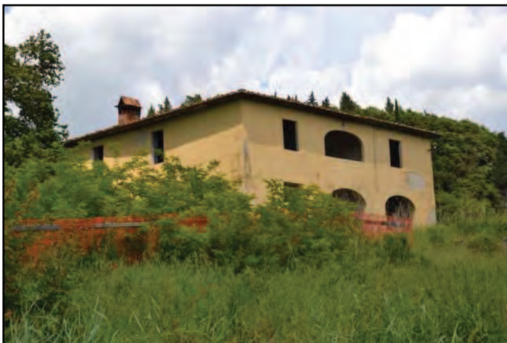
Fotografia n. 1 Podere Gaville – Fronte principale verso valle
