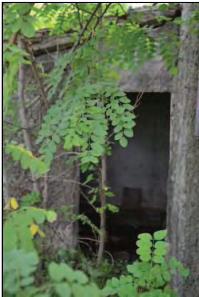
Fotografia n. 13 Podere San Pietro (F. 63/554/4) Ripostigli esterni
