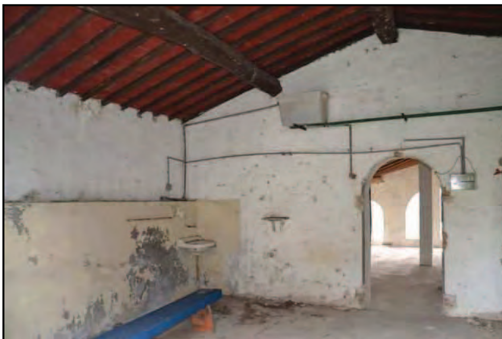
Fotografia n. 19 Podere Fontalli – Fienile(F. 64/142/4) interno al piano terreno
