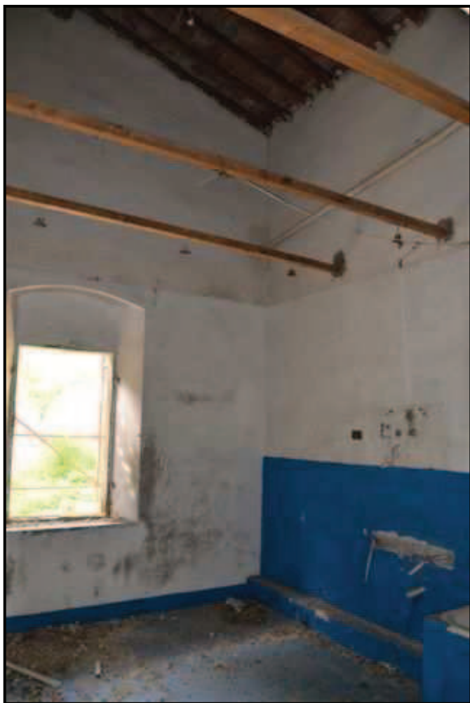
Fotografia n. 13 Podere Fontalli – Fabbricato principale (F. 64/142/2) bagno al piano primo
