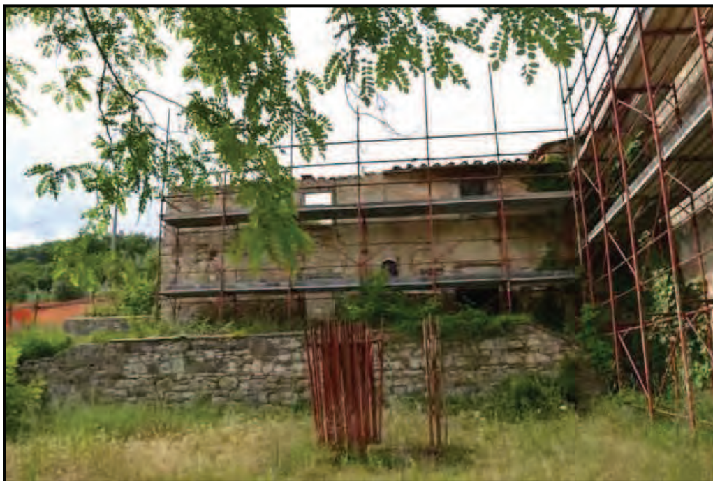
Fotografia n. 14 Podere Fontalli – Fabbricato principale (F. 64/142/3), particolare dell'annesso
