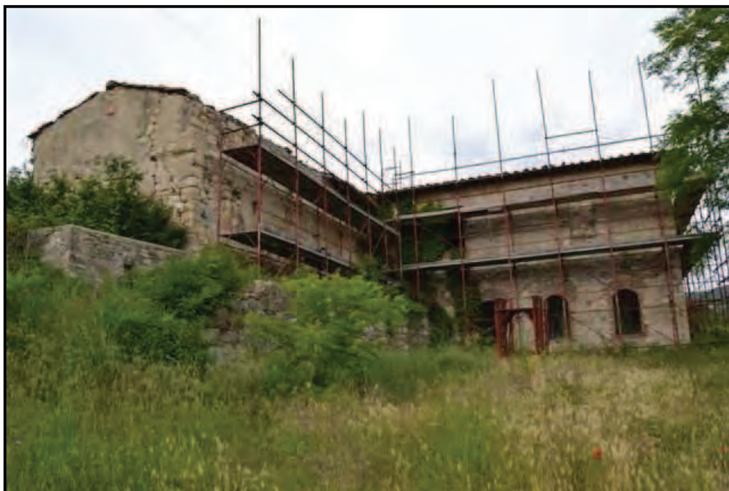
Fotografia n. 1 Podere Fontalli – Fabbricato principale
