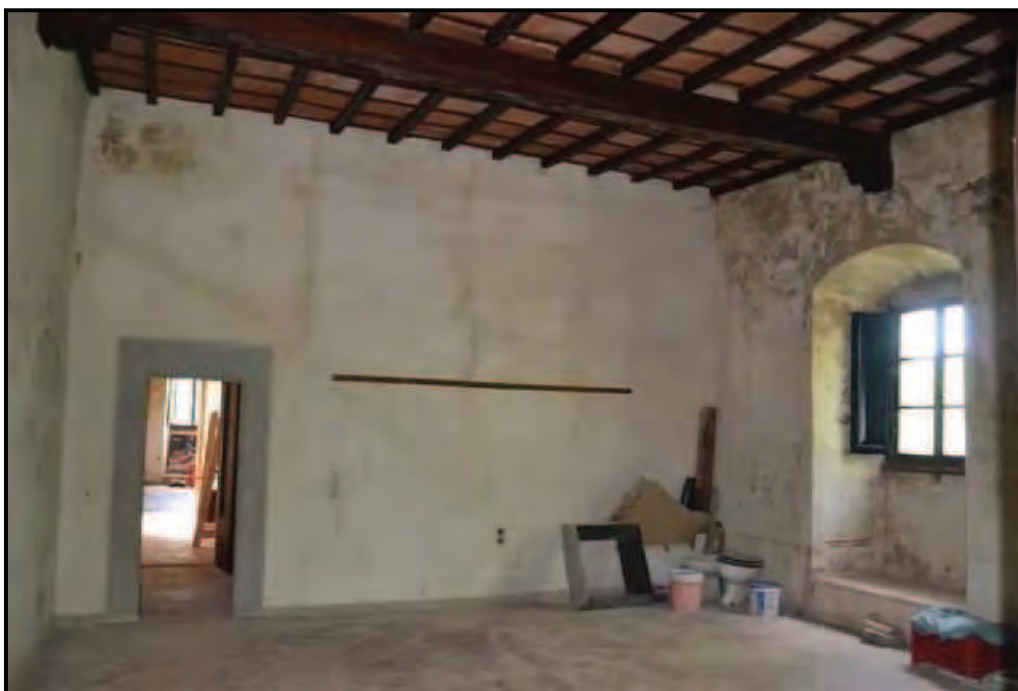
Fotografia n. 72 Castello – Camera al piano primo con accesso al loggiato
