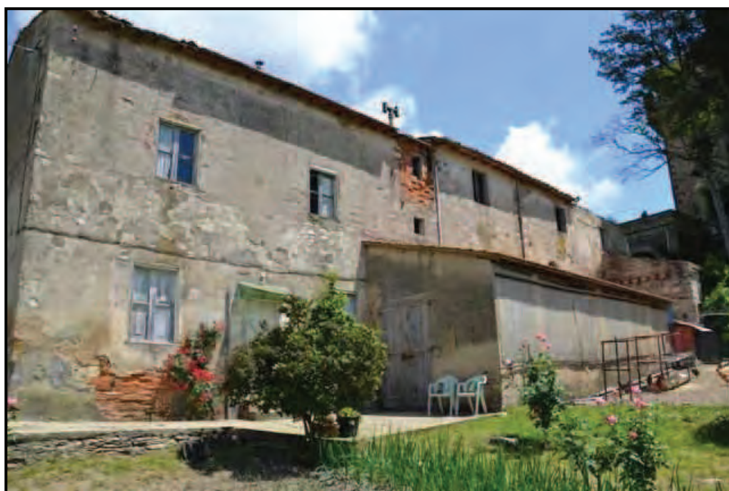
Fotografia n. 18 Il fabbricato Giardino (F. 63/64/2) – Fronte verso valle
