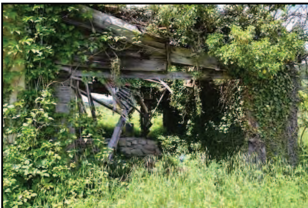
Fotografia n. 18 Podere San Martino – Edificio secondario (F. 63/555/2), tettoia sul fronte laterale
