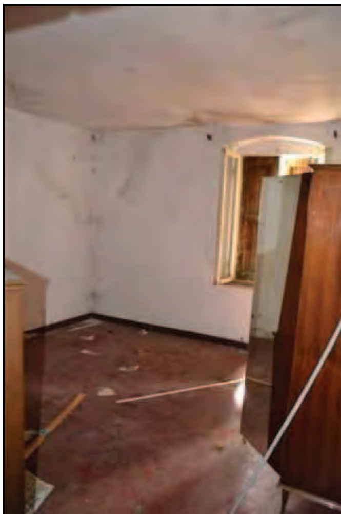
Fotografia n. 13 Edificio principale (F. 63/553/7) Camera al piano primo
