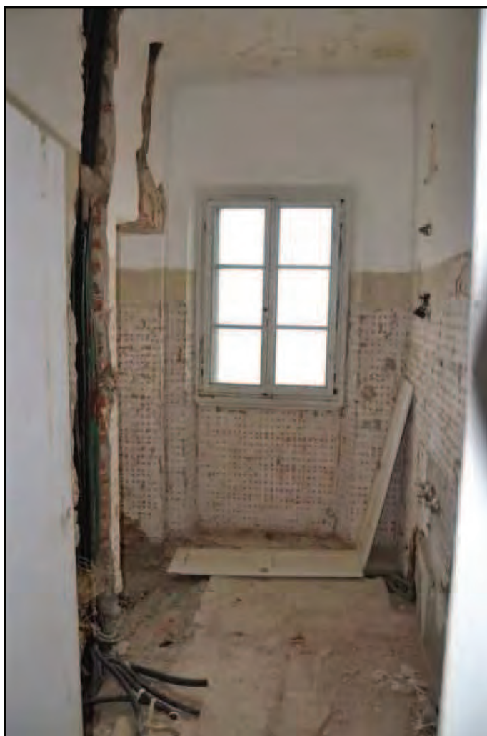
Fotografia n. 64 Castello – Servizio igienico al piano primo
