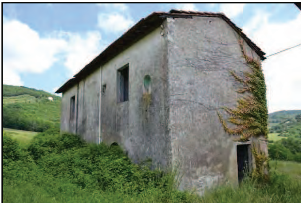
Fotografia n. 17 Podere San Martino – Edificio secondario (F. 63/555/2), fronte posteriore e laterale
