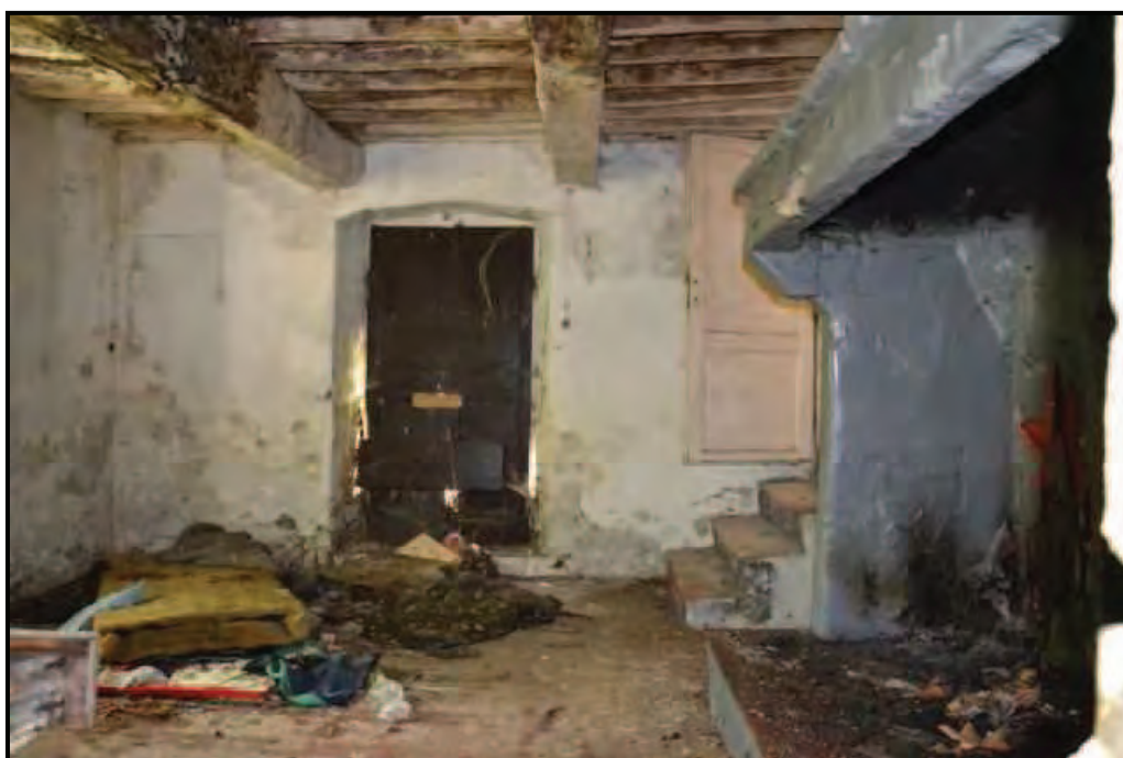
Fotografia n. 16 Edificio principale (F. 63/553/5) – Cucina al piano terreno
