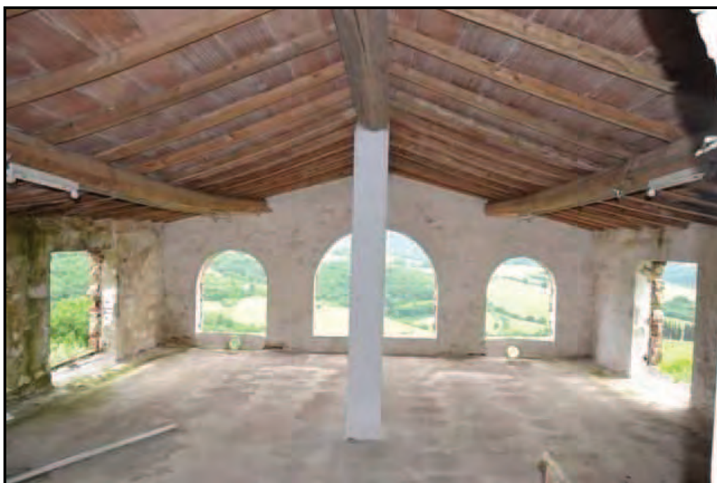
Fotografia n. 20 Podere Fontalli – Fienile (F. 64/142/4), interno al piano terreno
