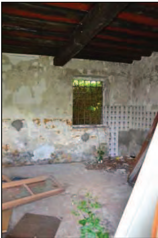
Fotografia n. 19 Podere San Martino Edificio secondario (F. 63/555/2) Cucina al piano terreno
