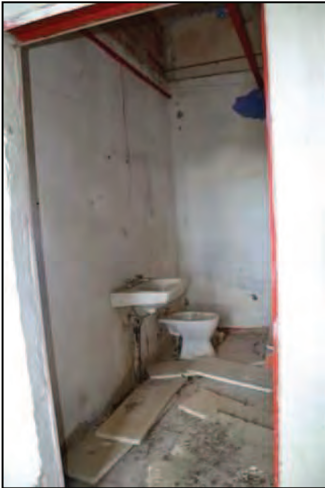
Fotografia n. 7 Podere Le Vigne (F. 73/141) Servizio igienico al piano terreno
