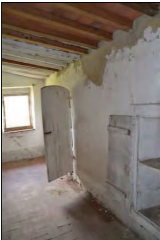
Fotografia n. 9 Podere San Martino – Edificio principale Locale al piano terreno
