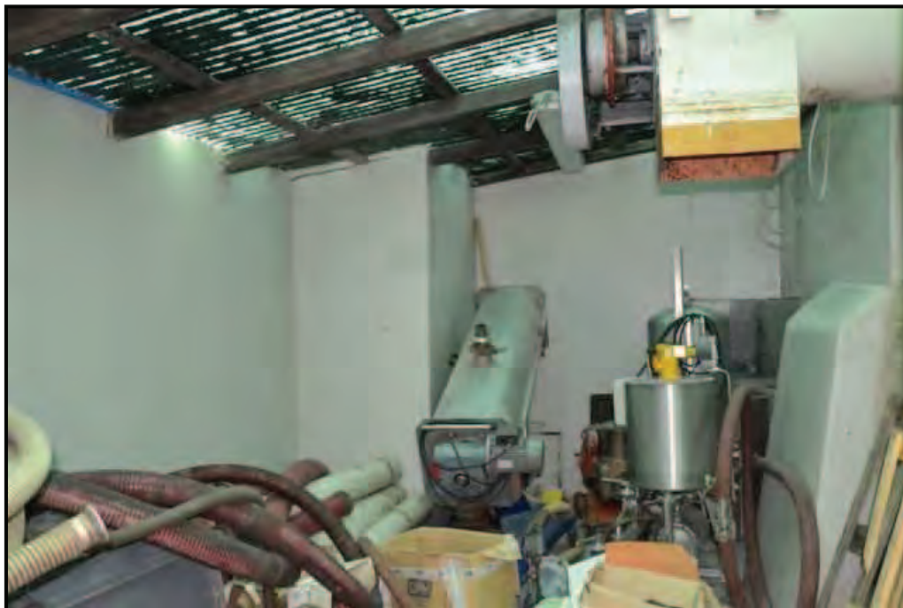
Fotografia n. 14 Cantina – Magazzino esterno, piano terreno
