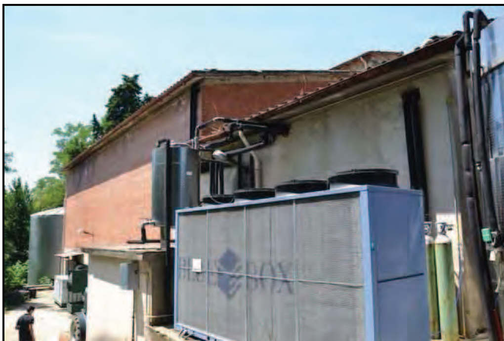
Fotografia n. 2 Cantina – Fronte verso valle
