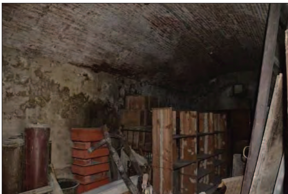
Fotografia n. 10 Castello – Altro ambiente al piano terreno/seminterrato adiacente il frantoio
