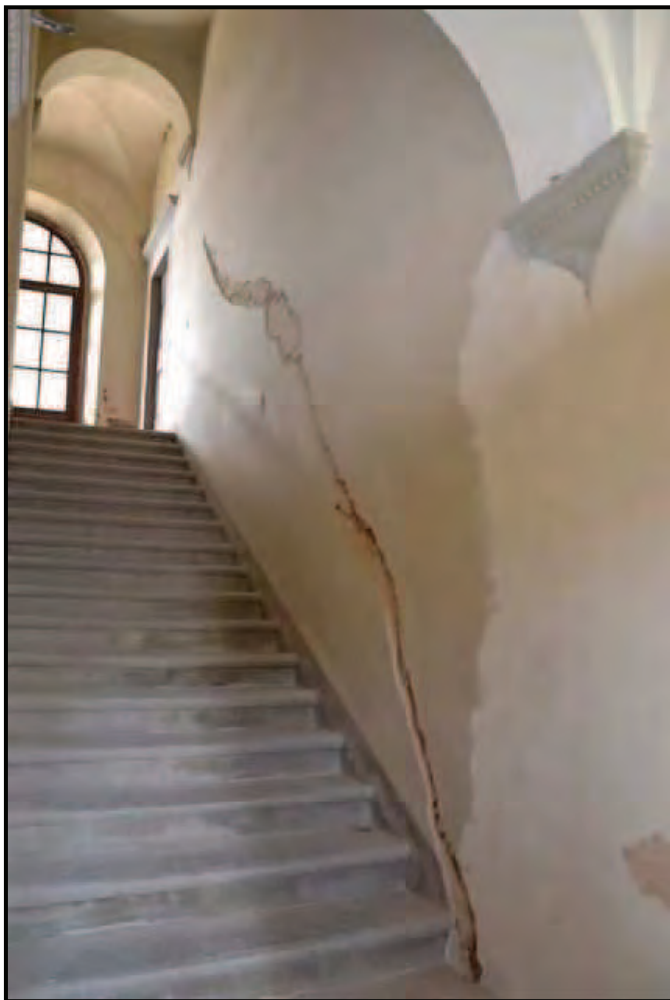
Fotografia n. 59 Castello – Scalone principale di collegamento col piano primo
