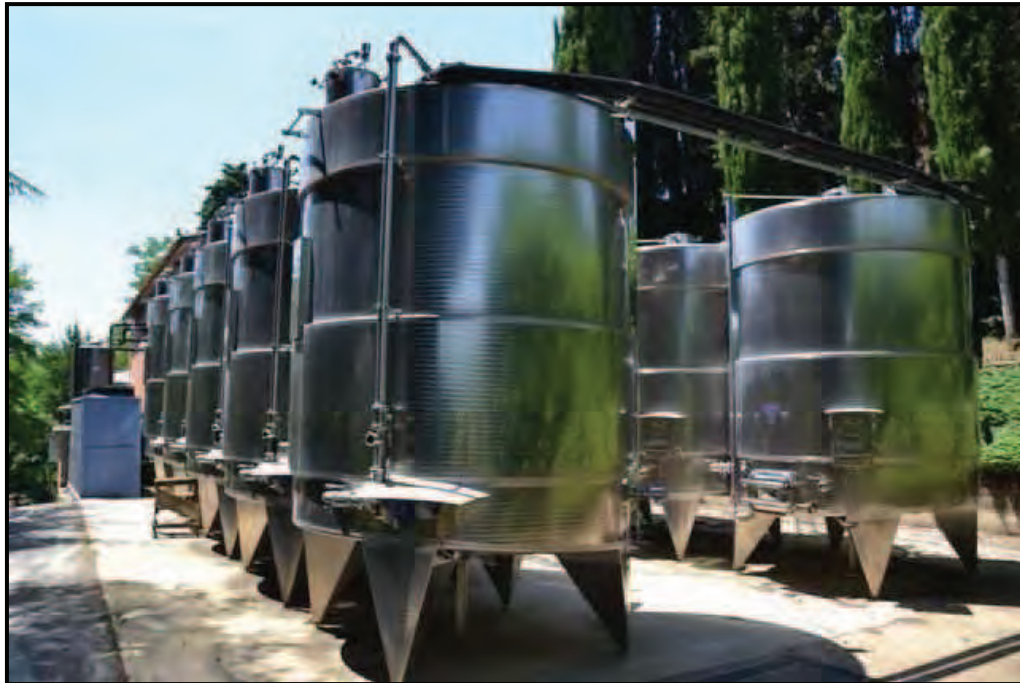
Fotografia n. 3 Tini esterni alla cantina – Fronte verso valle
