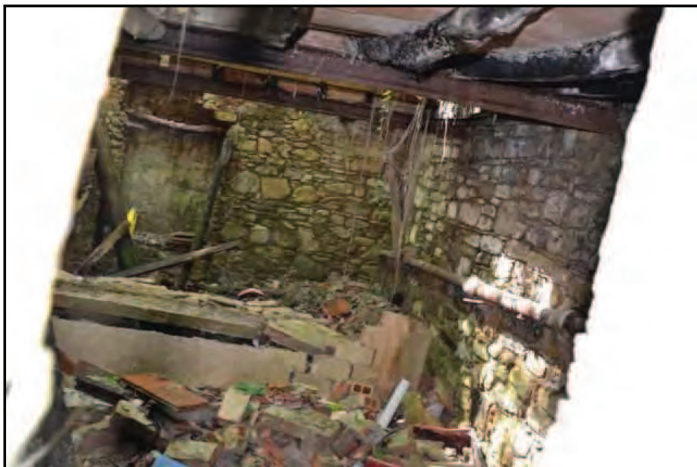
Fotografia n. 22 Edificio principale (F. 63/553/4) – Deposito al piano terreno
