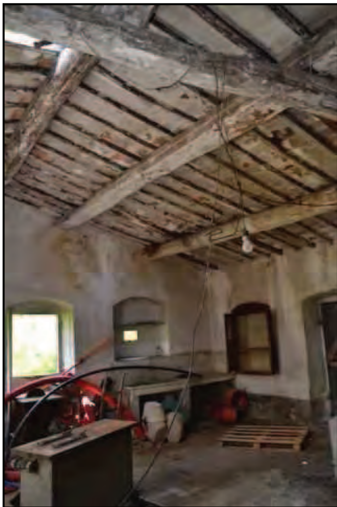
Fotografia n. 11 Il fabbricato Canello (F. 63/64/500) Altra vista della cucina al piano primo
