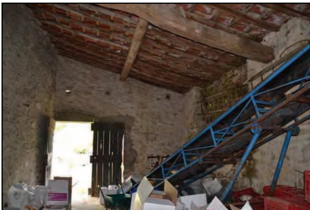
Fotografia n. 7 Annesso agricolo – Magazzino piano terreno
