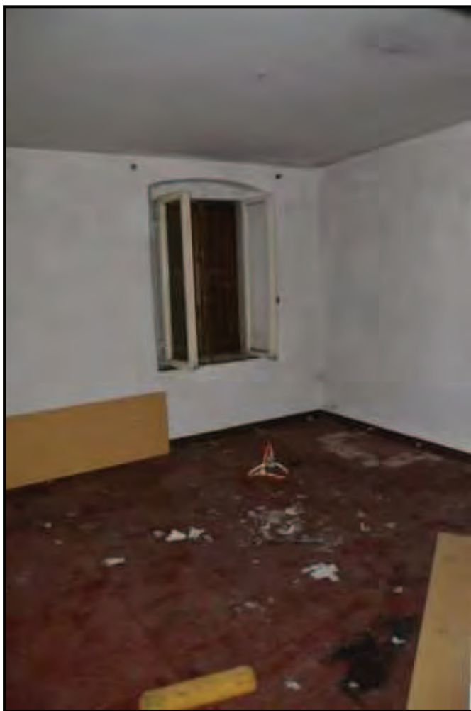
Fotografia n. 11 Edificio principale (F. 63/553/7) Camera al piano primo
