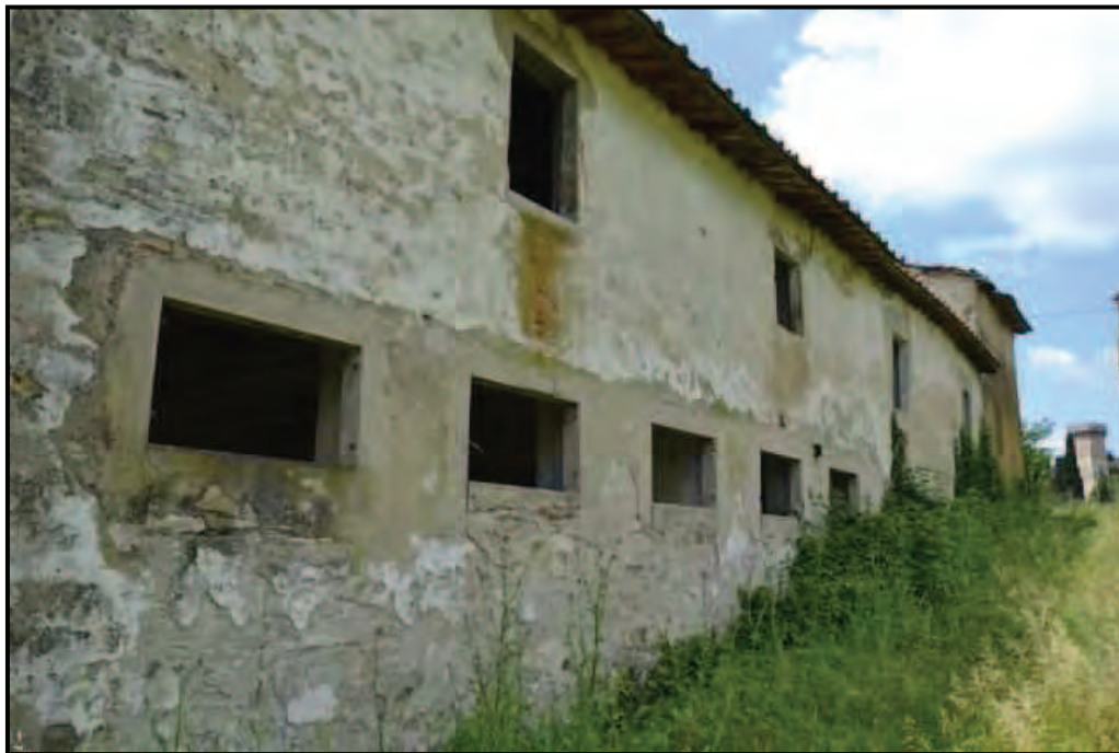
Fotografia n. 3 Podere San Martino – Edificio principale, fronte laterale
