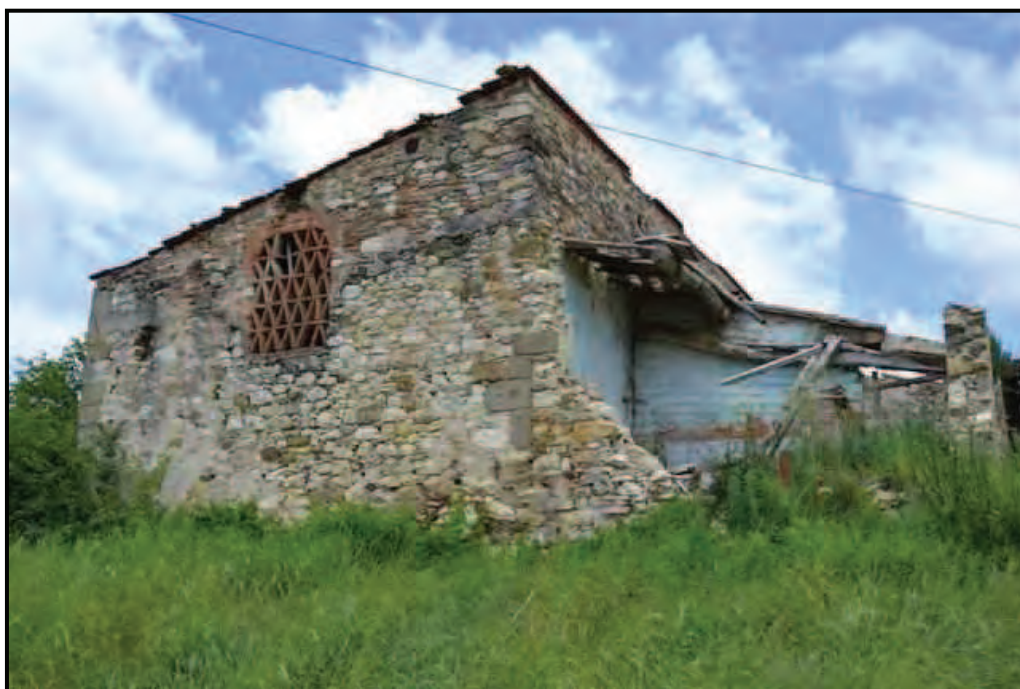
Fotografia n. 26 Podere San Martino – Fienile, fronte verso valle (F. 63/555/3)
