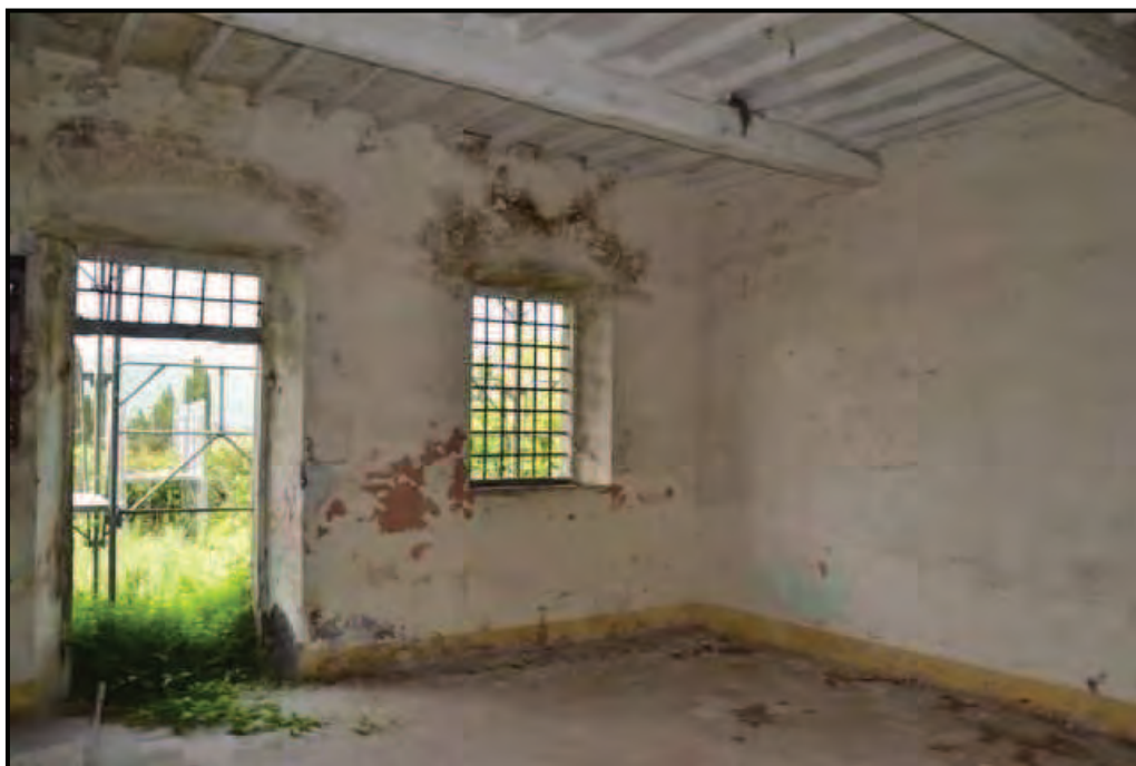
Fotografia n. 5 Podere San Pietro (F. 63/554/3) – Locale al piano terreno
