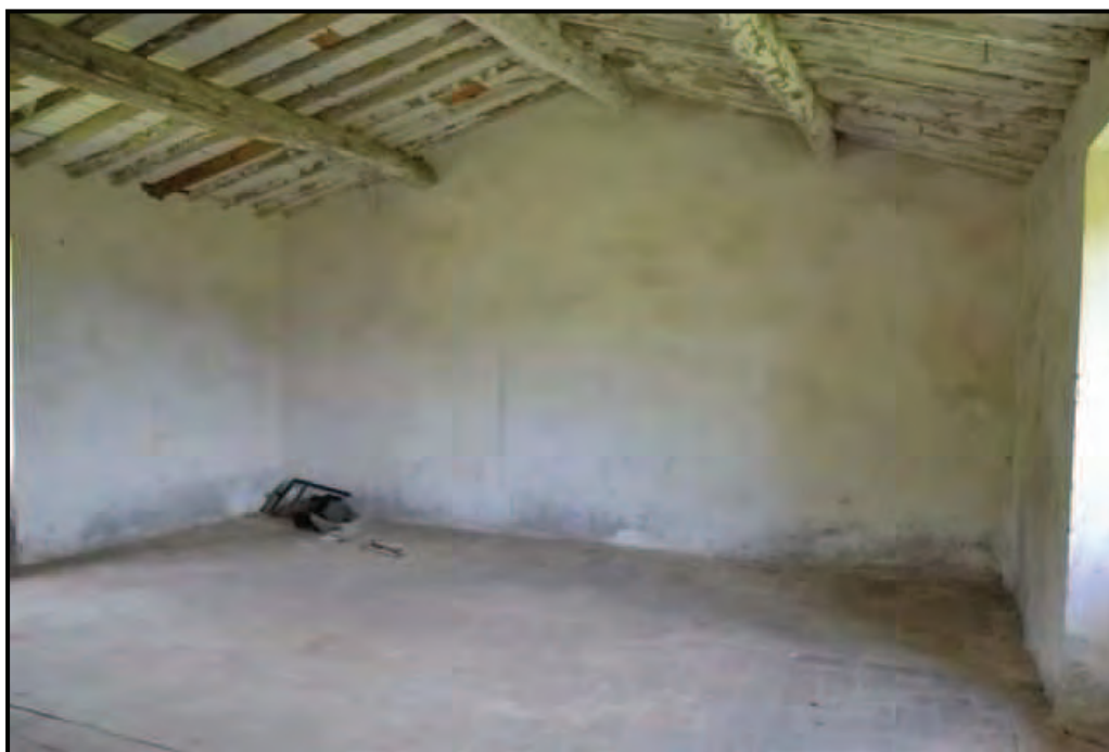
Fotografia n. 14 Podere San Martino – Edificio principale (F. 63/555/5), locale al piano terreno
