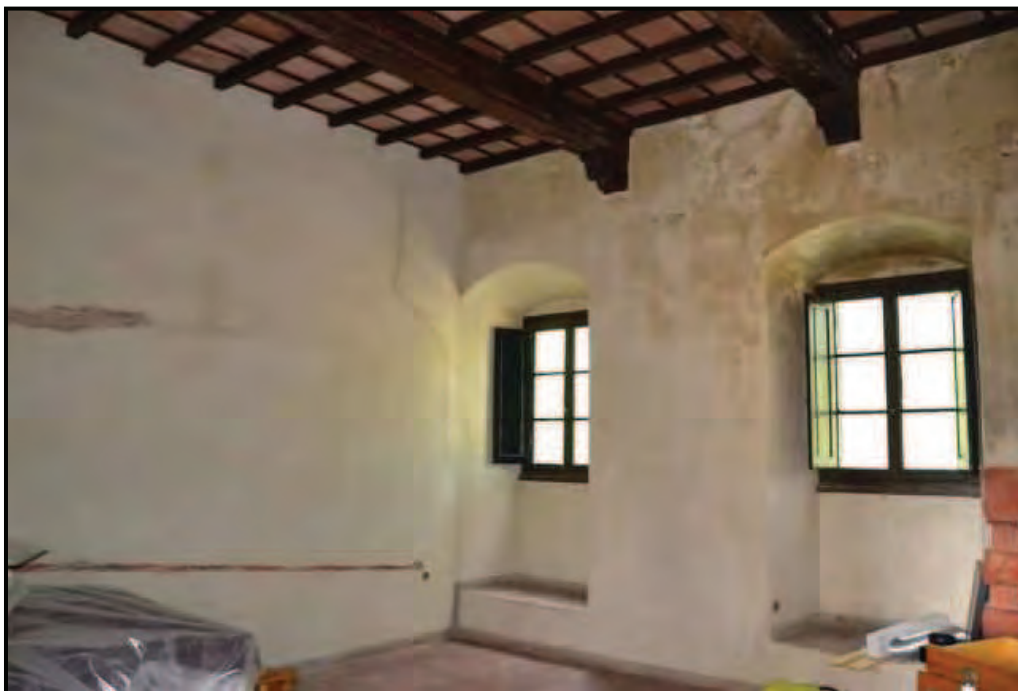
Fotografia n. 71 Castello – Camera al piano primo con accesso al loggiato
