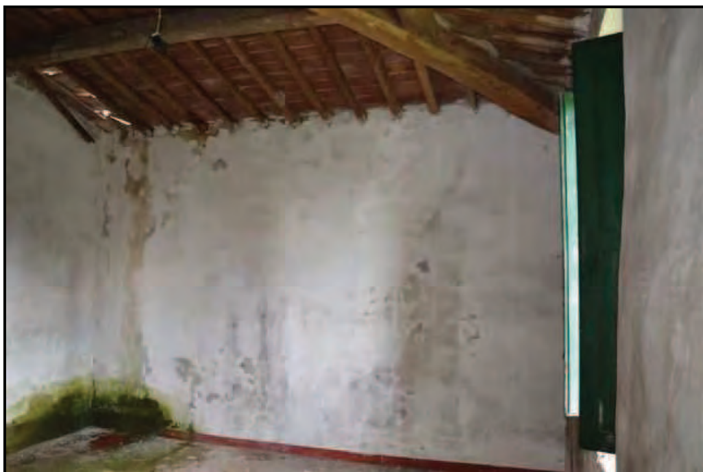
Fotografia n. 12 Podere Le Vigne (F. 73/141), camera al piano primo
