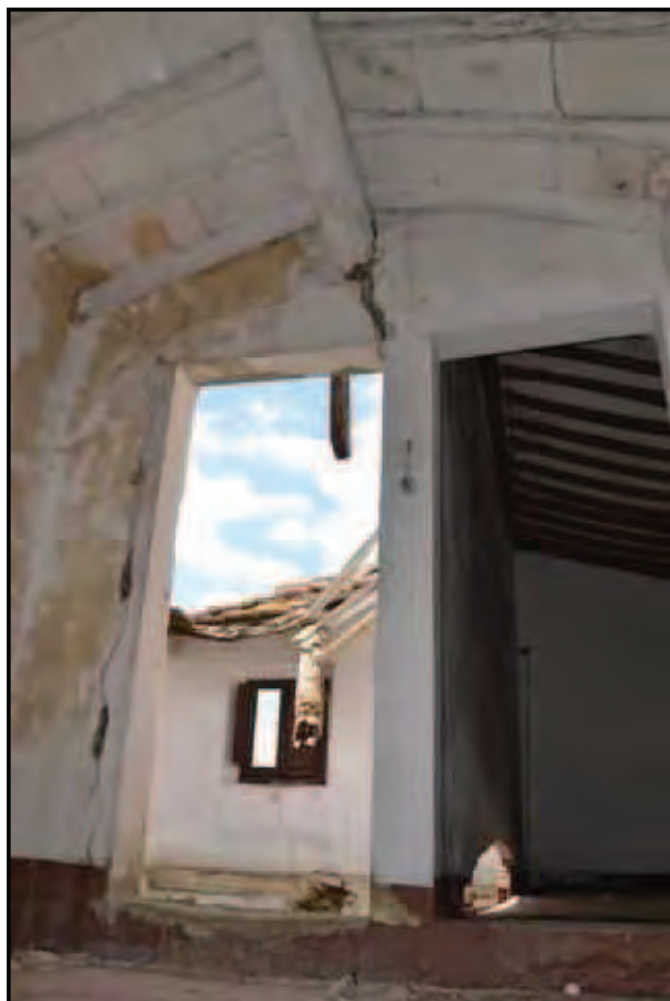
Fotografia n. 15 Podere San Martino – Edificio principale (F. 63/555/5) Locali al piano terreno
