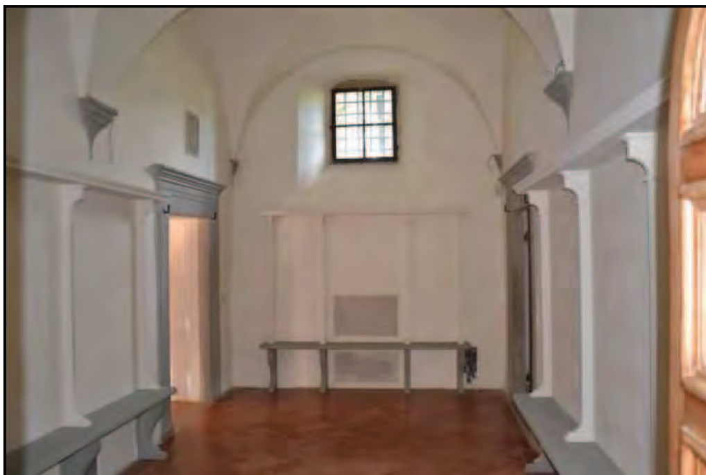
Fotografia n. 35 Castello – Locale di disimpegno al piano terreno
