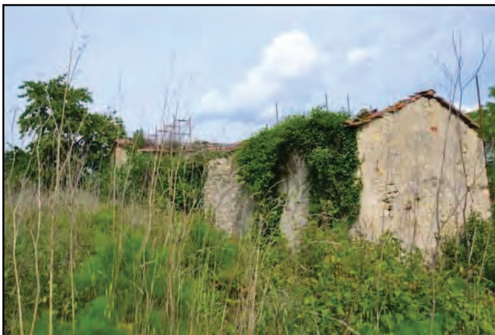
Fotografia n. 3 Podere Fontalli – Fabbricato principale, fronte verso monte
