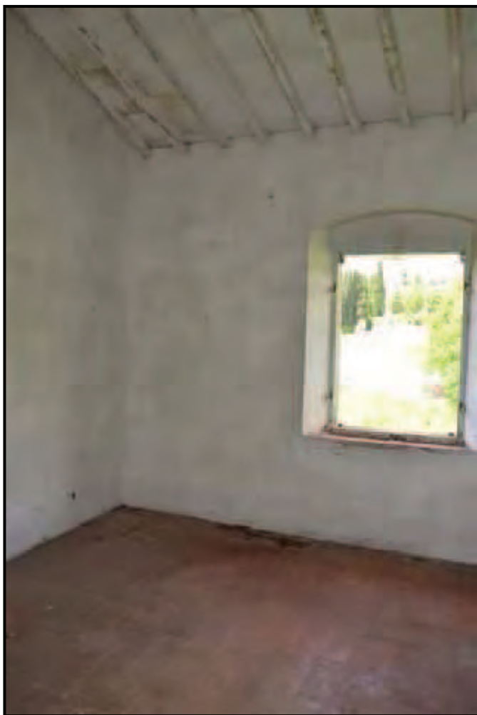
Fotografia n. 23 Podere San Martino Edificio secondario (F. 63/555/2) Camera al piano primo
