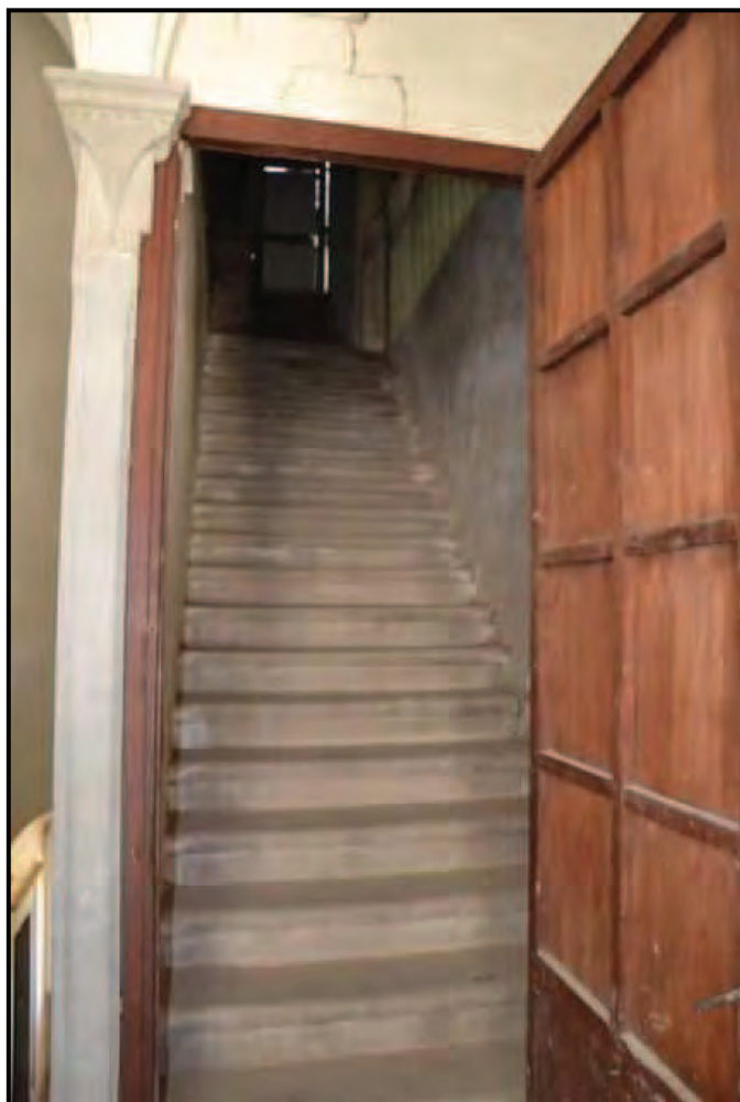
Fotografia n. 77 Castello – Scale di collegamento al piano sottotetto
