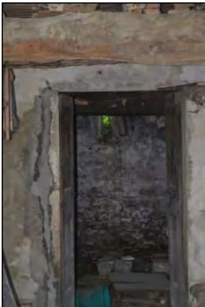
Fotografia n. 6 Podere San Martino (F. 63/555/4) Edificio principale, magazzini al piano seminterrato
