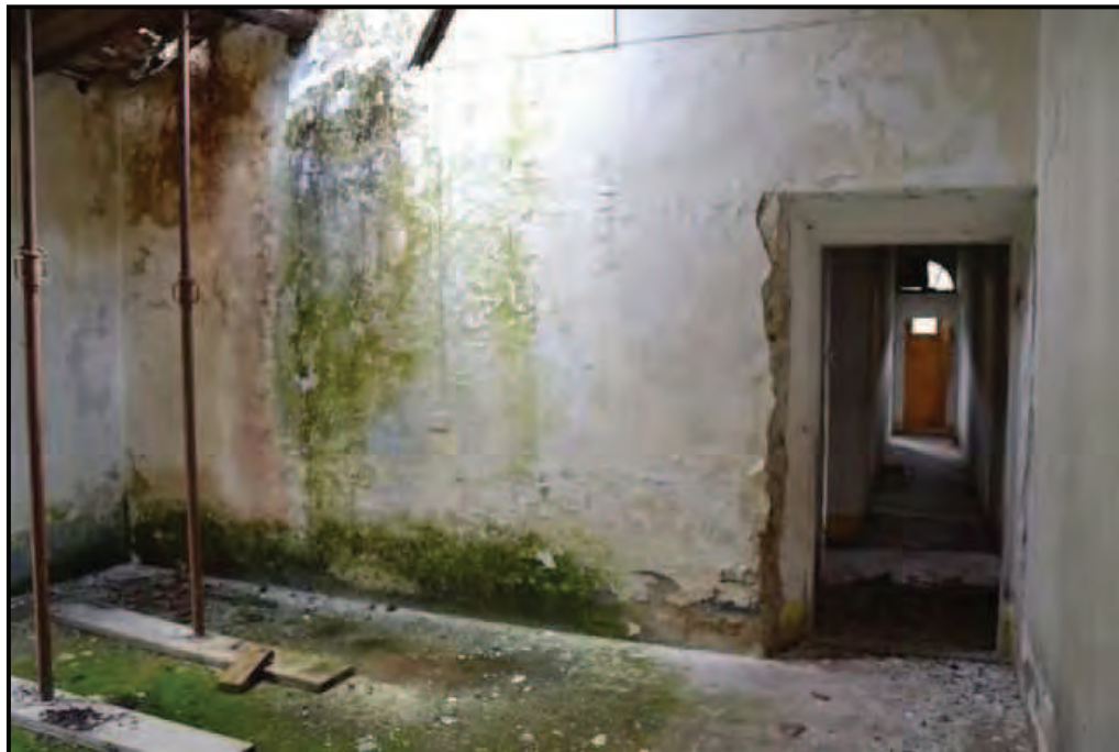
Fotografia n. 18 Podere San Pietro (F. 63/554/5) – Camera al piano primo
