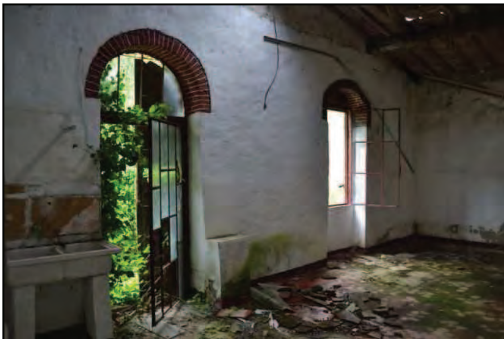
Fotografia n. 11 Podere Le Vigne (F. 73/141), camera al piano primo
