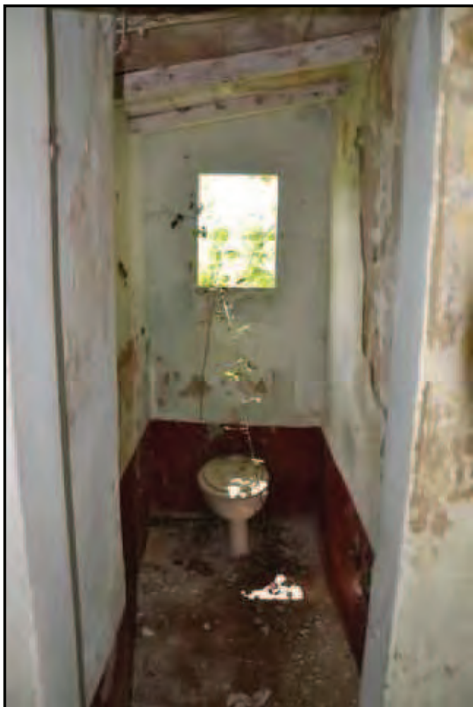
Fotografia n. 13 Podere San Martino Edificio principale (F. 63/555/5) Servizio igienico al piano terreno
