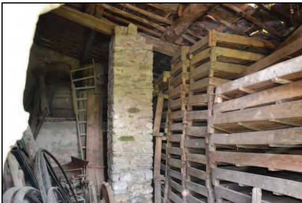
Fotografia n. 8 Annesso agricolo – Magazzino piano terreno
