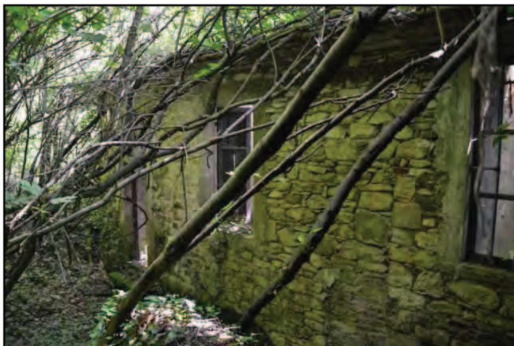
Fotografia n. 4 Edificio principale – Fronte posteriore
