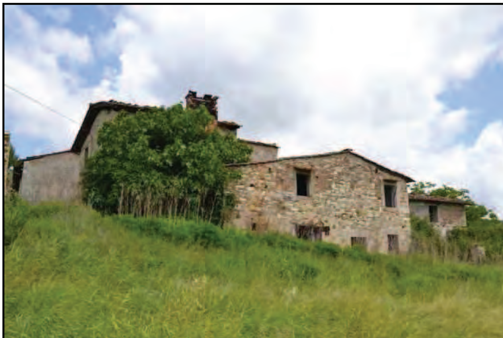
Fotografia n. 4 Podere San Martino – Edificio principale, fronte verso valle
