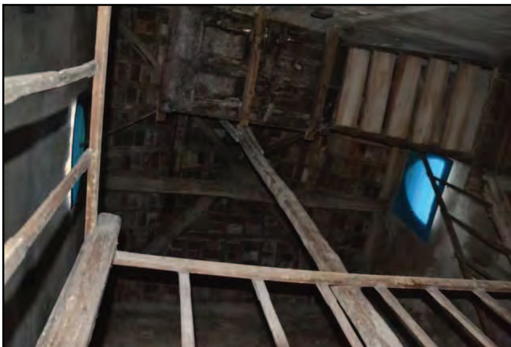
Fotografia n. 81 Castello – Interno della torre
