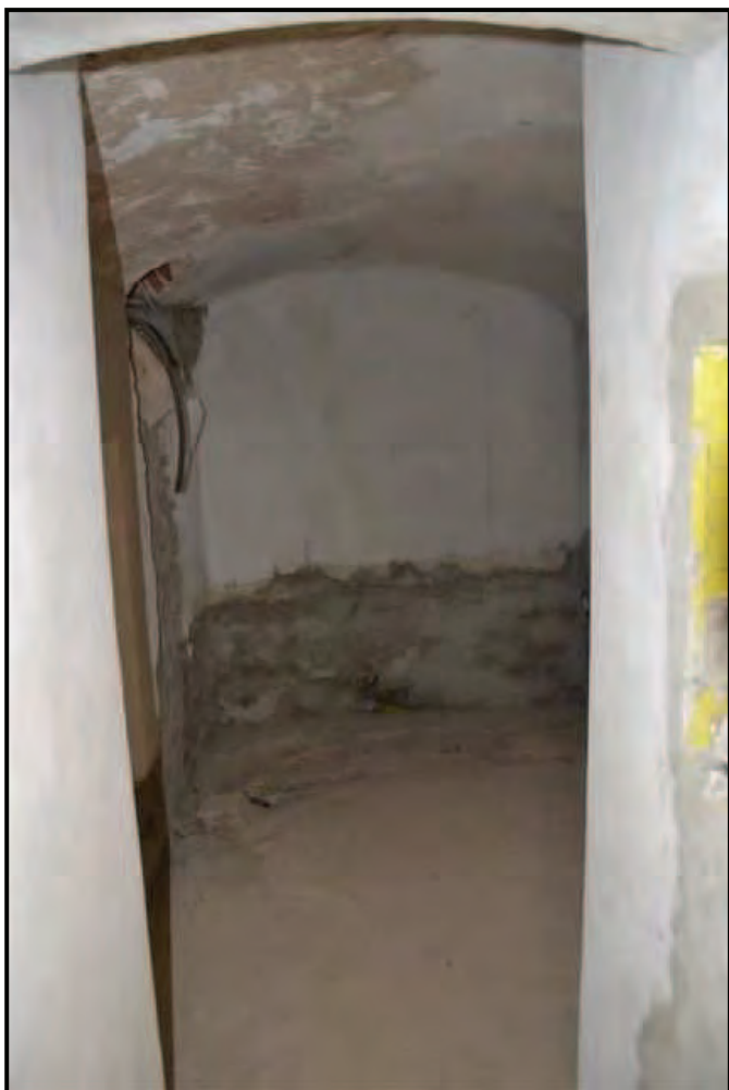
Fotografia n. 43 Castello – Vano al piano ammezzato
