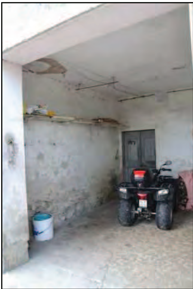
Fotografia n. 13 Podere Risorgimento (F. 63/553/2) Deposito al piano terreno
