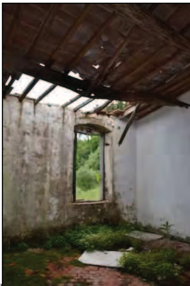
Fotografia n. 10 Podere Le Vigne (F. 73/141), camera al piano primo
