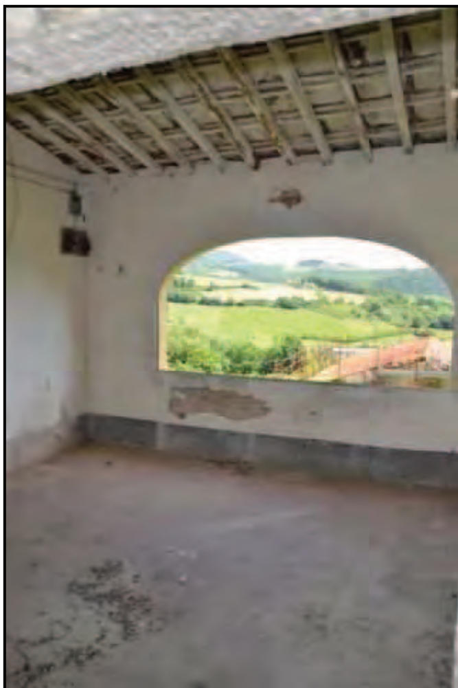
Fotografia n. 19 Podere Gaville – U.I. F. 63/59/502, loggia al piano primo
