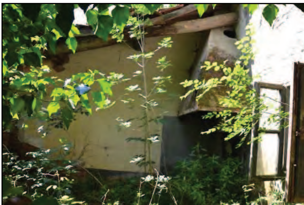
Fotografia n. 24 Edificio principale (F. 63/553/5) – Cucina al piano primo
