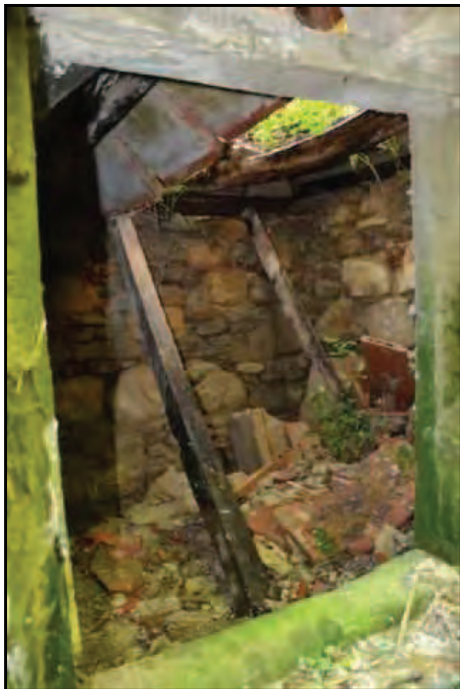
Fotografia n. 21 Edificio principale (F. 63/553/4) Ripostiglio al piano terreno
