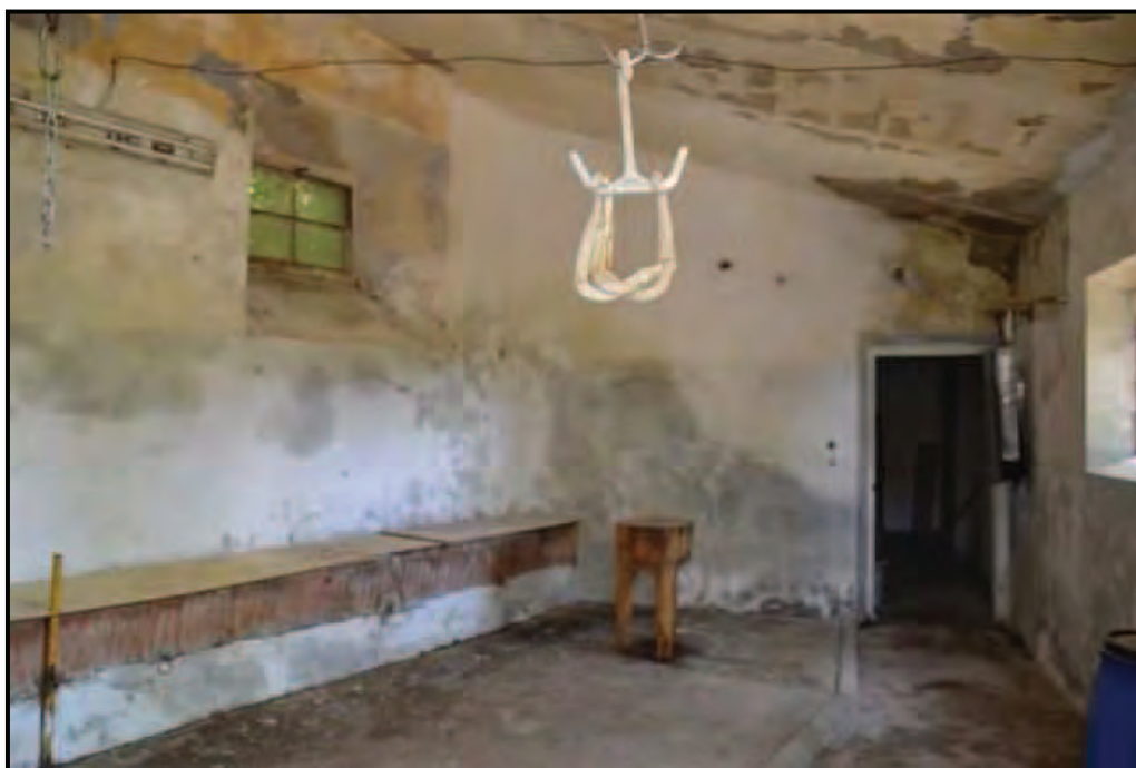
Fotografia n. 13 Podere Rimaggio - Fabbricato principale (F. 64/143/3), stalla al piano terreno
