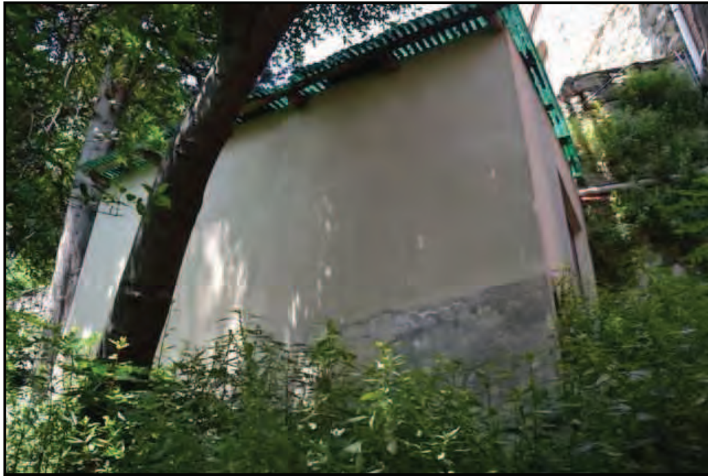
Fotografia n. 13 Cantina – Magazzino esterno, piano terreno
