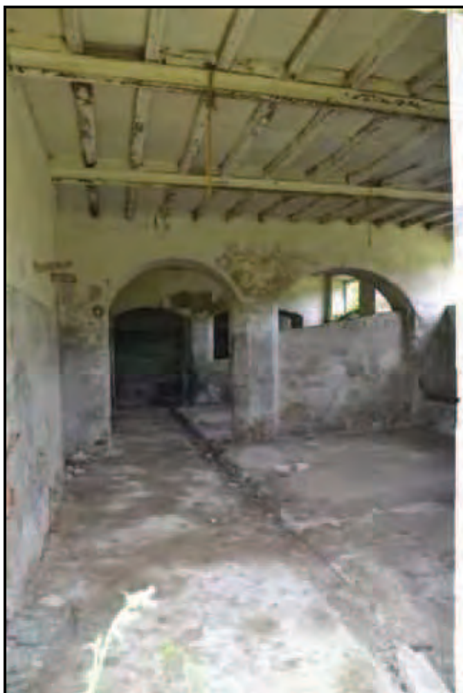
Fotografia n. 5 Podere San Martino Edificio principale (F. 63/555/4) Stalle al piano seminterrato
