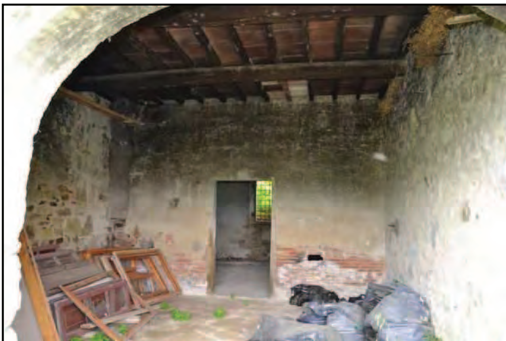
Fotografia n. 12 Podere San Pietro (F. 63/554/4) – Stalle al piano terreno
