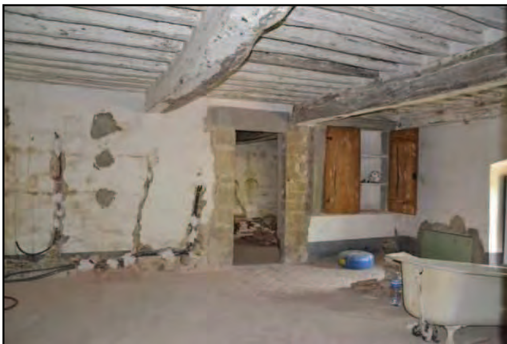
Fotografia n. 44 Castello – Locale al piano ammezzato
