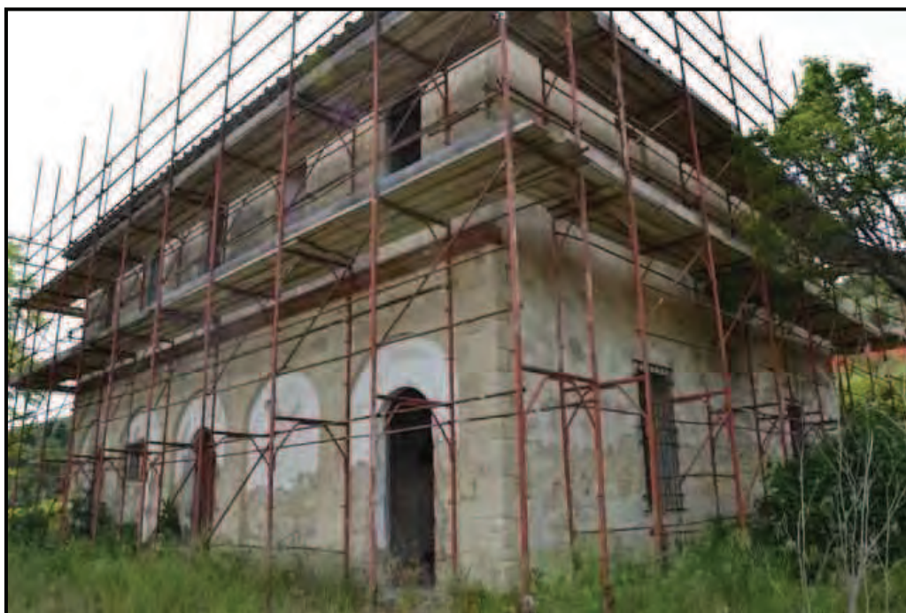
Fotografia n. 2 Podere Fontalli - Fabbricato principale
