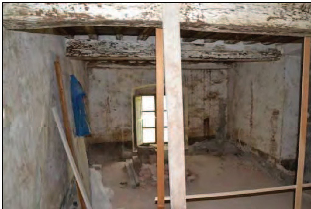
Fotografia n. 45 Castello – Locale al piano ammezzato
