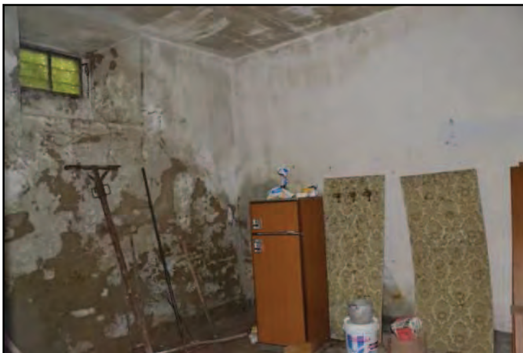
Fotografia n. 14 Podere Rimaggio – Fabbricato principale (F. 64/143/3), magazzino al piano terreno
