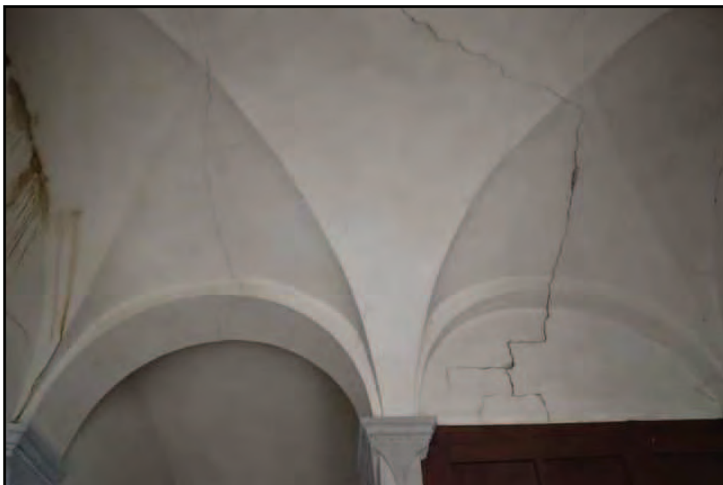
Fotografia n. 60 Castello – Volte del pianerottolo di disimpegno al piano primo
