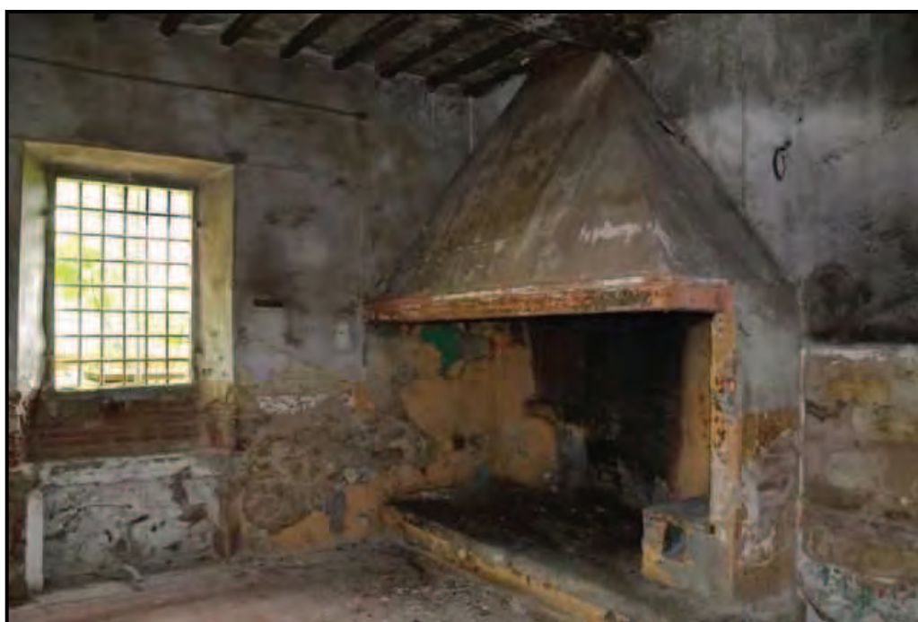
Fotografia n. 6 Podere San Pietro (F. 63/554/3) –Cucina al piano terreno
