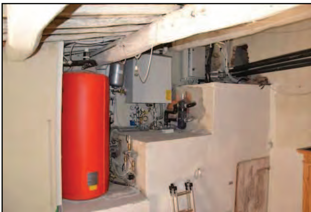
Fotografia n. 58 Castello – Locale tecnico al piano ammezzato
