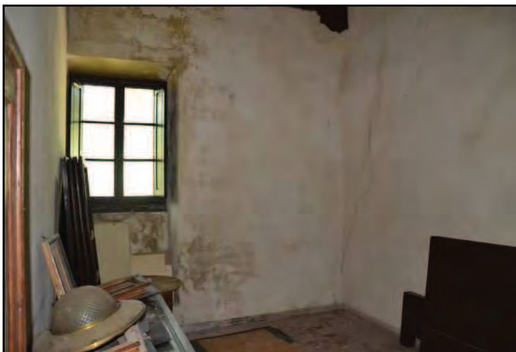
Fotografia n. 66 Castello – Camera al piano primo
