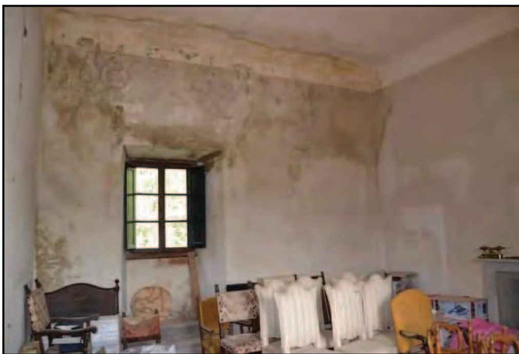
Fotografia n. 74 Castello – Camera al piano primo
