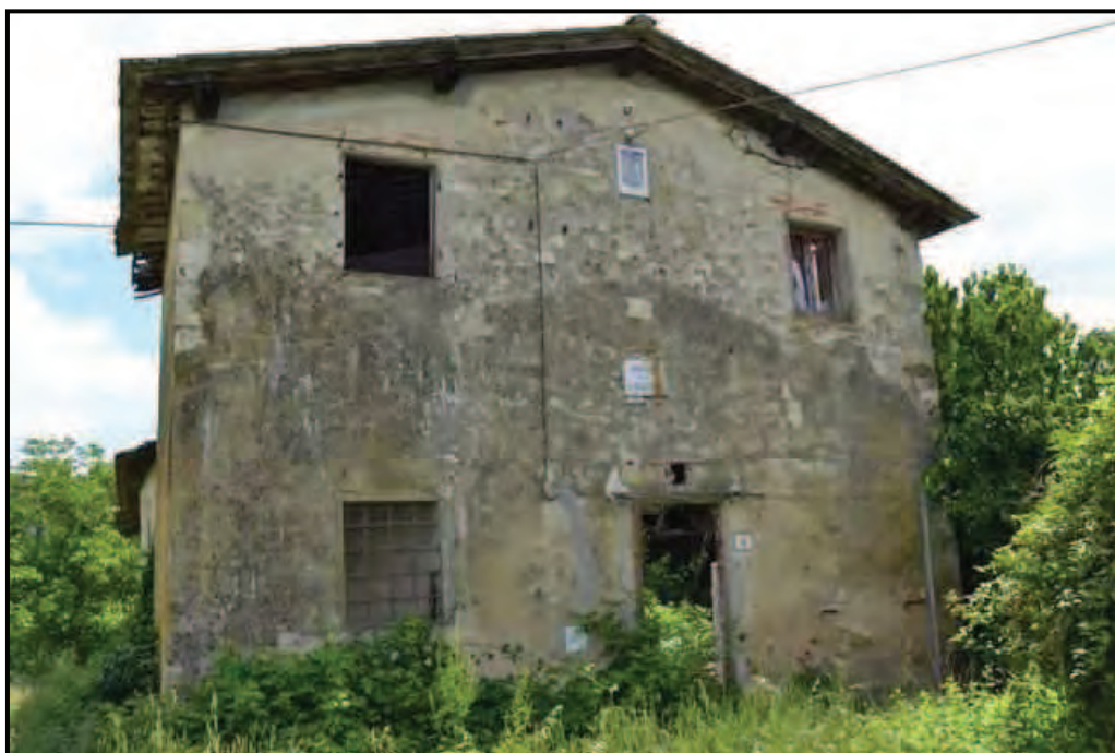
Fotografia n. 2 Podere San Martino – Edificio principale
