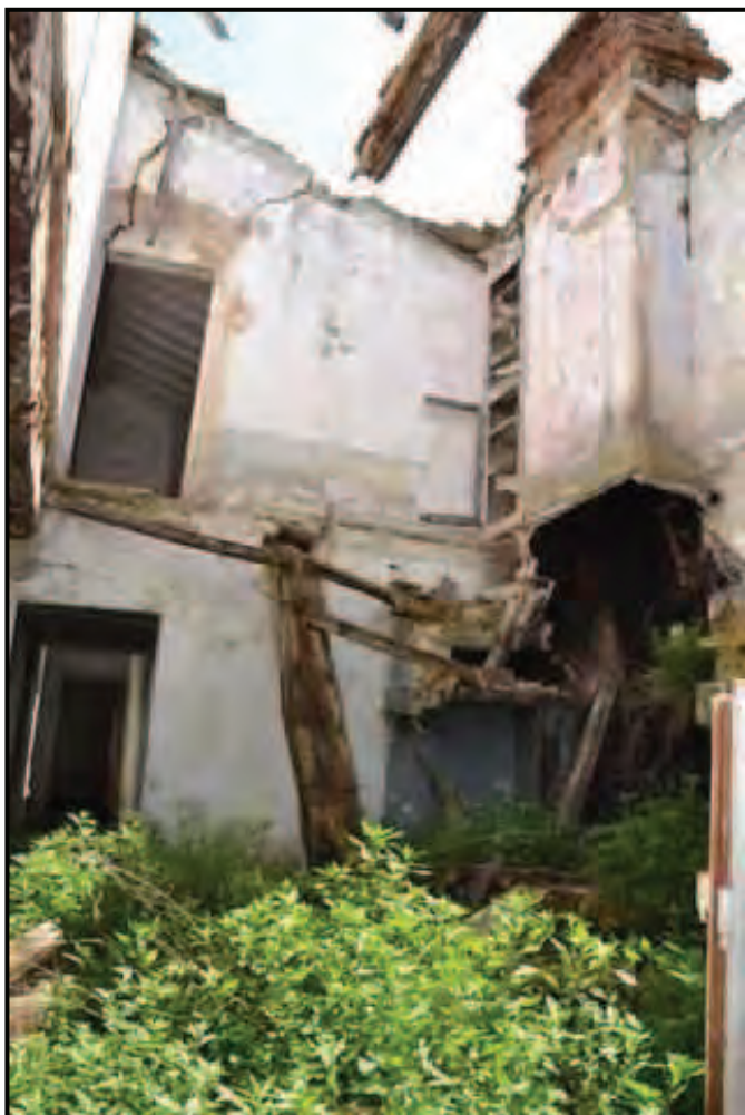
Fotografia n. 7 Podere San Martino Edificio principale (F. 63/555/5) Cucina al piano terreno
