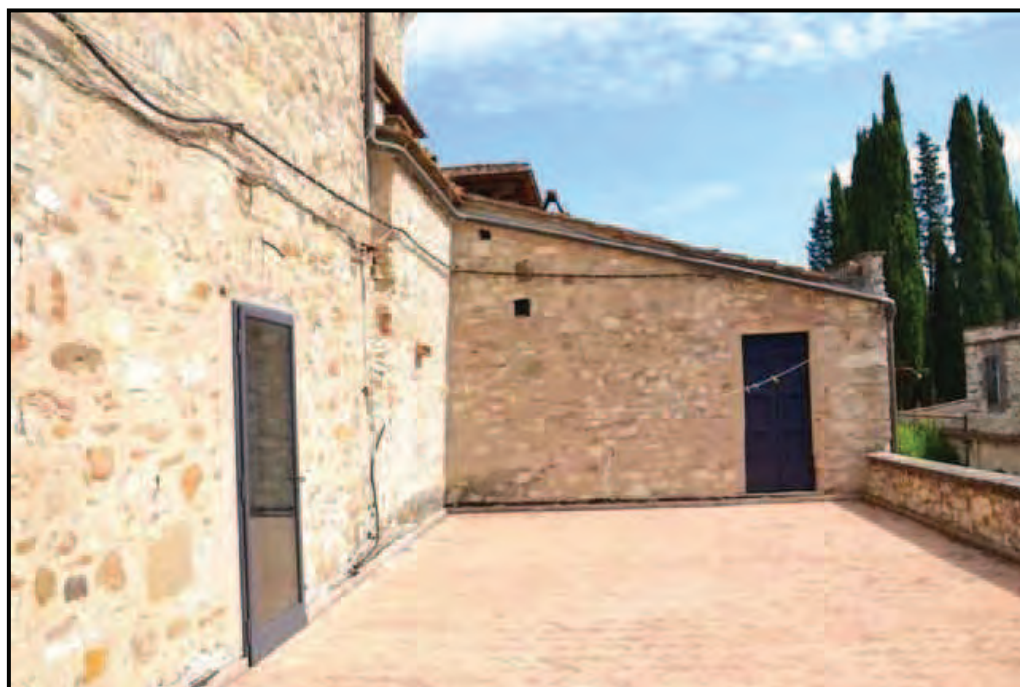
Fotografia n. 24 Castello – Terrazza al piano terreno
