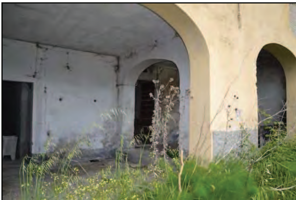
Fotografia n. 4 Podere Gaville – U.I. F. 63/59/501, loggia sul fronte principale al piano terreno
