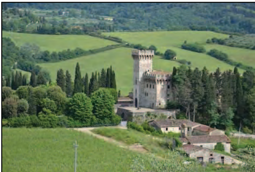
Fotografia n. 1 Il Castello di Torre a Decima
