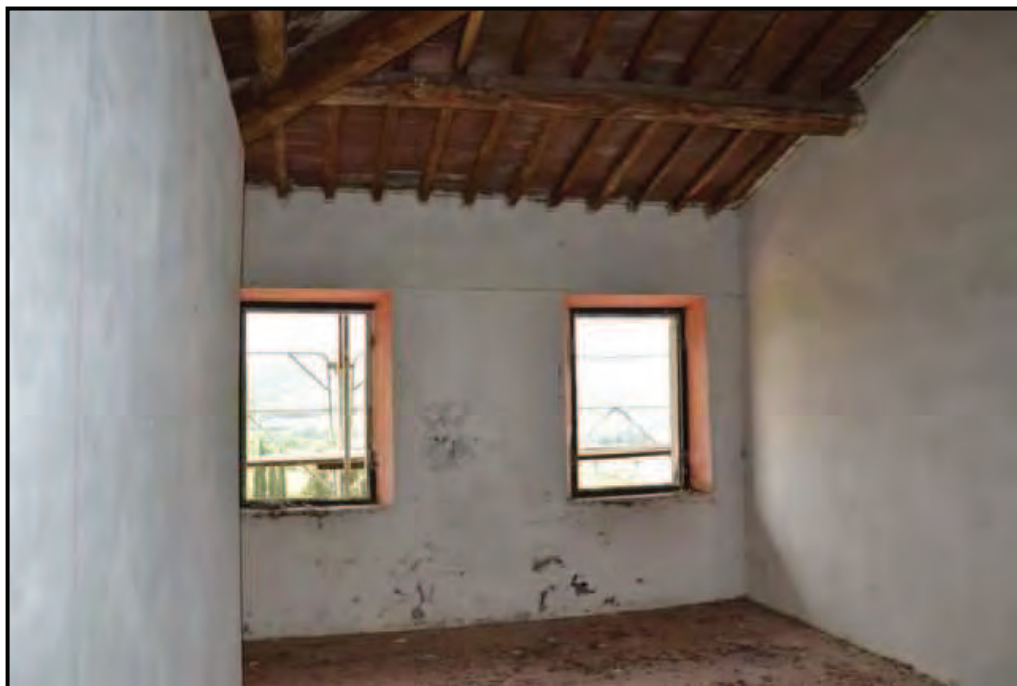
Fotografia n. 10 Podere San Pietro (F. 63/554/3) – Camera al piano primo
