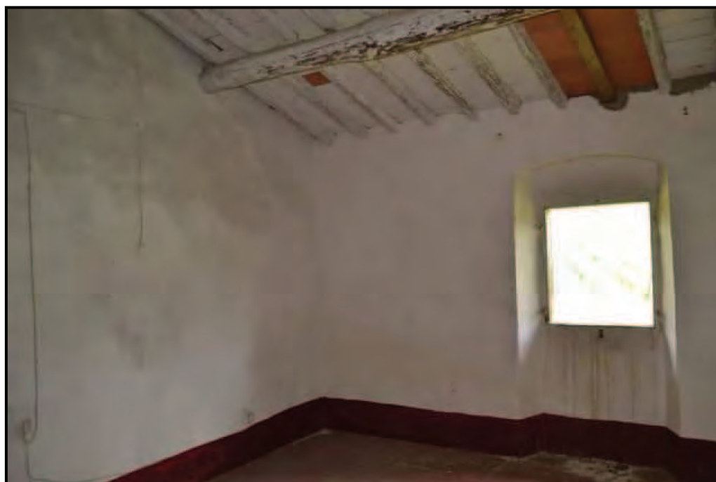
Fotografia n. 12 Podere San Martino – Edificio principale (F. 63/555/5), locale al piano terreno
