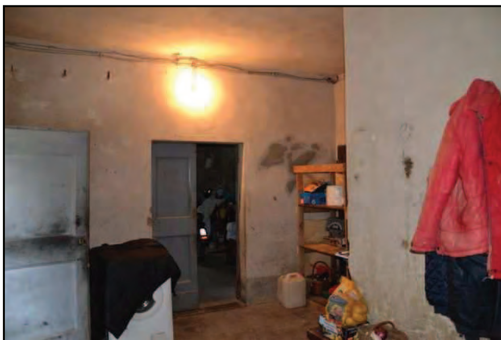
Fotografia n. 12 Podere Risorgimento (F. 63/553/2), deposito al piano terreno
