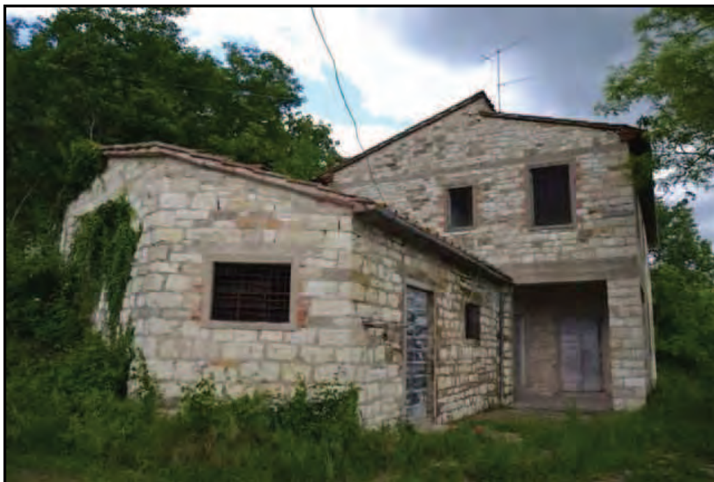
Fotografia n. 1 Podere Rimaggio – Fabbricato principale
