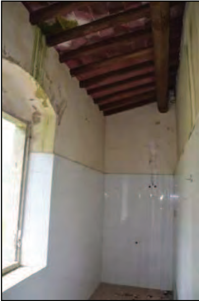
Fotografia n. 17 Podere San Pietro (F. 63/554/5) – Servizio igienico al piano primo
