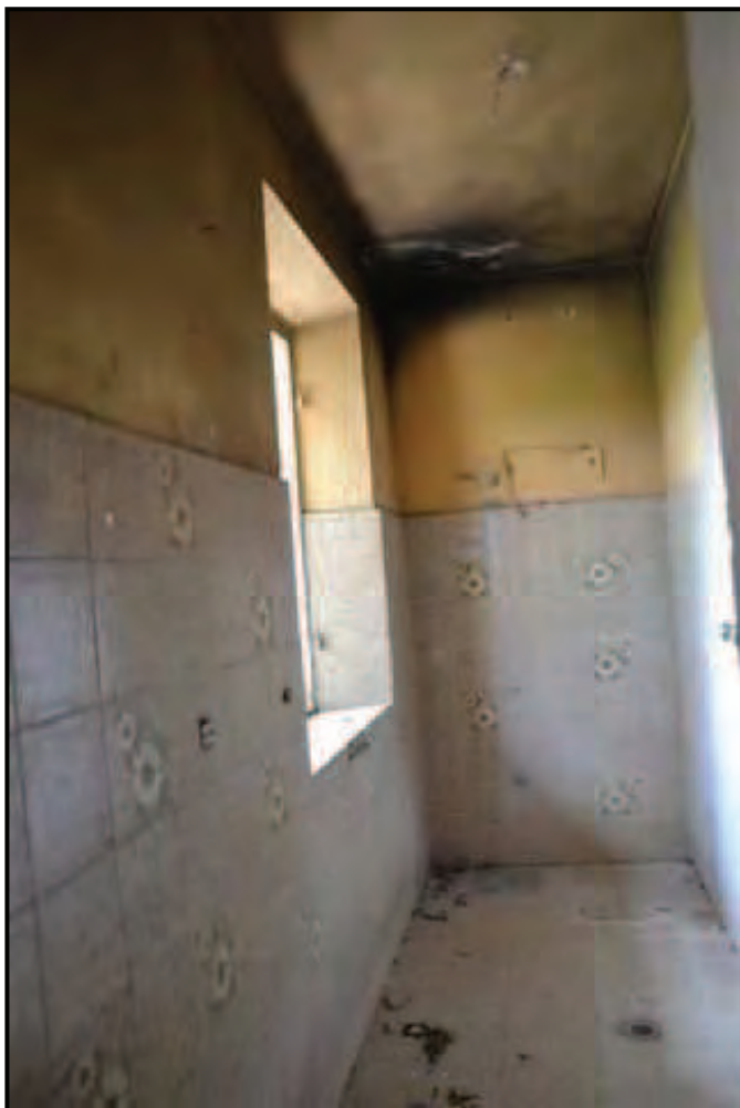
Fotografia n. 11 Podere San Pietro (F. 63/554/3) Servizio igienico al piano primo
