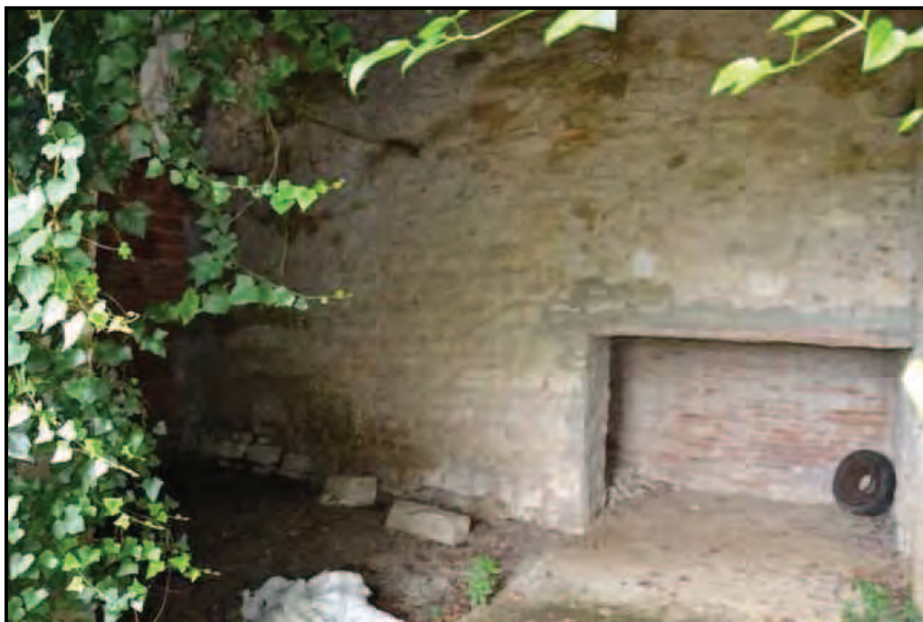
Fotografia n. 9 Annesso agricolo – Magazzino piano terreno
