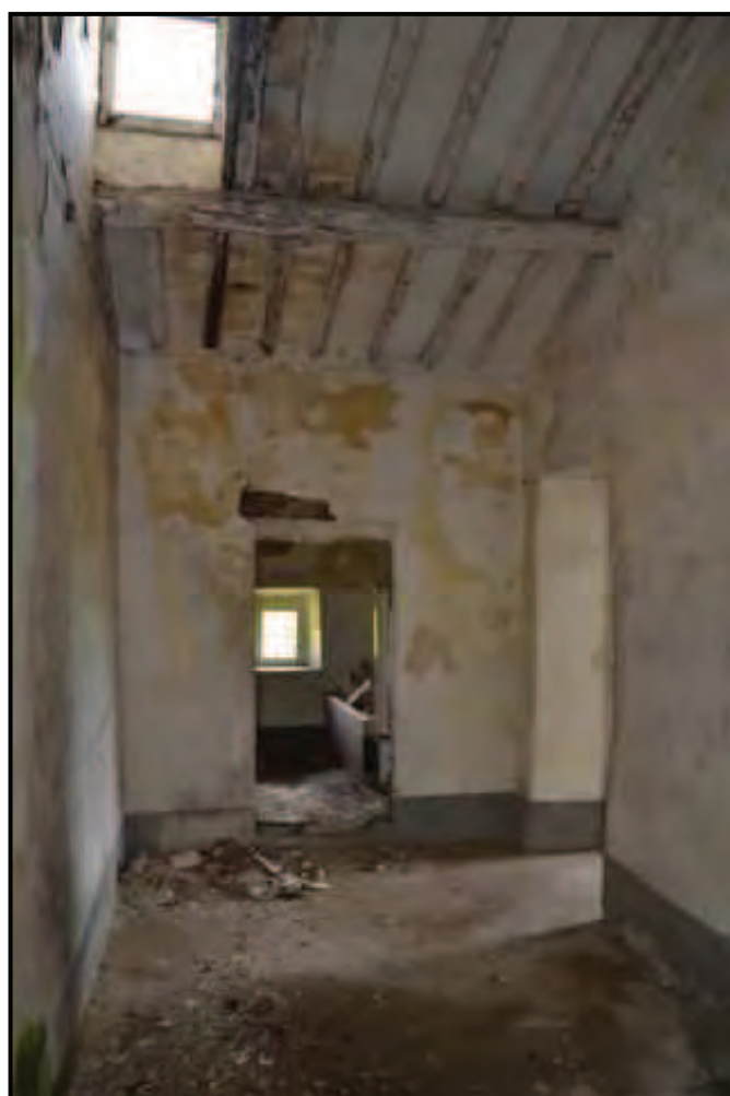
Fotografia n. 12 Podere Gaville – U.I. F. 63/59/502, disimpegno al piano primo
