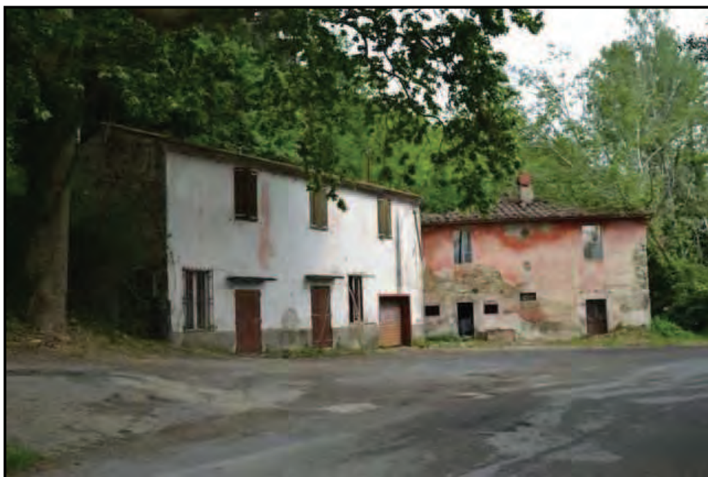
Fotografia n. 1 Edificio principale – Fronte sulla strada
