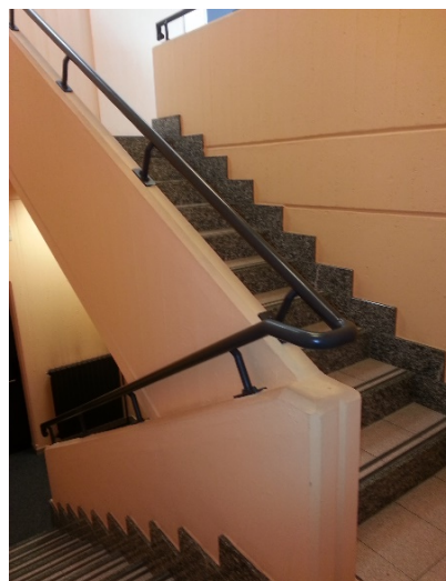
Collegamento verticale interno
