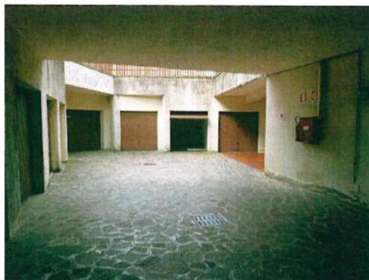
Figura 18 – corsia di manovra
