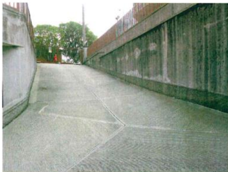
Figura 17 – rampa di accesso veicolare e pedonale alle autorimesse
