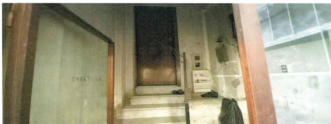
Alloggio entrata ex portineria
