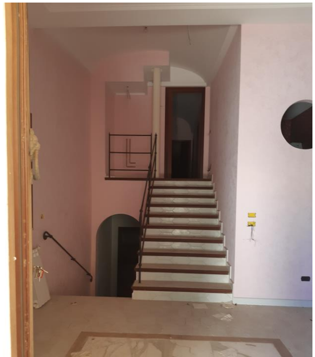
Foto 17 – Scala di accesso al piano primo e al seminterrato
