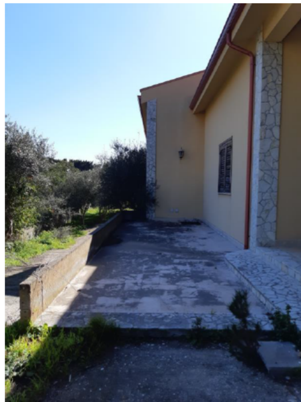
Foto 3 – Prospetto principale (riserva idrica)
