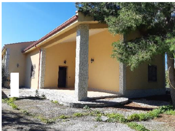
Foto 1 – Prospetto principale (sud)
