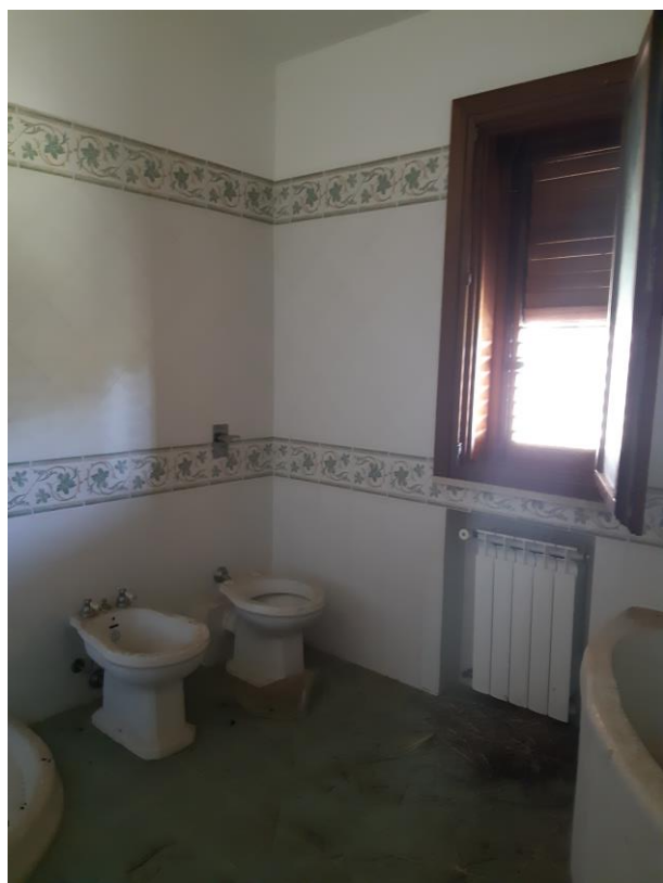
Foto 30 – P1 – Bagno con vasca e doccia
