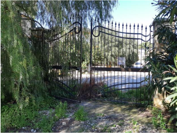
Foto 12 – Cancello principale sulla via dei Greci
