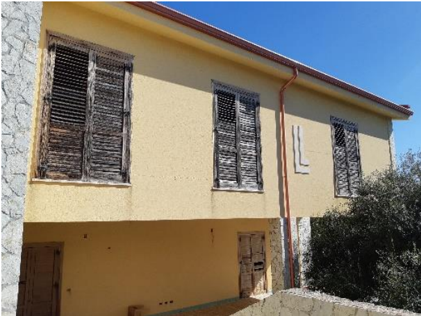
Foto 6 – Prospetto laterale (ovest)
