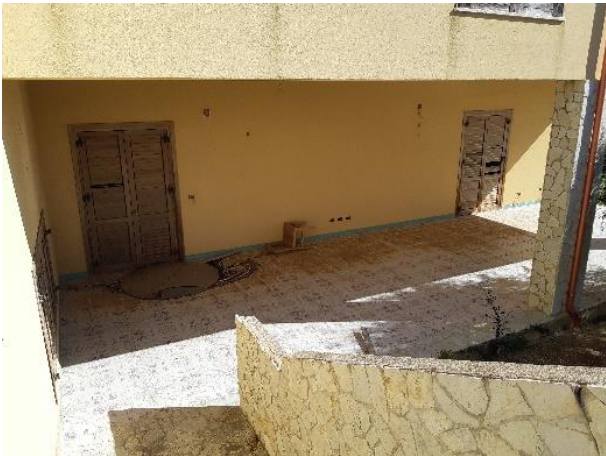
Foto 8 – Prospetto laterale (ovest)
