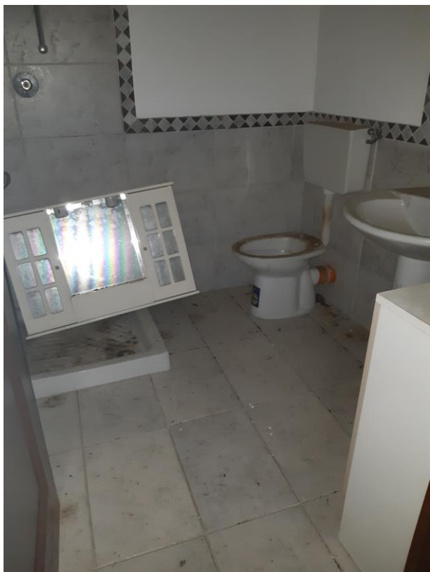
Foto 42 – Cantinato – Wc con doccia
