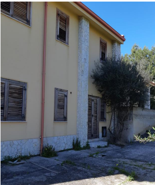
Foto 10 – Prospetto laterale (est)
