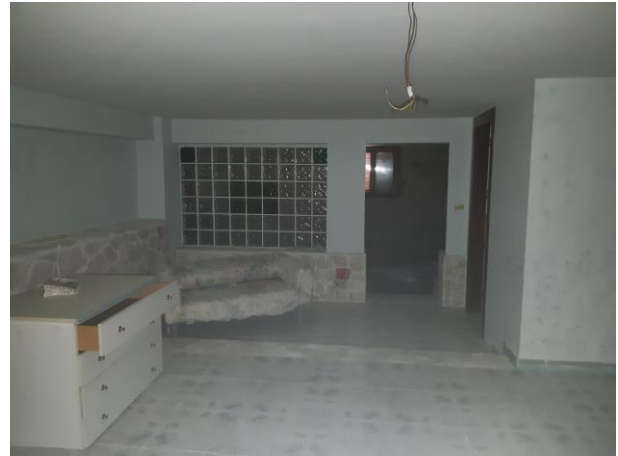
Foto 41 – Cantinato – vano interrato
