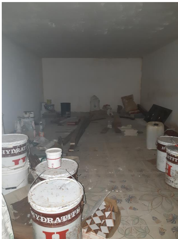
Foto 43 – Cantinato – vano interrato
