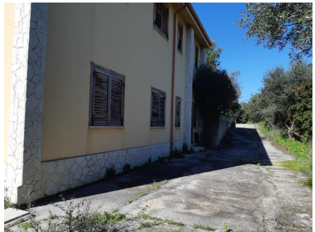
Foto 9 – Prospetto laterale (est)
