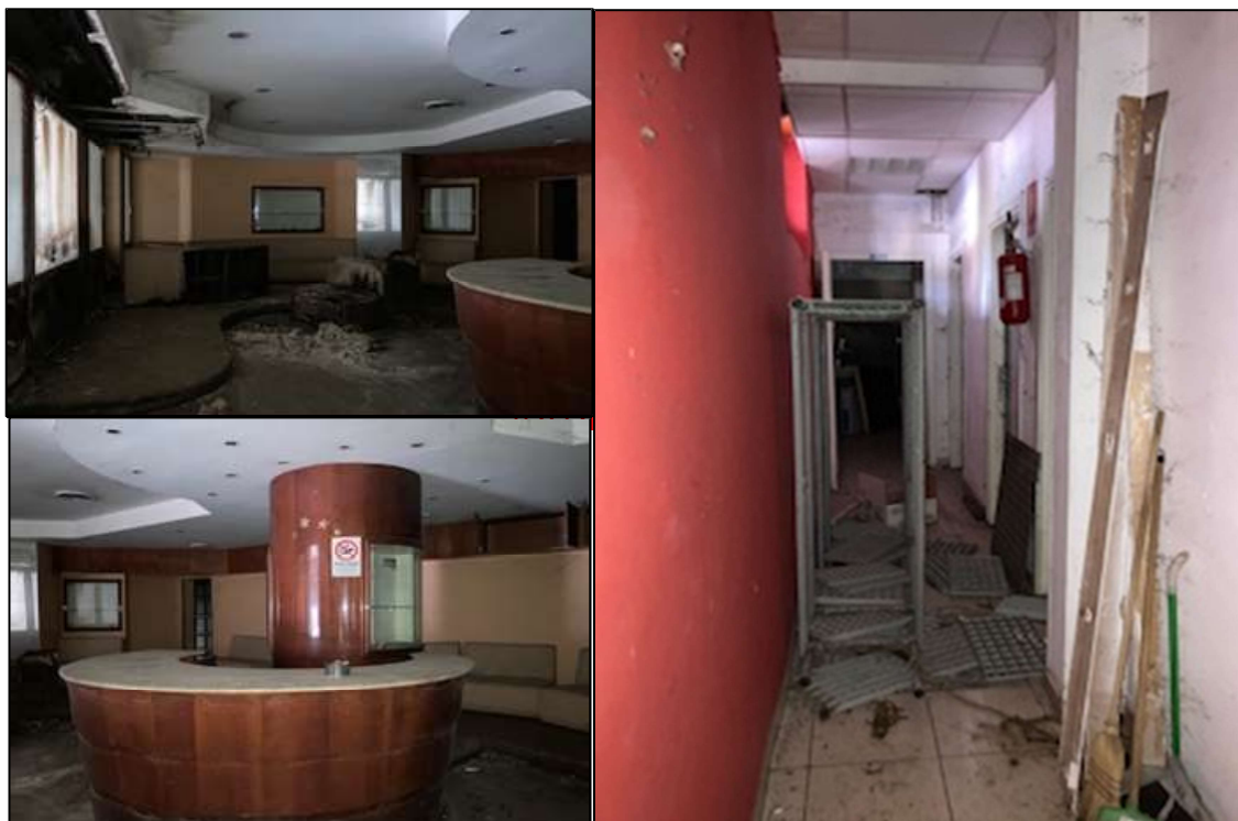
Foto sopralluogo sub 501
