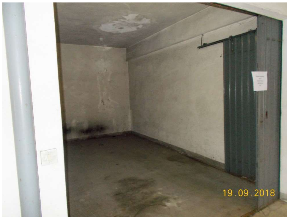
box foglio 50 part 3439 sub 10
