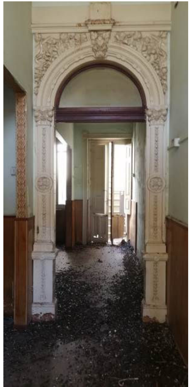
Foto dall'ingresso verso l'interno
