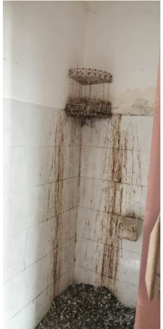
Dettaglio del servizio igienico con accesso dal cortile
