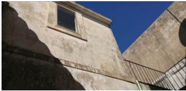
Vista del fabbricato sito al piano primo
