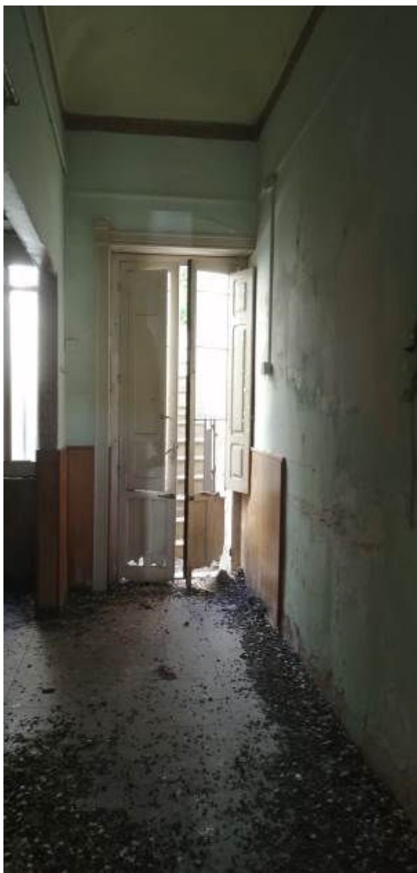
Foto dall'interno verso il cortile
