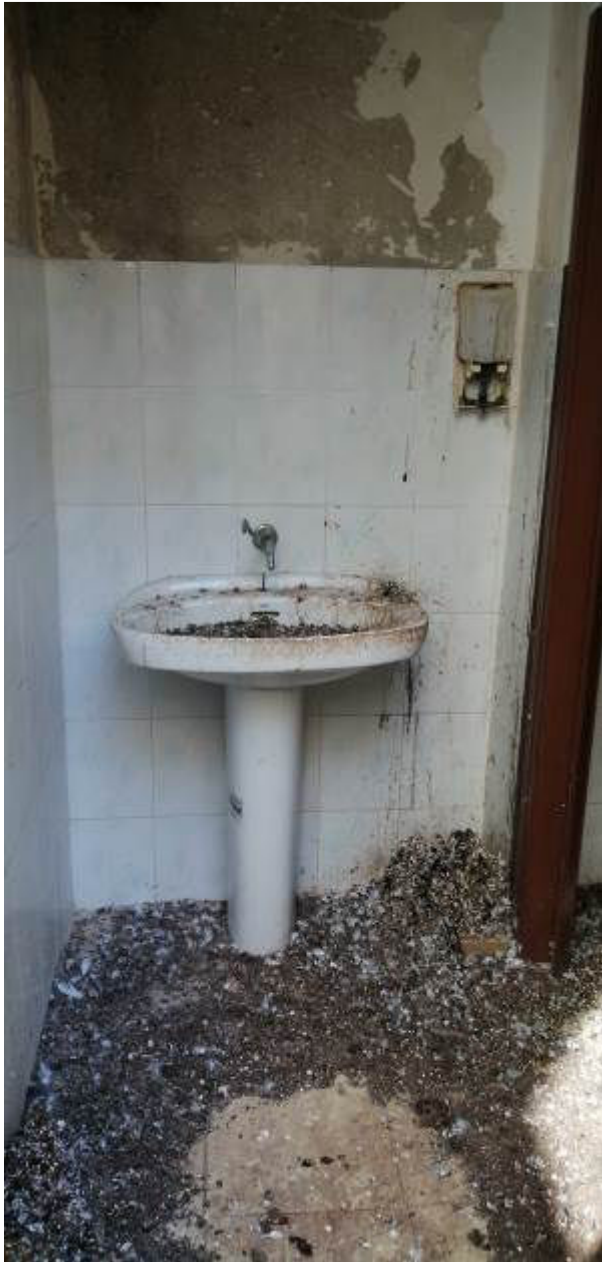
Dettaglio del servizio igienico con accesso dal cortile
