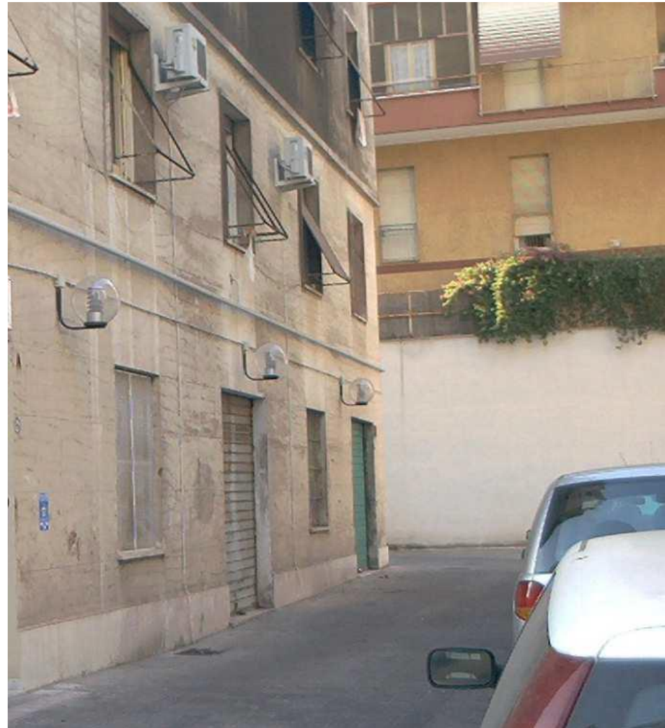
VISTA LOCALI E POSTI AUTO CORTILE CONDOMINIALE EDIFICIO VIA MADONNA DEL RIPOSO 90/B, ROMA
