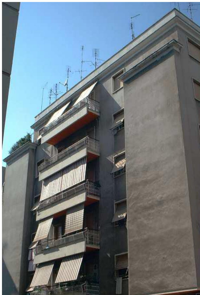
VISTA PROSPETTO PRINCIPALE EDIFICIO VIA MADONNA DEL RIPOSO 114/VIII (RM)
