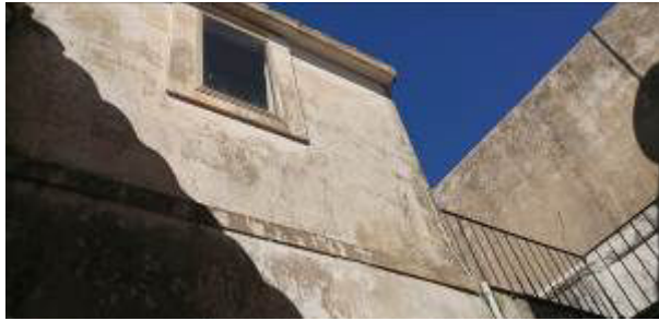
Vista del fabbricato sito al piano primo
