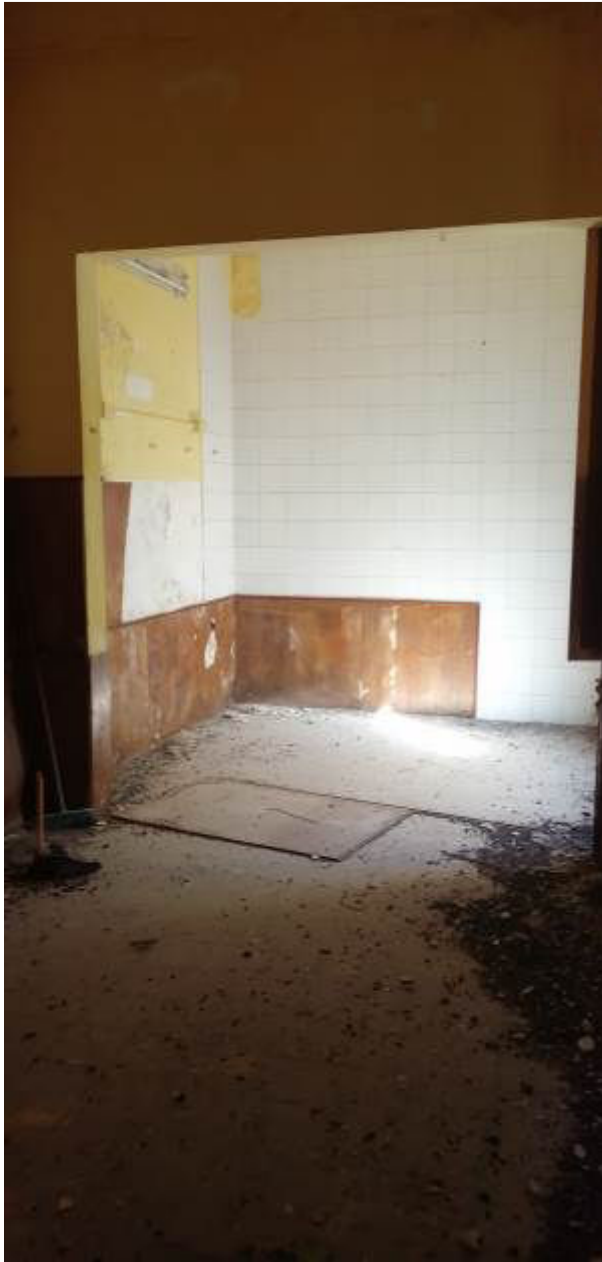
Foto dell'interno (con vista su ex cucina)
