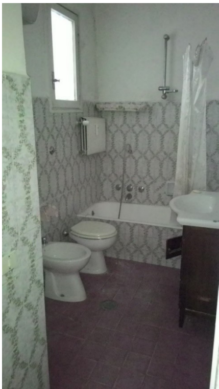
Servizio igienico principale
