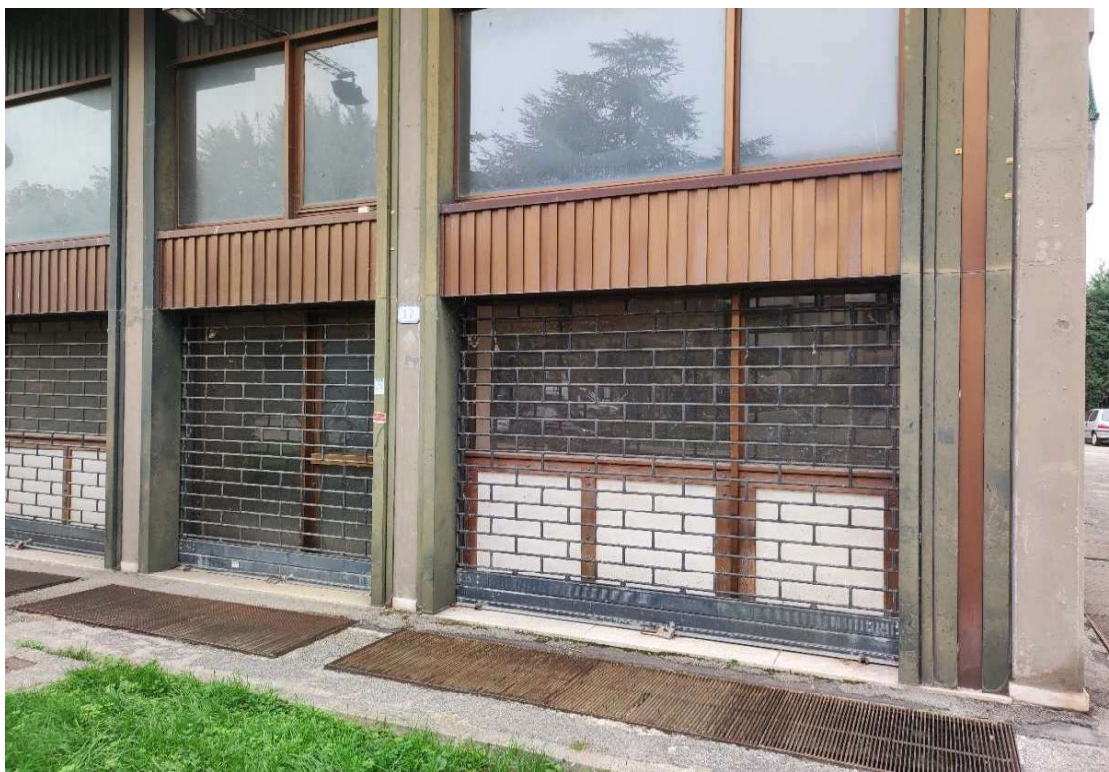
Sub. 15 - foto esterno
