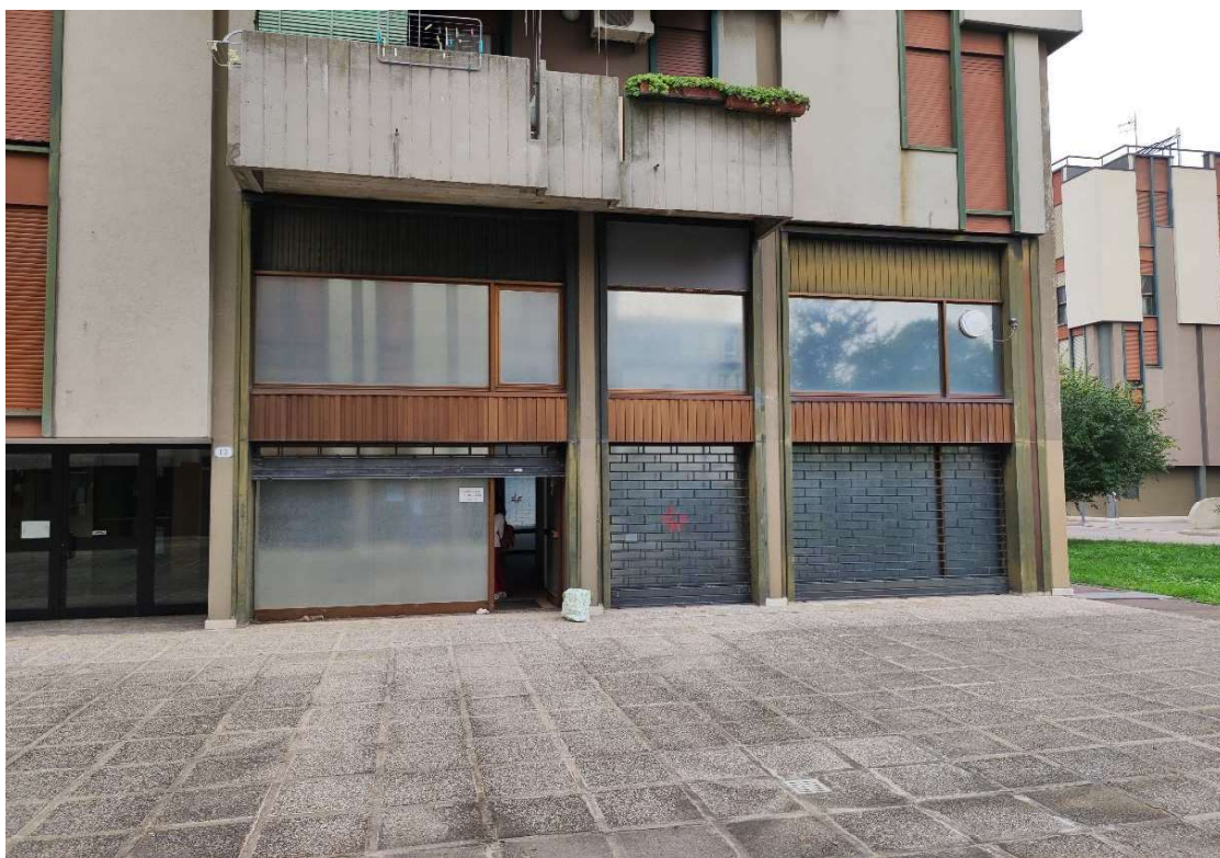
Sub. 14 - foto esterno
