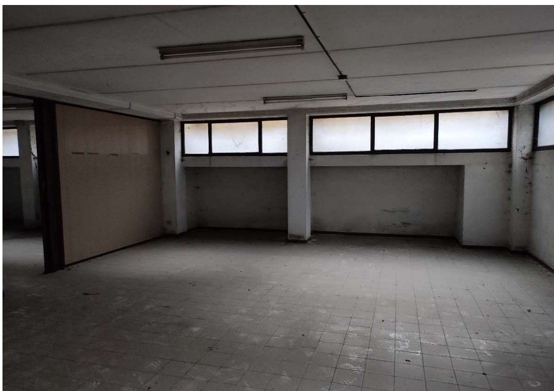
Sub. 14 - foto magazzino sottostrada
