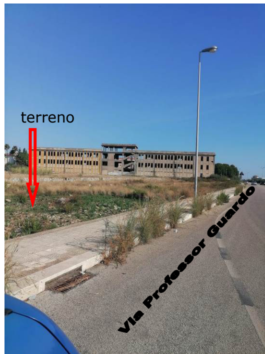
Vista di edificio e terreno dalla Via Professor Guardo
