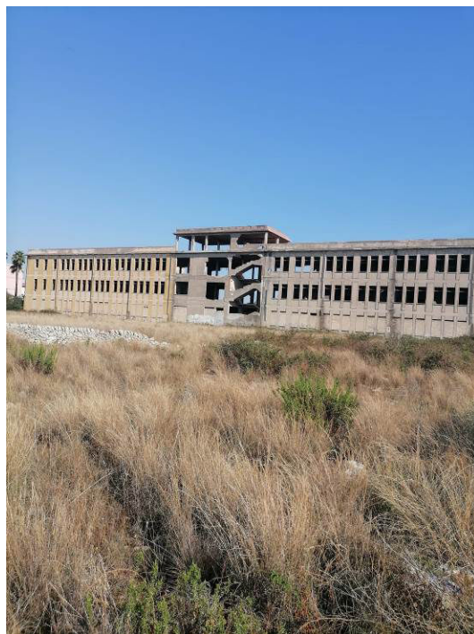
Vista edificio e terreno da via Professor Guardo
