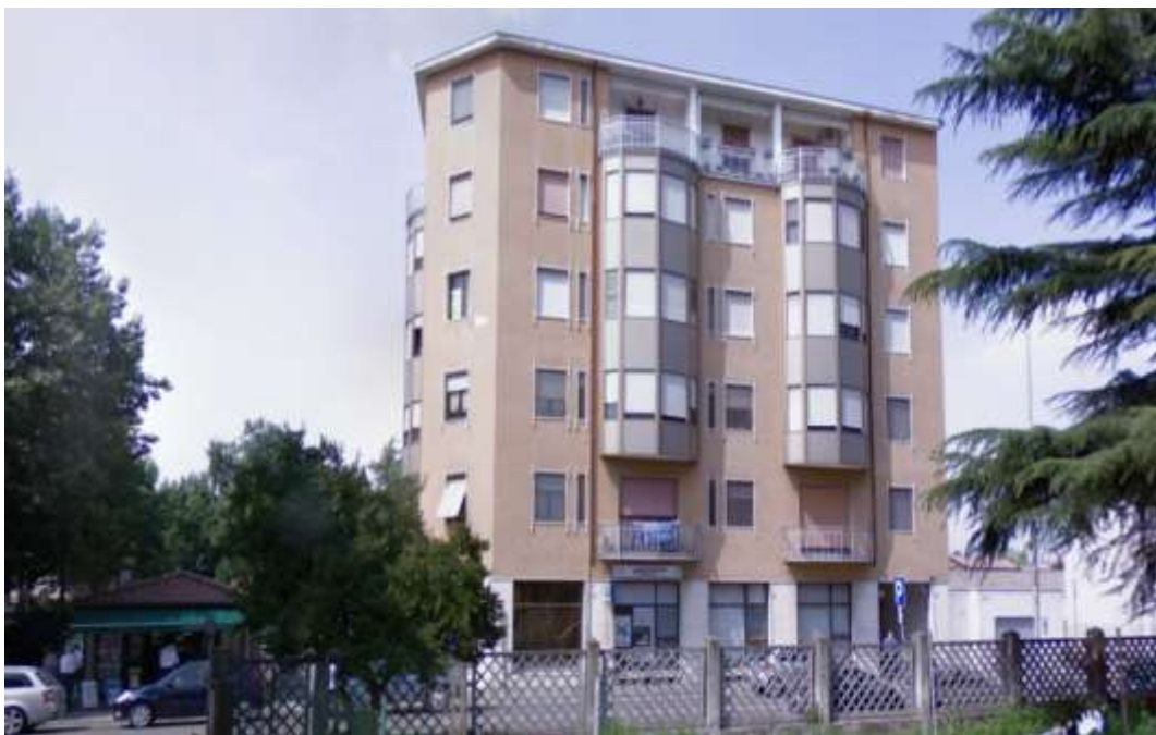
Facciata prospiciente CORSO TORINO
