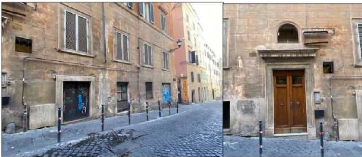
Fotografie unità immobiliari Via Degli Avignonesi nn. 5-5A-6-7, Roma - prospetti esterni (sopralluogo del 12/06/2024)
