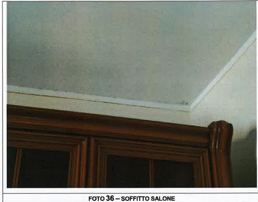
Chiari segni di infiltrazione d'acqua si rilevano anche nella parete dell'ingresso in corrispondenza del wc (cfr. **foto 37**) addebitabile sicuramente a problematiche legate al sifone di scarico della doccia. Traccia di tale perdita si ha in corrispondenza del vano garage (sub 10) del piano seminterrato. Nell'intradosso del solaio si notano degli aloni dovuti all'infiltrazione d'acqua dal suddetto wc con conseguente ammaloramento degli intonaci (cfr. **foto 38**).
