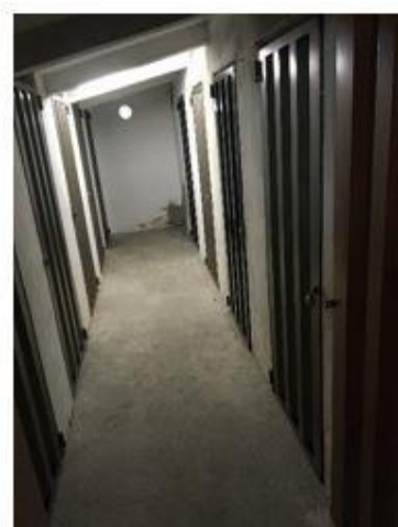
Accesso soffitte al piano sottotetto
