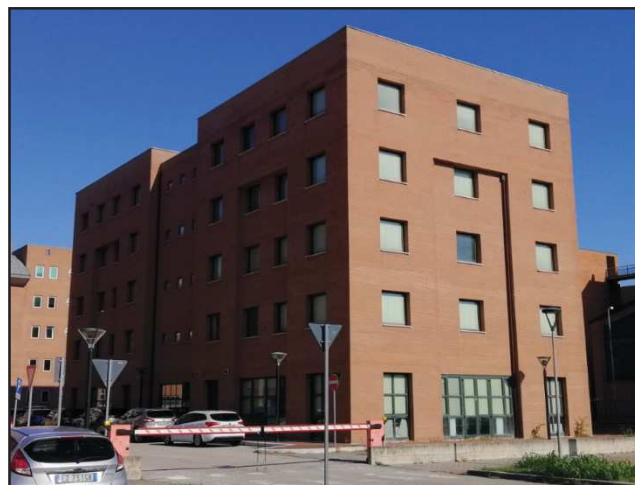
FOTO N° 5 Particolare dell'edificio lato sud
