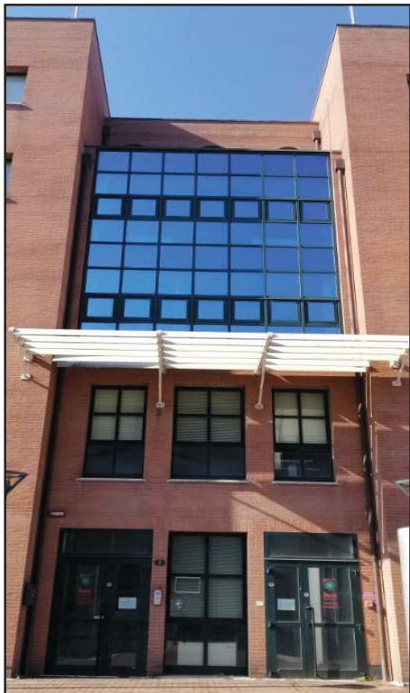
FOTO N° 2: Particolare dell'ingresso dell'edificio.
