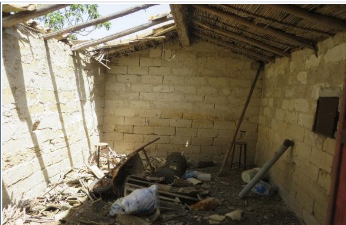
Foto n° 11 - Fondo 1 - Fabbricato 1 - interno - Part.Ile 22, 23 ,24.
