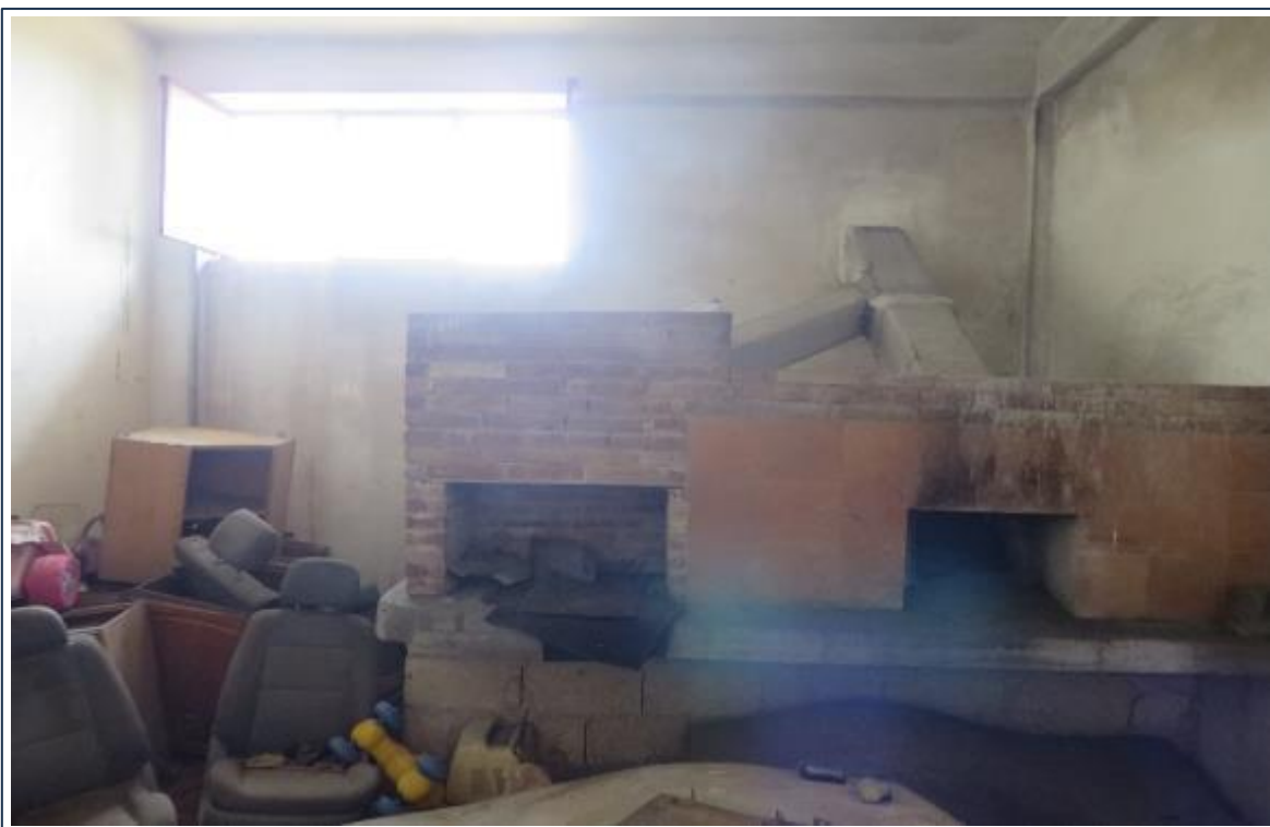
Foto n° 18 - - Fondo 1 - Fabbricato 2 - Interno - Part.Ile 22, 23 ,24.
