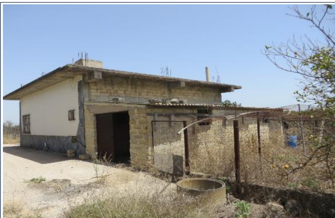
Foto n° 14 - Fondo 1 - Fabbricato 2 - Part.Ile 22, 23 ,24.
