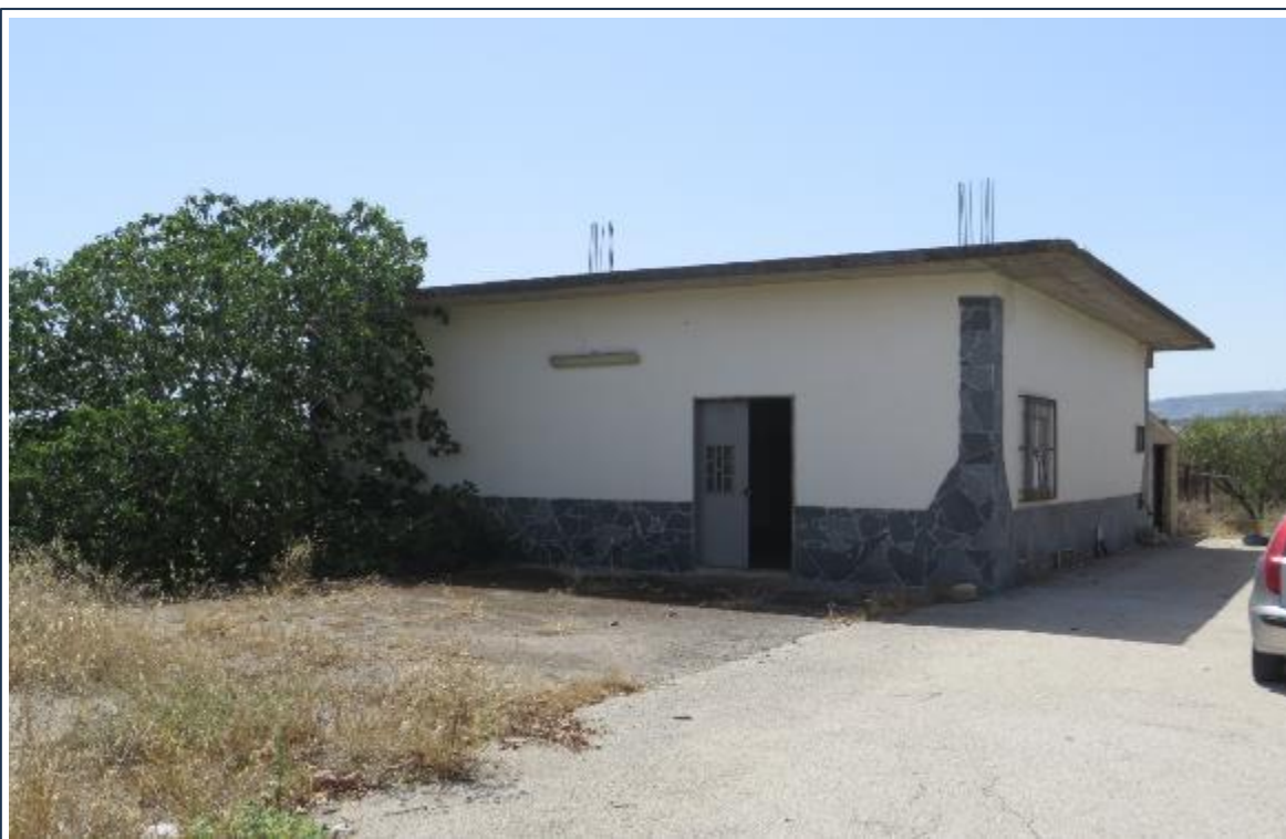
Foto n° 12 - Fondo 1 - Fabbricato 2 - Part.Ile 22, 23 ,24.
