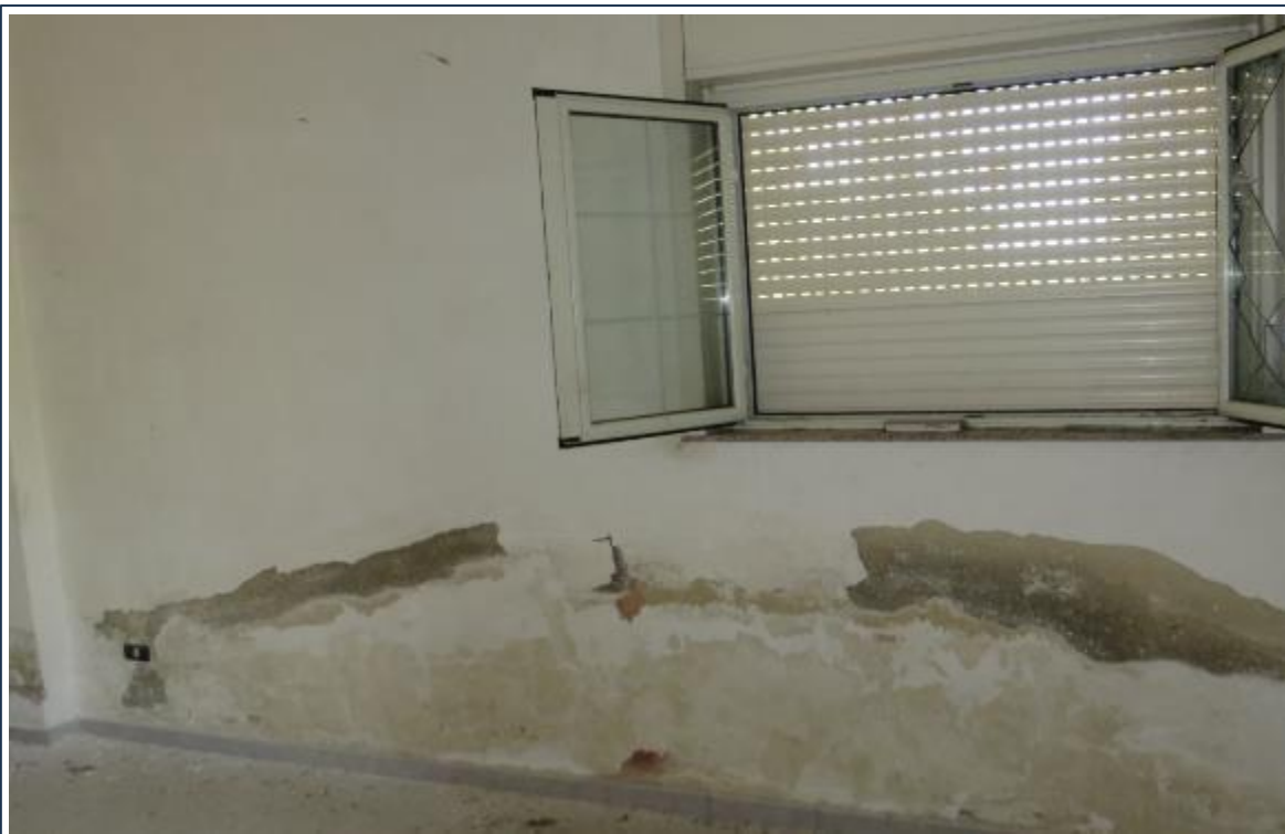
Foto n° 16 - - Fondo 1 - Fabbricato 2 - Interno - Part.Ile 22, 23 ,24.
