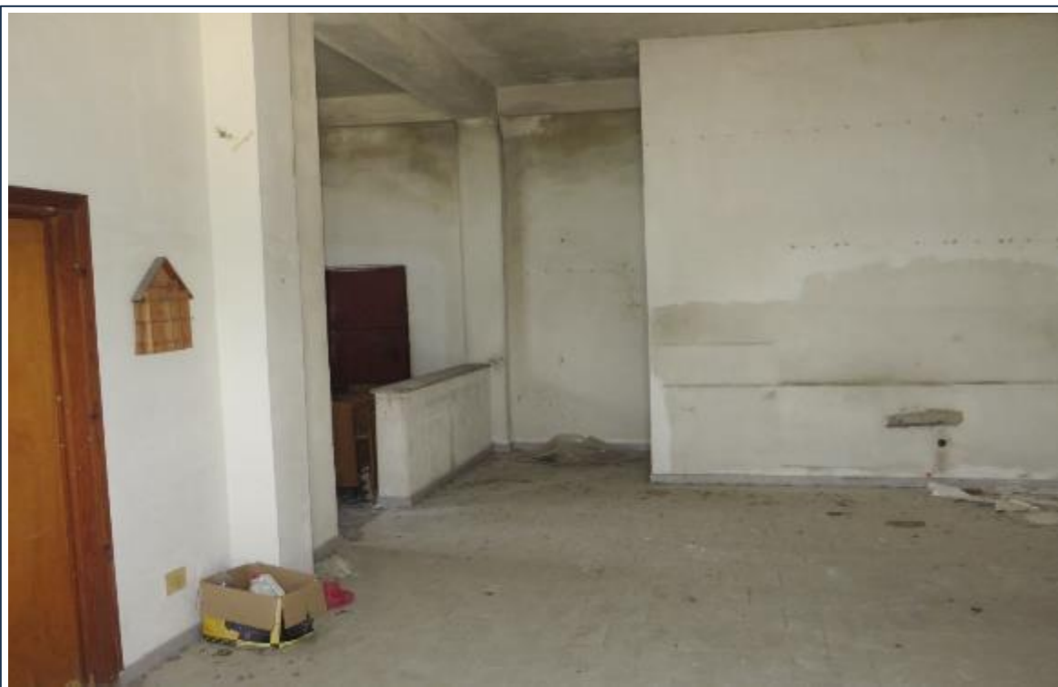
Foto n° 15 - Fondo 1 - Fabbricato 2 - Interno - Part.Ile 22, 23 ,24.
