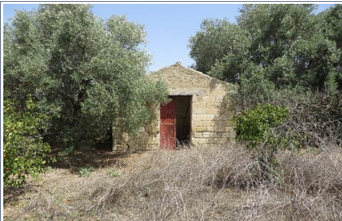
Foto n° 10 - Fondo 1 - Fabbricato 1 - Part.Ile 22, 23 ,24.
