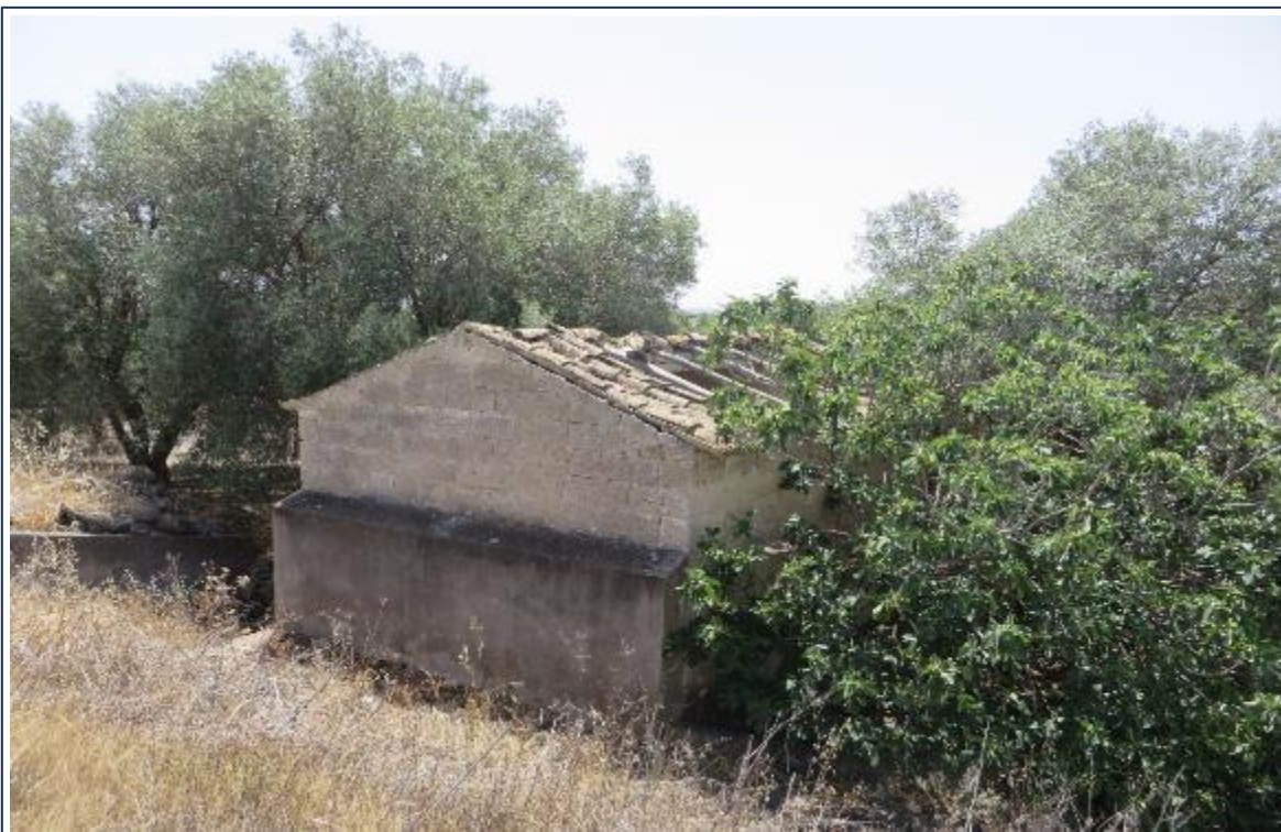
Foto n° 9 - Fondo 1 - Fabbricato 1 - Part.Ile 22, 23 ,24.
