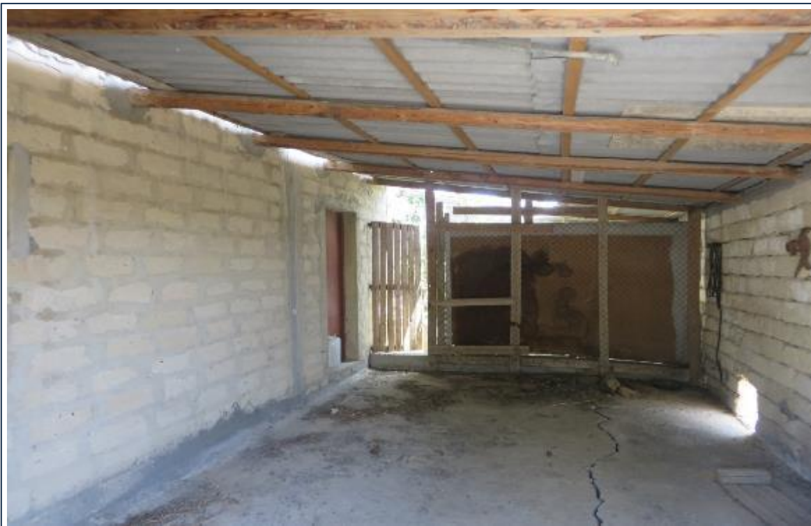
Foto n° 20 - - Fondo 1 - Fabbricato 2 - Interno - Part.Ile 22, 23 ,24.
