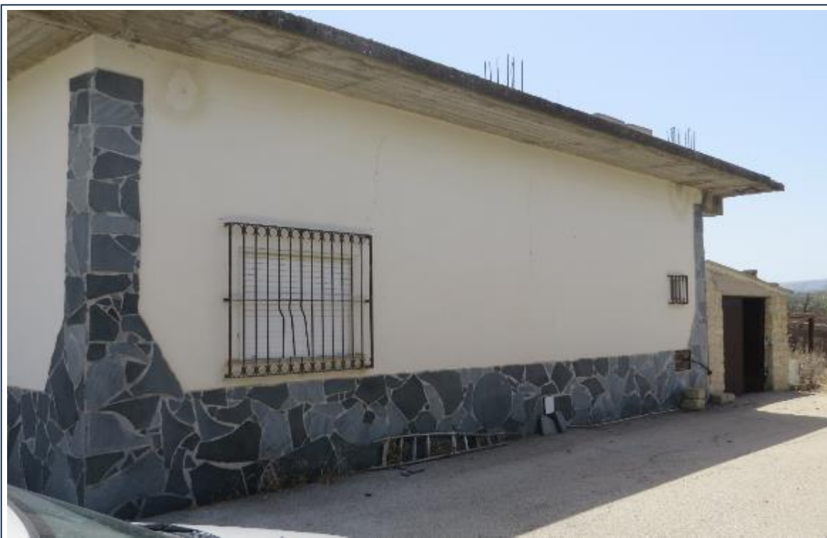
Foto n° 13 - Fondo 1 - Fabbricato 2 - Part.Ile 22, 23 ,24.
