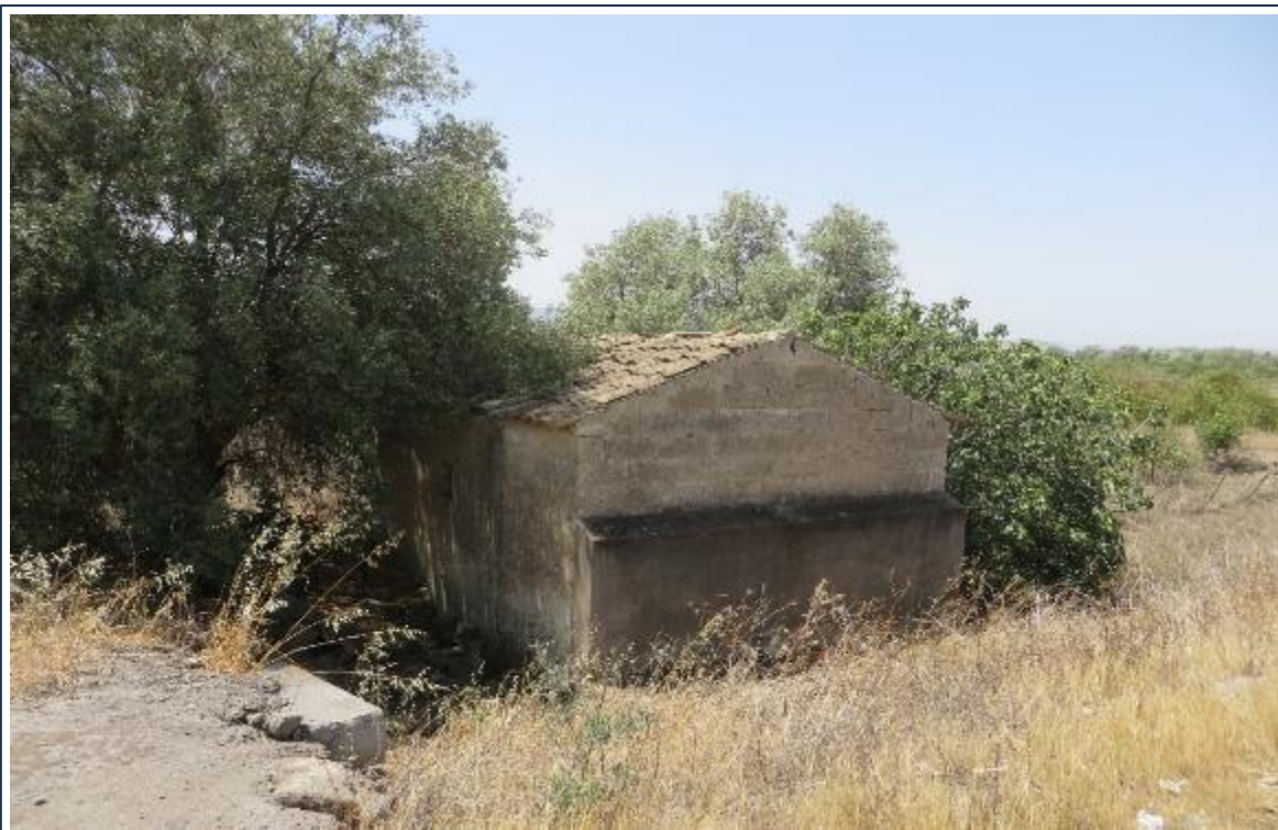
Foto n° 8 - Fondo 1 - Fabbricato 1 - Part.Ile 22, 23 ,24
