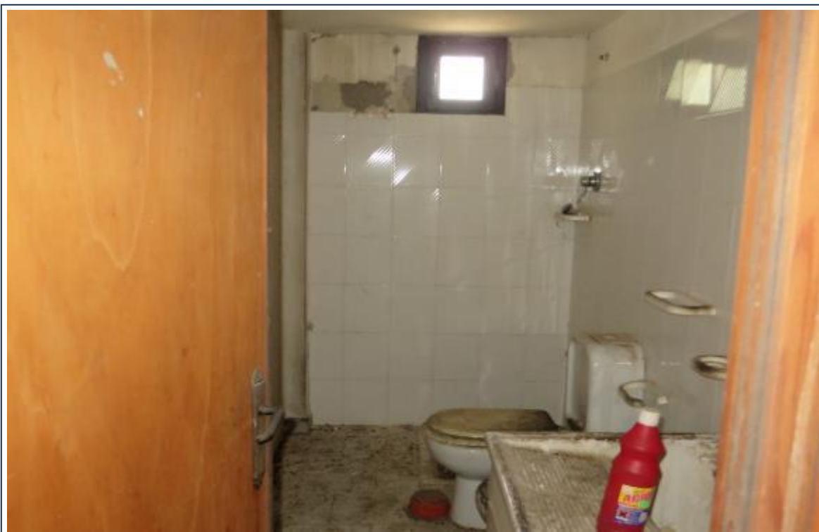
Foto n° 17 - - Fondo 1 - Fabbricato 2 - Interno - Part.Ile 22, 23 ,24.
