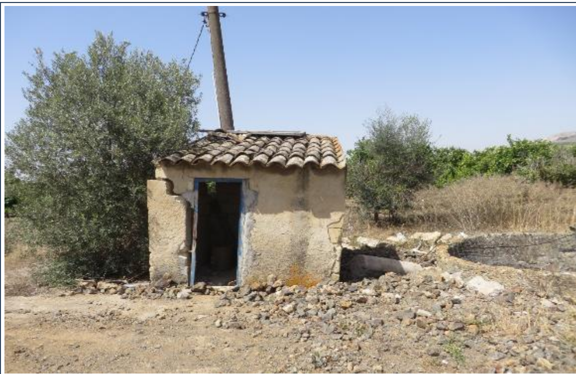
Foto n° 30 - Fondo 2 - Bugigattolo esistente - Part.Ile 17, 29.
