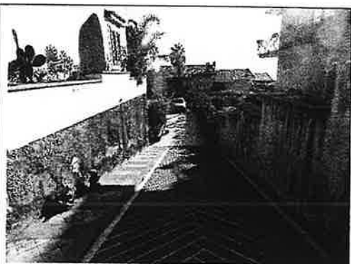
foto n° 4: Rampa di accesso al piano seminterrato
