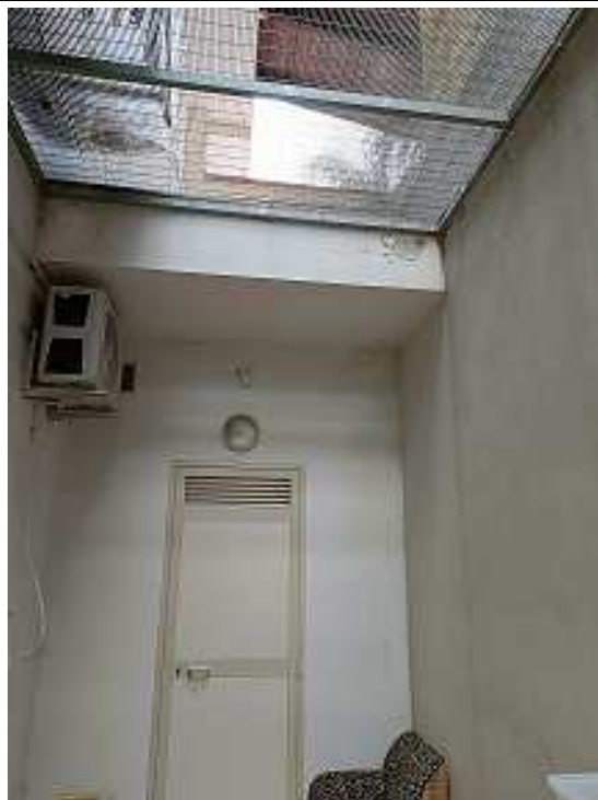
Foto 6 – lavatoio nell’intercapedine p. S1
