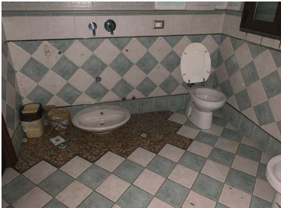
Immobile Sub 800 - Vista degli interni 3 (Fonte ANBSC)
