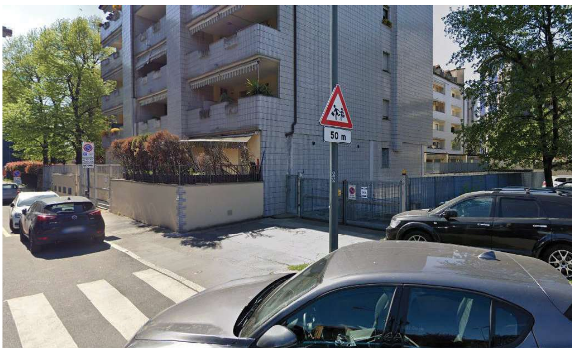
Vista del fabbricato dove è ubicata la UIU Sub 800 da Via Valle Antrona in direzione Sud (Fonte: Google Street View)
