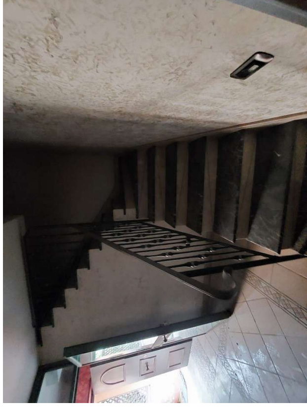
SCALA INTERNA DI COLLEGAMENTO AI VARI PIANI
