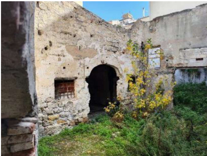
Vista interna Immobili B-D
