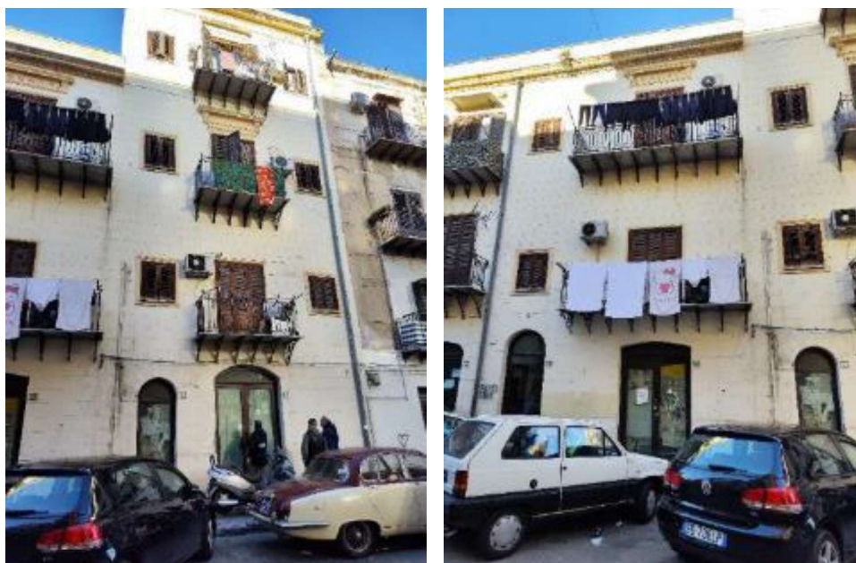
Prospetti su Via Domenico Scinà n. 69-71-73
