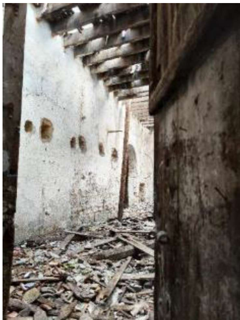
Vista interna Immobile A
