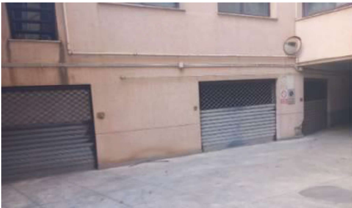
Vista degli ingressi ai box auto sub. 134, 135 e 136
