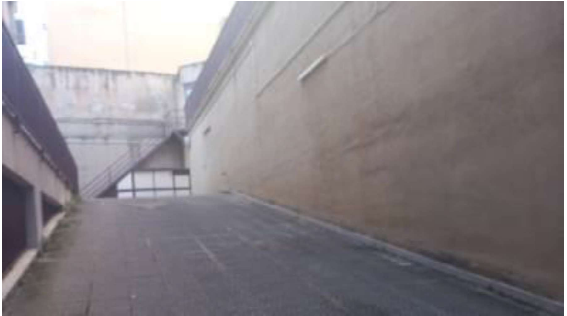
Vista della rampa carrabile di accesso al piano S2
