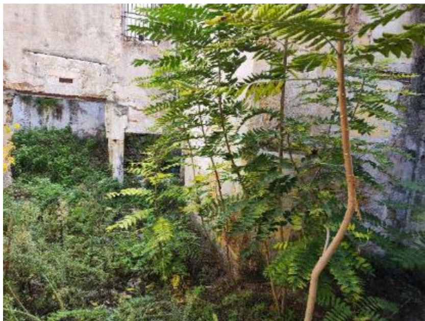
Vista interna Immobili B - D
