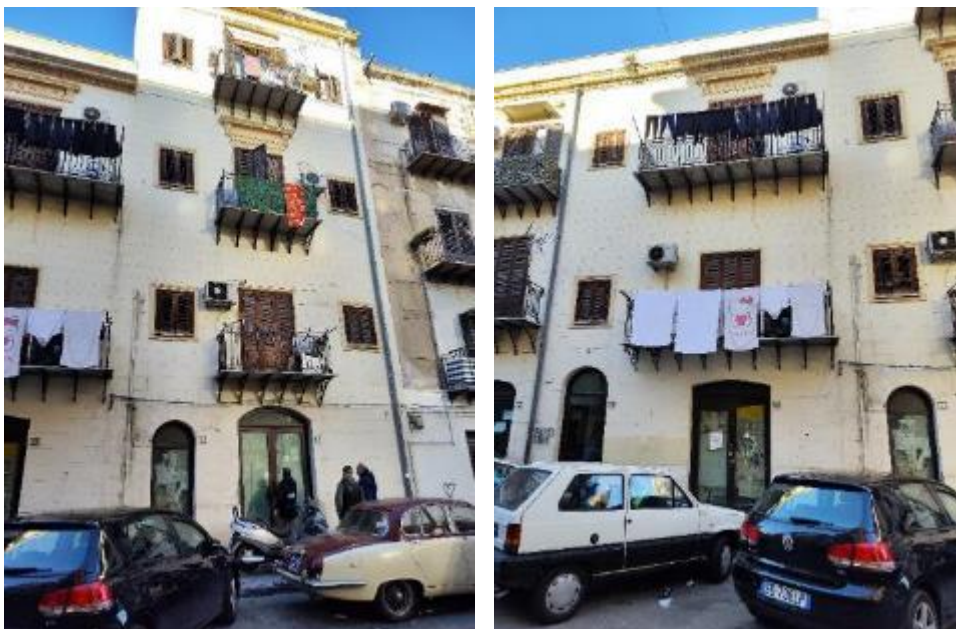
Prospetti su Via Domenico Scinà n. 69-71-73
