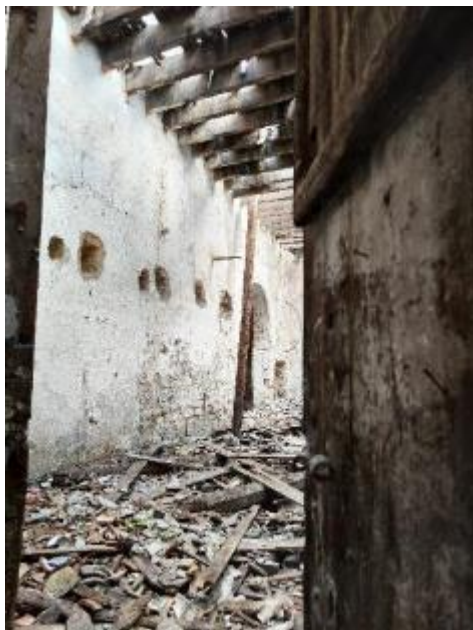
Vista interna Immobile A
