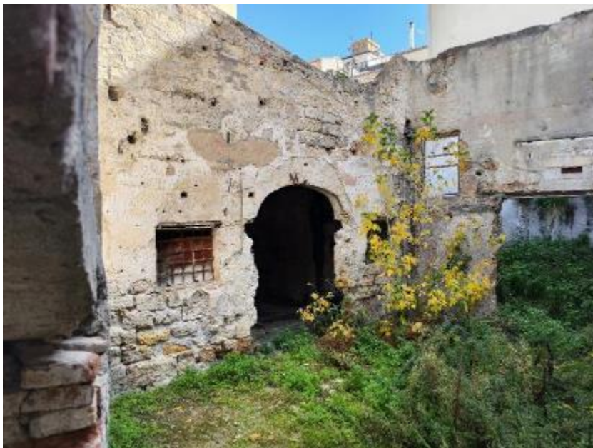
Vista interna Immobili B-D
