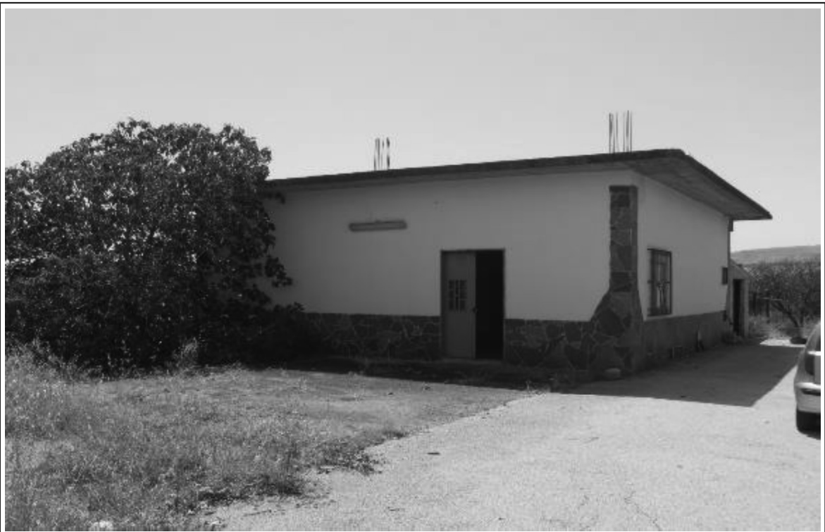
Foto n° 12 - Fondo 1 - Fabbricato 2 - Part. Ile 22, 23 ,24.
