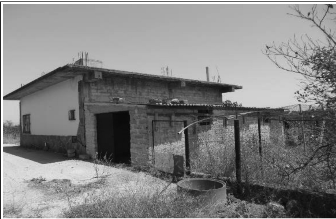
Foto n° 14 - Fondo 1 - Fabbricato 2 - Part.Ile 22, 23 ,24.
