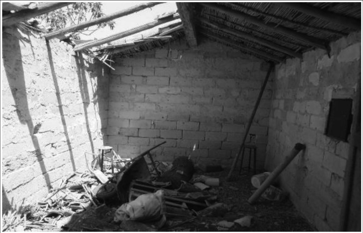
Foto n° 11 - Fondo 1 - Fabbricato 1 - interno - Part. Ile 22, 23 ,24.
