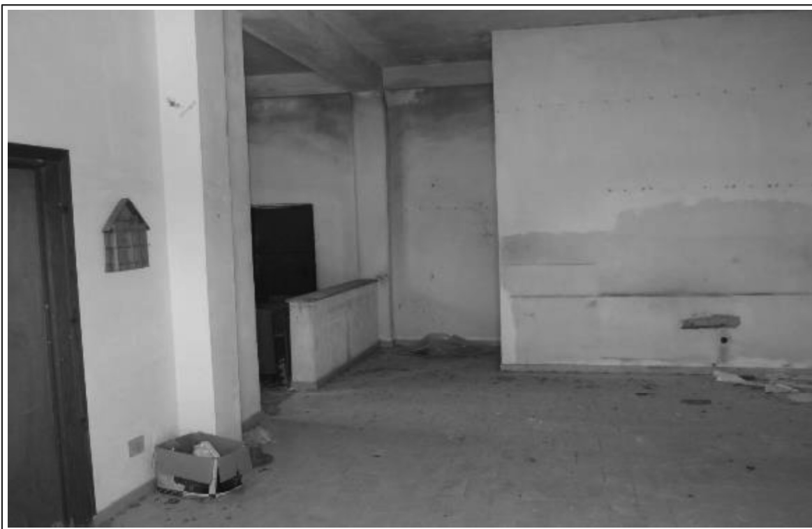
Foto n° 15 - Fondo 1 - Fabbricato 2 - Interno - Part. Ile 22, 23 ,24.
