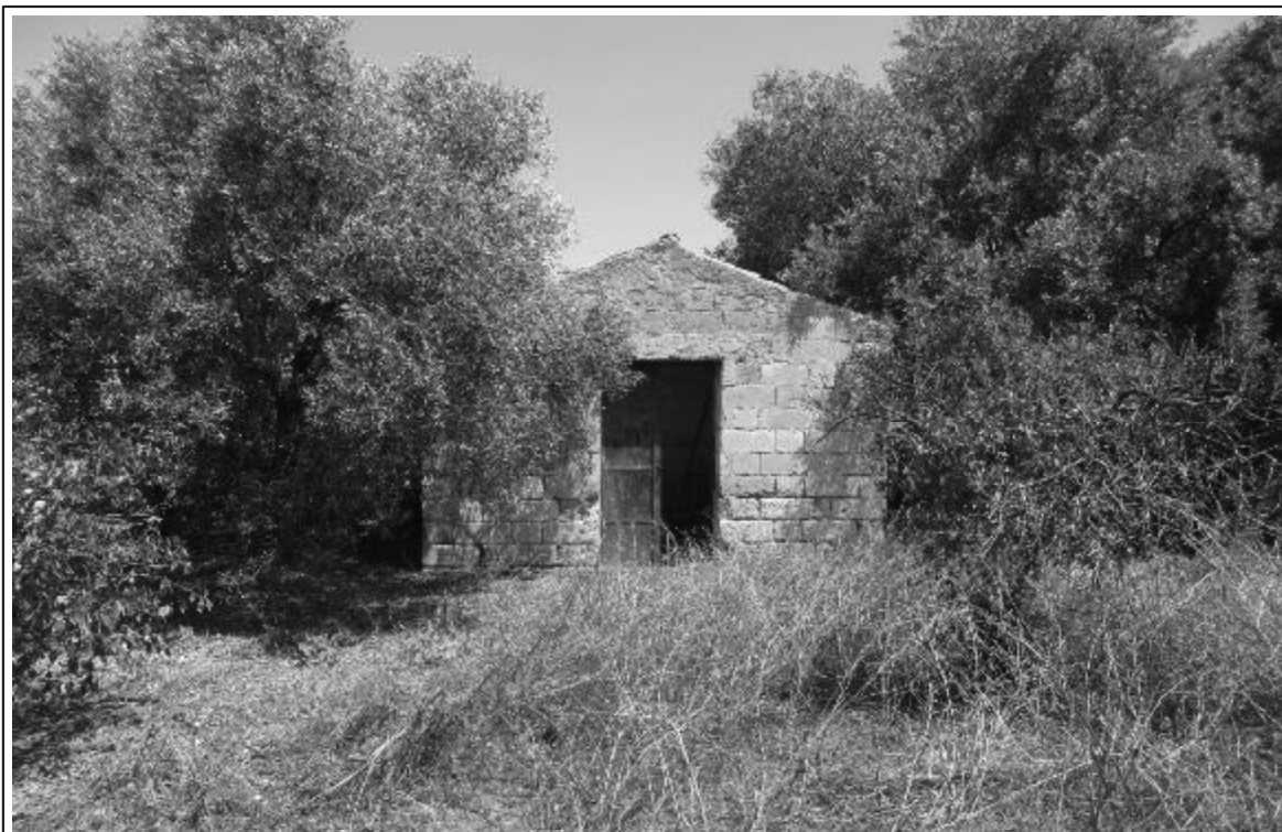
Foto n° 10 - Fondo 1 - Fabbricato 1 - Part.Ile 22, 23 ,24.
