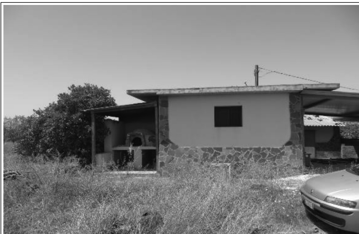
Foto n° 22 - Fondo 1 - Fabbricato 3 - Part.Ile 22, 23 ,24.
