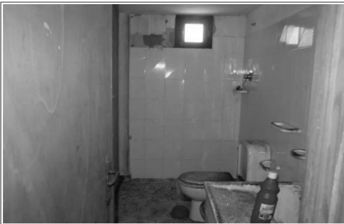
Foto n° 17 - - Fondo 1 - Fabbricato 2 - Interno - Part.Ile 22, 23 ,24.
