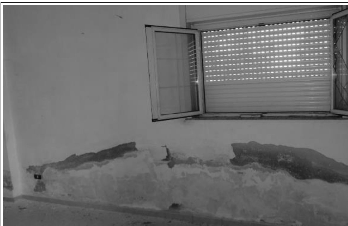
Foto n° 16 - - Fondo 1 - Fabbricato 2 - Interno - Part. Ile 22, 23 ,24.
