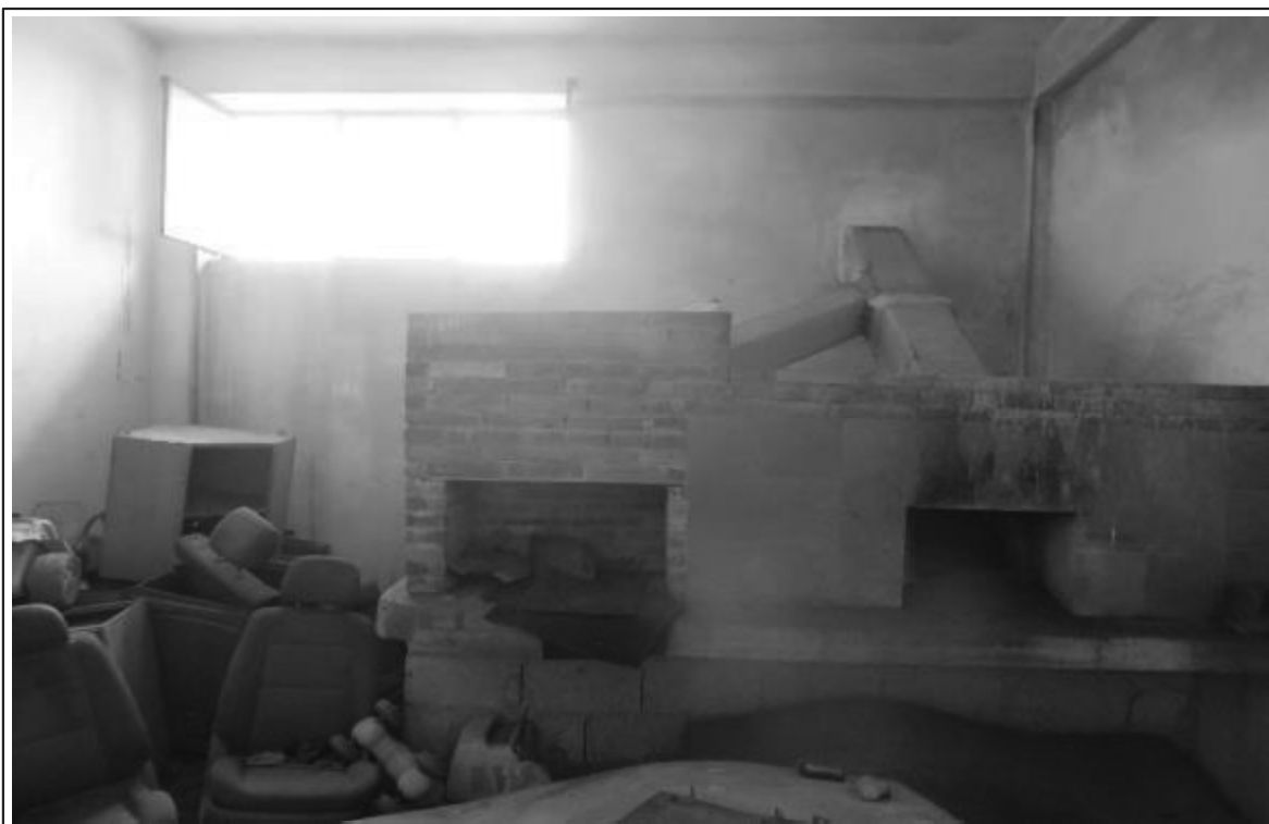
Foto n° 18 - - Fondo 1 - Fabbricato 2 - Interno - Part.Ile 22, 23 ,24.
