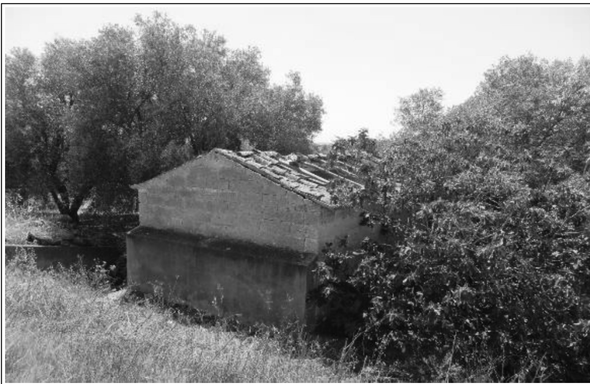
Foto n° 9 - Fondo 1 - Fabbricato 1 - Part.Ile 22, 23 ,24.
