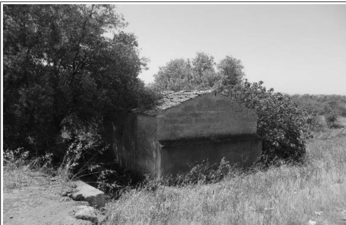
Foto n° 8 - Fondo 1 - Fabbricato 1 - Part.lle 22, 23 ,24
