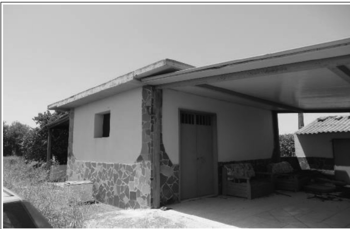
Foto n° 21 - Fondo 1 - Fabbricato 3 - Part.Ile 22, 23 ,24.
