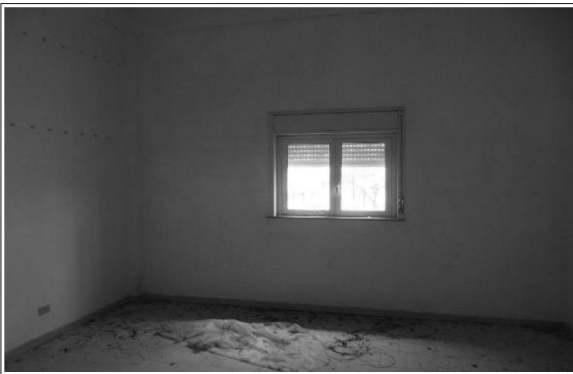
Foto n° 19 - - Fondo 1 - Fabbricato 2 - Interno - Part. Ile 22, 23 ,24.
