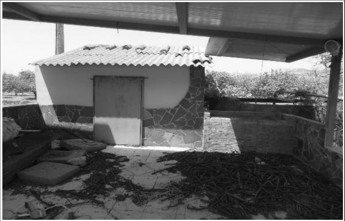
Foto n° 23 - Fondo 1 - Fabbricato 3 - Part.Ile 22, 23 ,24.
