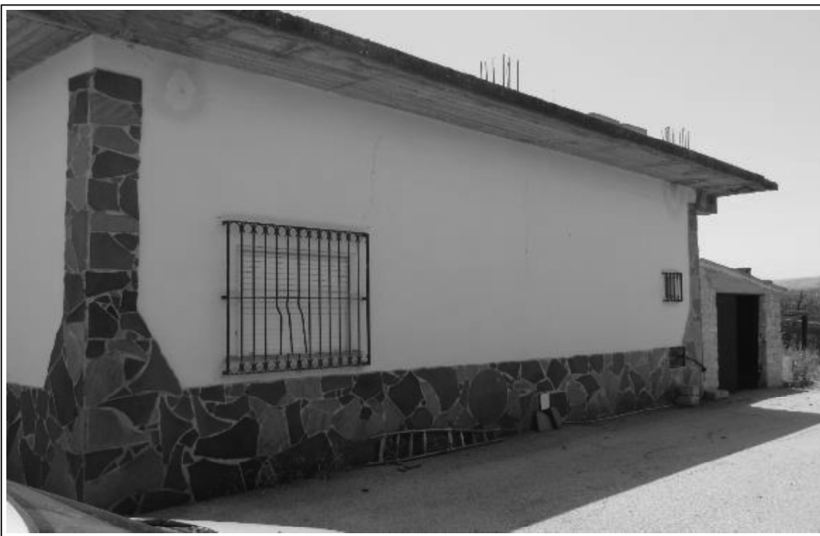
Foto n° 13 - Fondo 1 - Fabbricato 2 - Part.Ile 22, 23 ,24.
