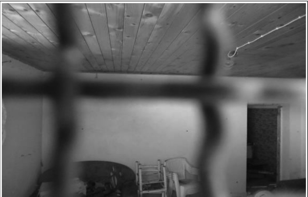
Foto n° 24 - Fondo 1 - Fabbricato 3 - Interno - Part.Ile 22, 23 ,24.
