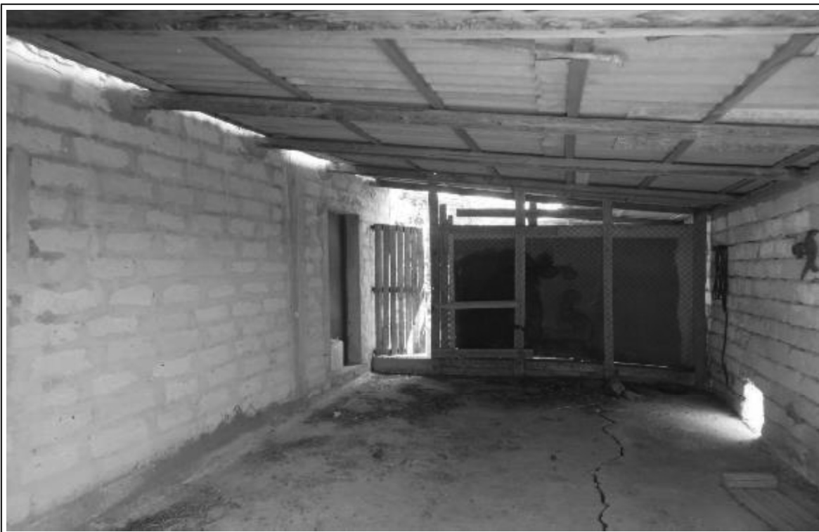
Foto n° 20 - - Fondo 1 - Fabbricato 2 - Interno - Part. Ile 22, 23 ,24.
