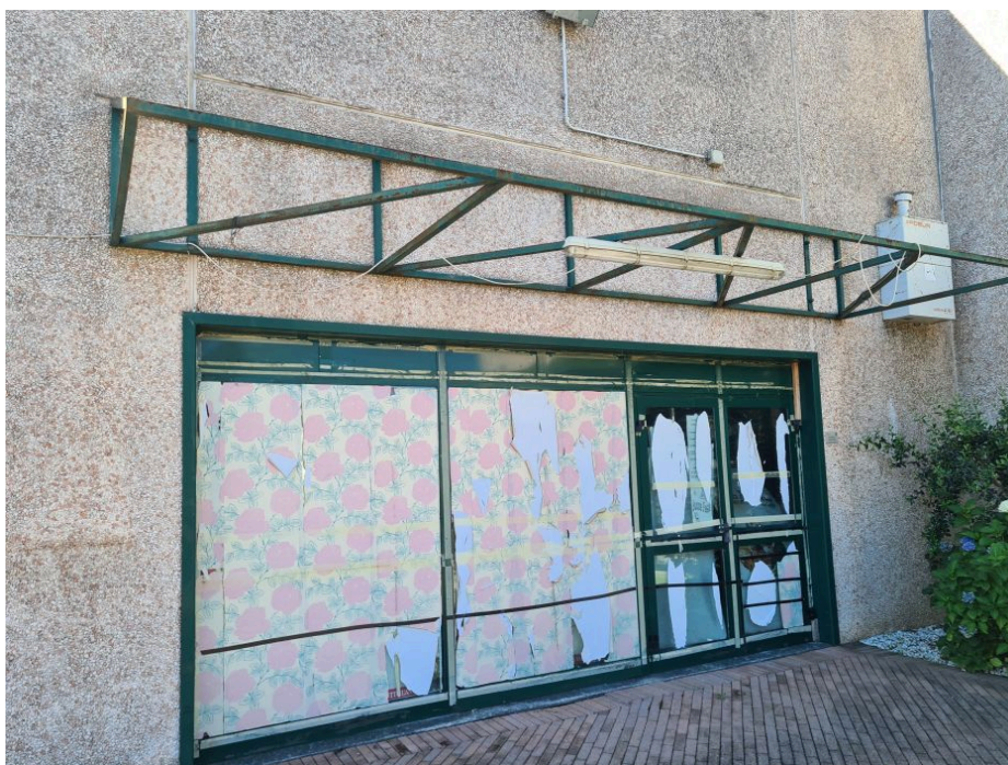
Foto alla data del sopralluogo (02/07/2026)
