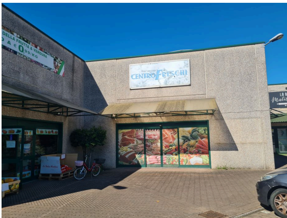
Foto alla data del sopralluogo (02/07/2026)
