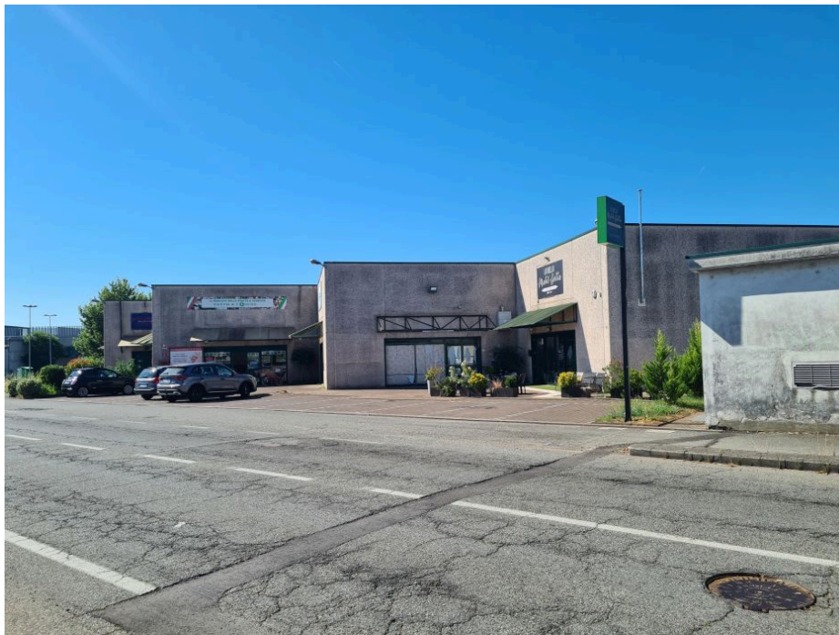
Foto alla data del sopralluogo (02/07/2026)
