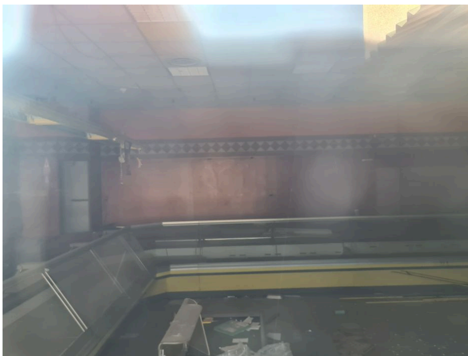
Foto alla data del sopralluogo (02/07/2026)
