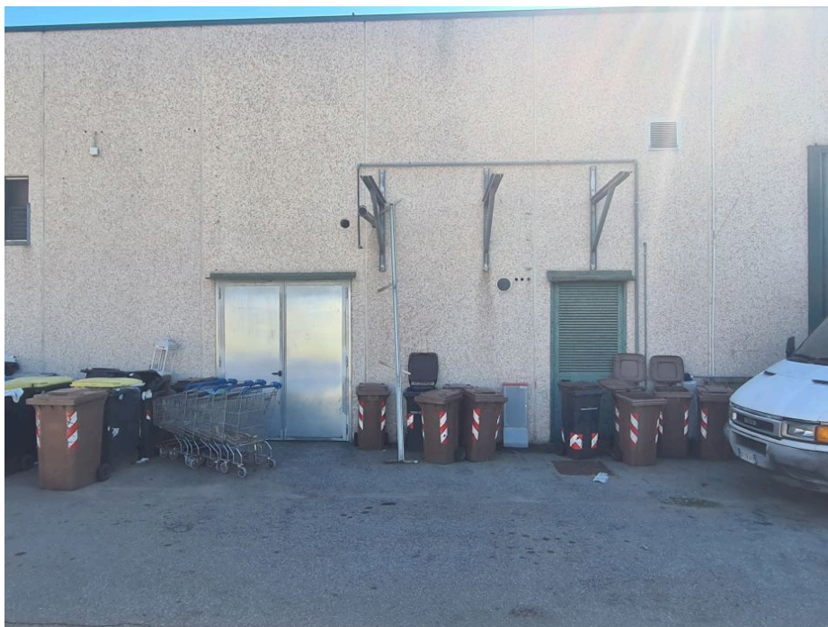
Foto alla data del sopralluogo (02/07/2026)
