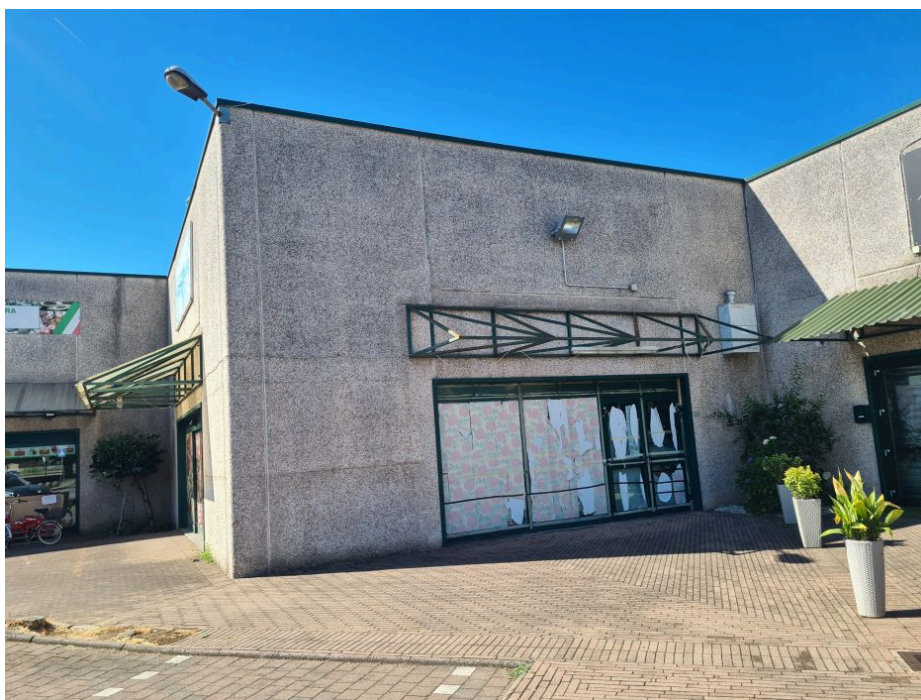
Foto alla data del sopralluogo (02/07/2026)
