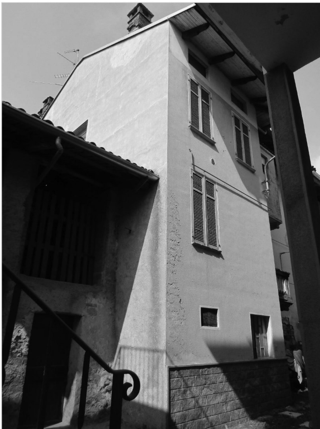
Fabbricato oggetto di stima – Prospetto Nord-Est
