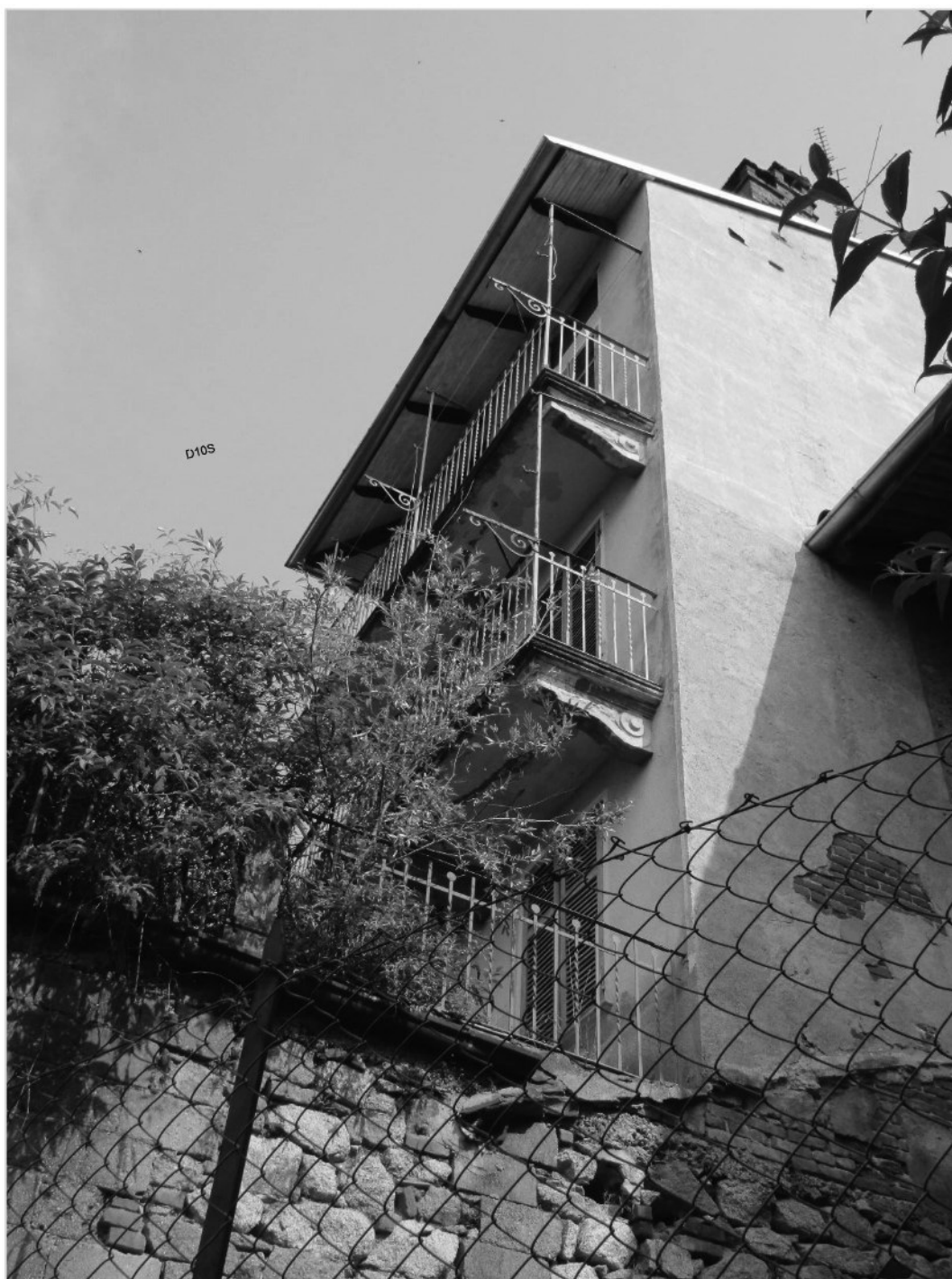
Fabbricato oggetto di stima – Prospetto Sud-Ovest
